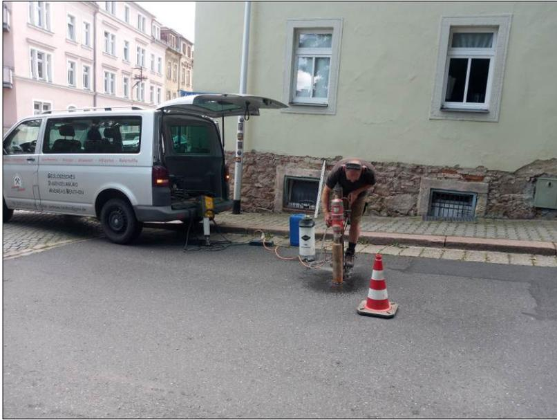
**Bild 3:** Durchörterung der Asphaltfläche für die RKS 5/24 im Kreuzungsbereich Zscheilaer Straße / Niederfähler Straße
