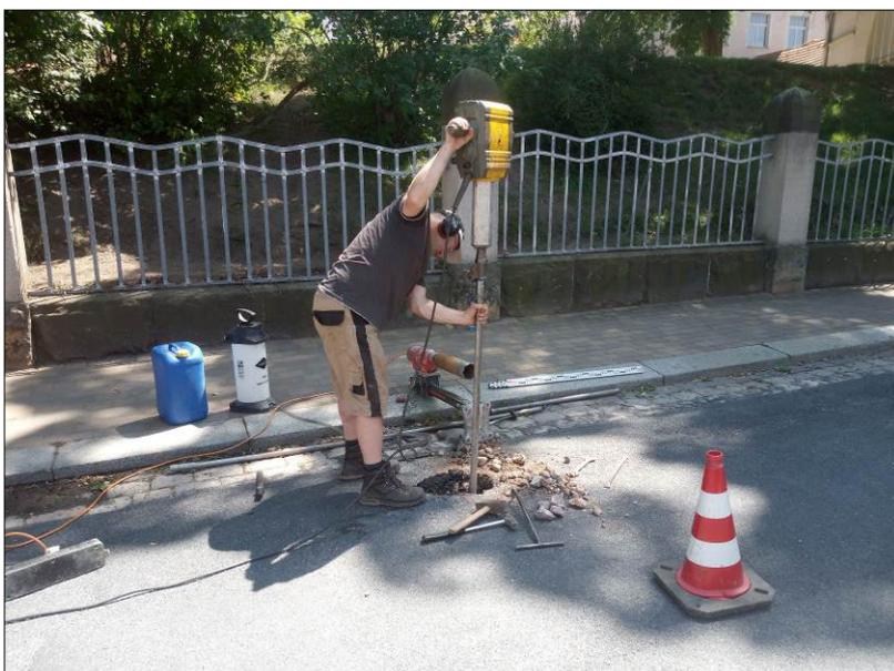
**Bild 5:** Abteufen der RKS 7/23 nach großflächigem Aufbruch der Asphaltfläche und darunter befindlicher Pflasterdecke ,
