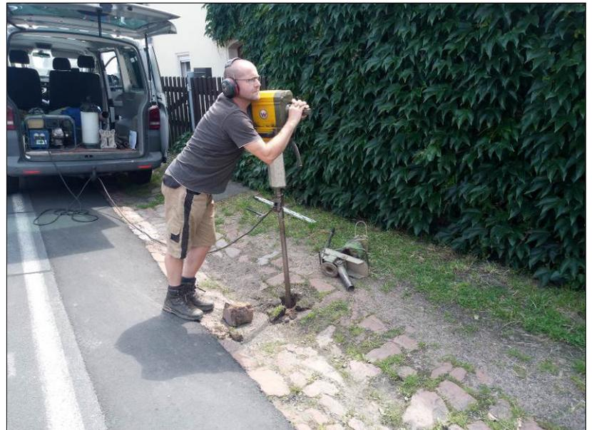
**Bild 4:** Durchführung der RKS 6/24 im Bereich der Vorbrücker Straße 4
