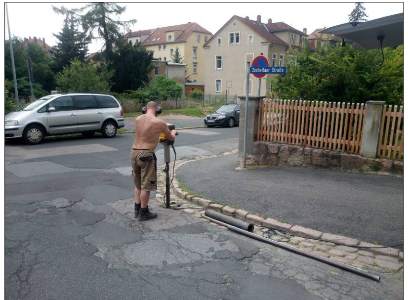
Bild 3: Abteufen der RKS 6/24 im Bereich Zscheilaer Straße 69 Foto: GIAB 10.07.2024
