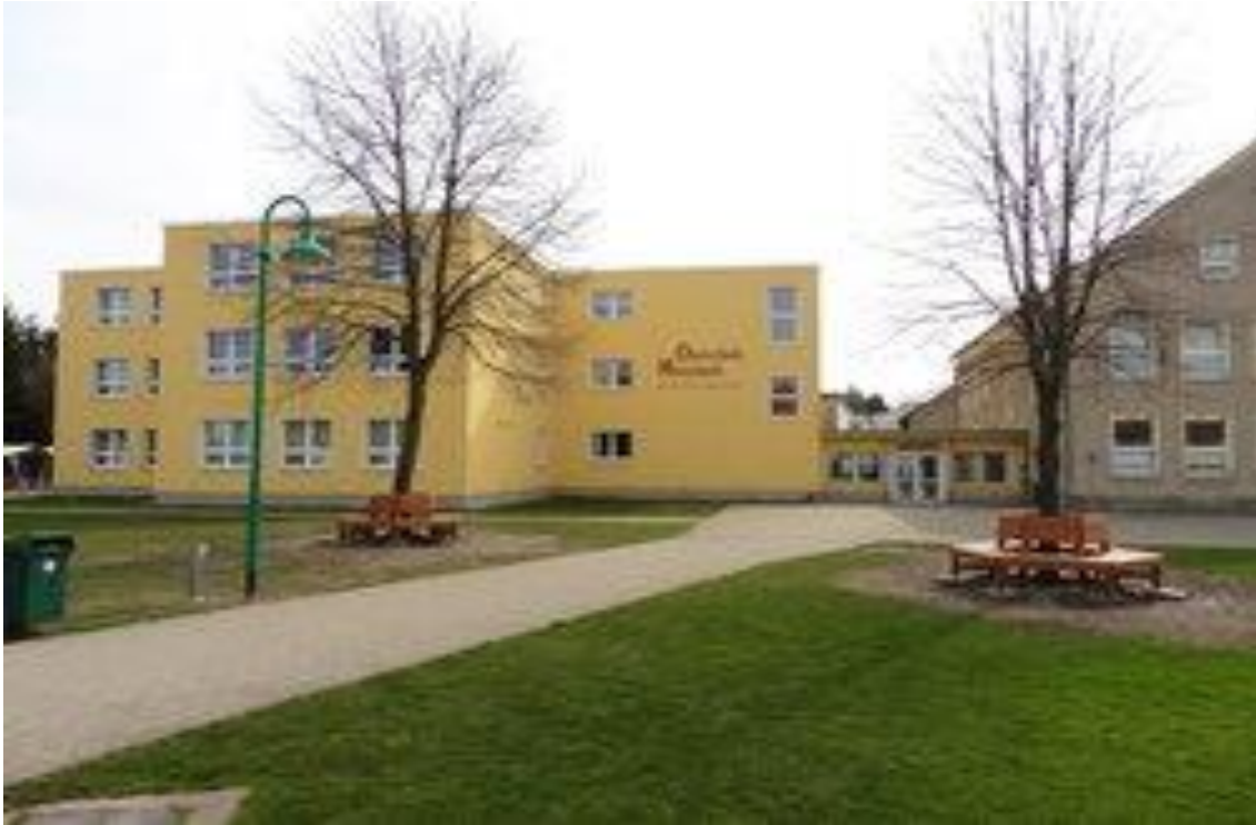
Bild 1: Schulgelände (Ortsbild prägender Altbau rechte Seite – späterer Neubau aus den 70er Jahren linke Seite)
