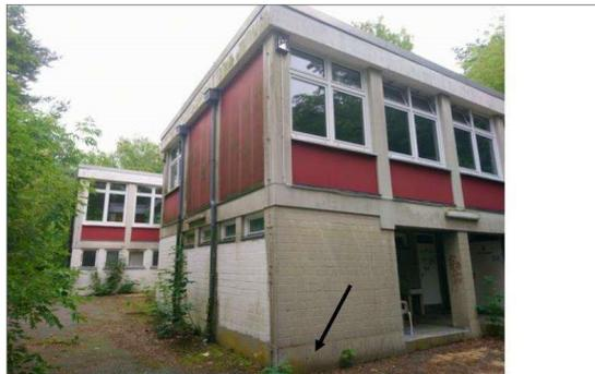
Foto 1: Ehem. Ferienheim – Ansicht aus nordwestlicher Richtung: Fassaden-Verkleidung aus roten großformatigen (Probe P12) und Sockelblende aus grauen kleinformatigen (Pfeil), verschraubten Asbestzement-Platten.
