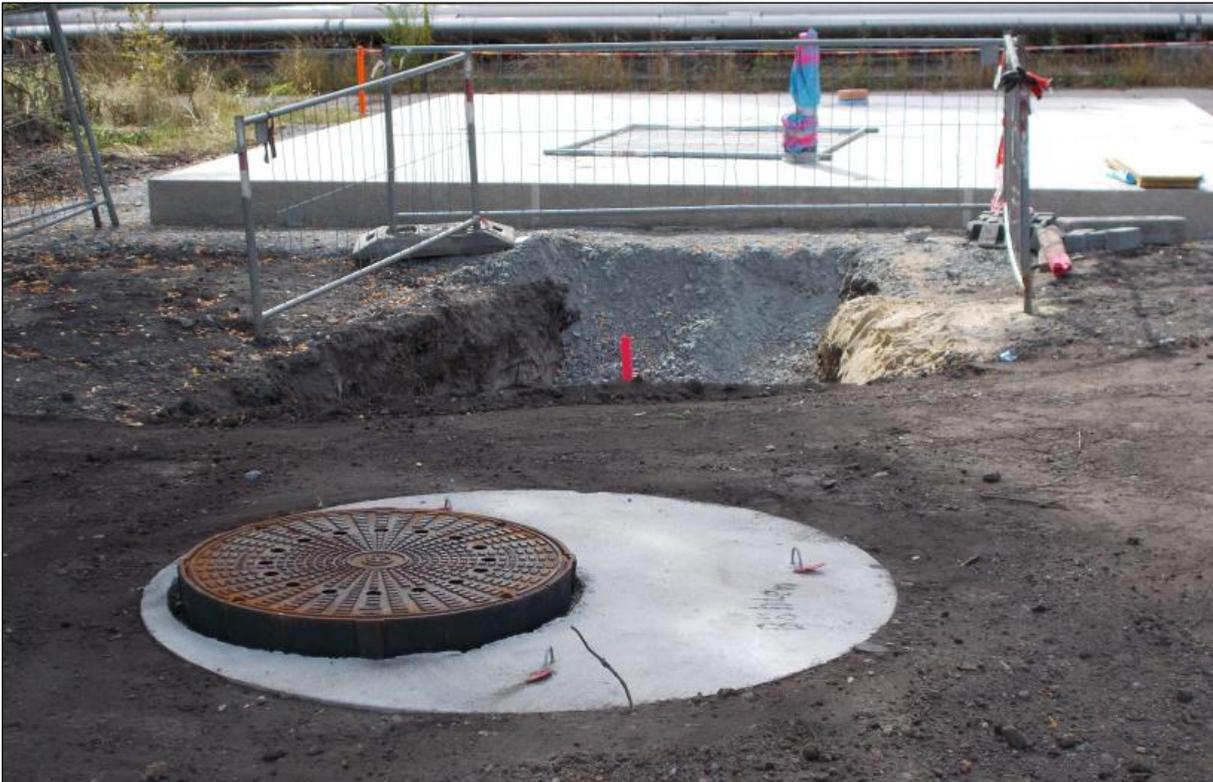
**Abbildung 7:** Aufnahme der Bodenplatte GWRA (Bauzustand) mit neu hergestelltem Schacht AS01 im Vordergrund und erkennbaren Durchführungen (DN 250)
