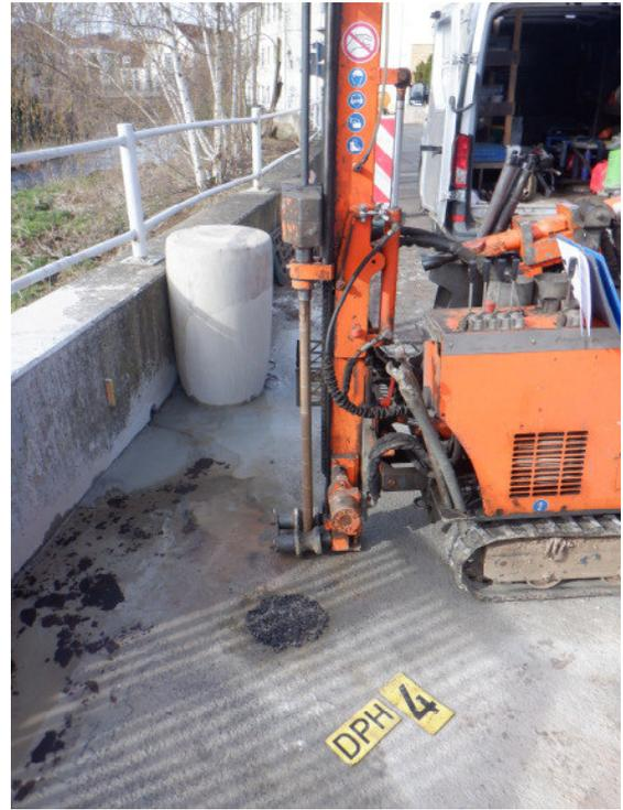
Abb. 2: Verschluss – Z 1 und Durchführung DPH 4
