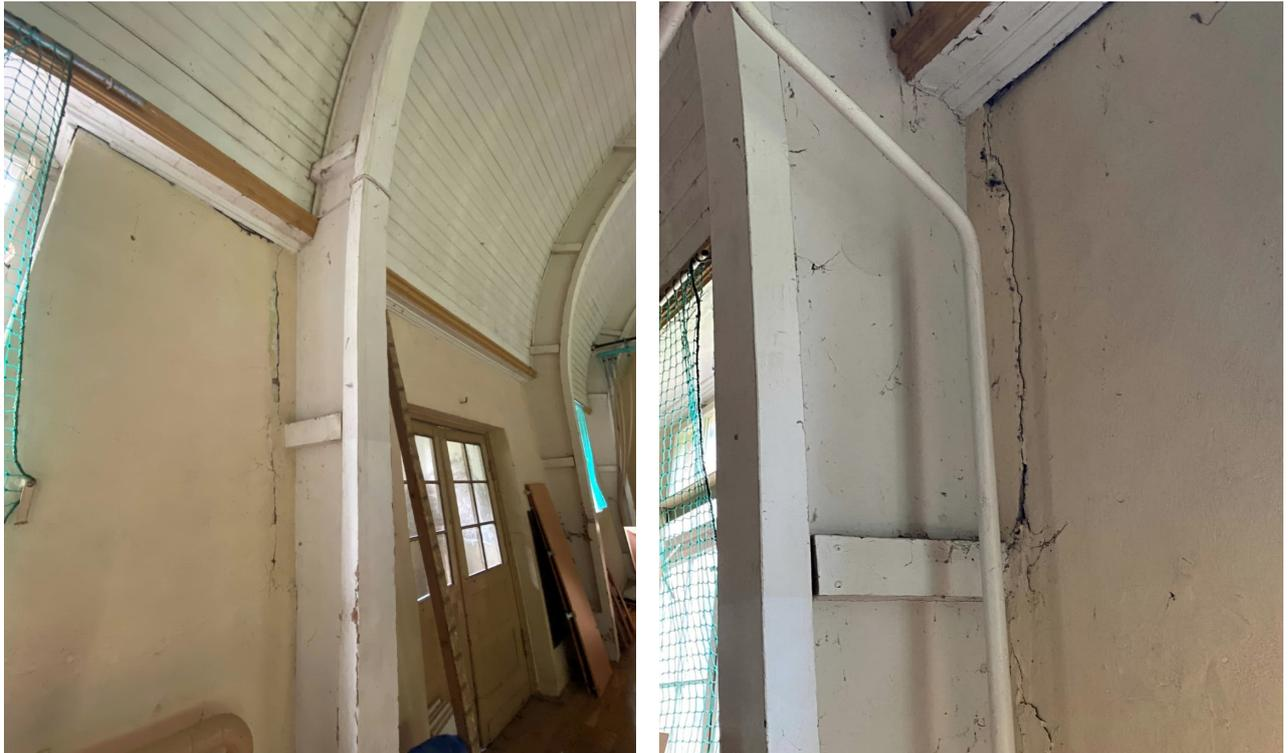
Abrisse zwischen Bodenbindern und Anschlussmauerwerk erkennbar
