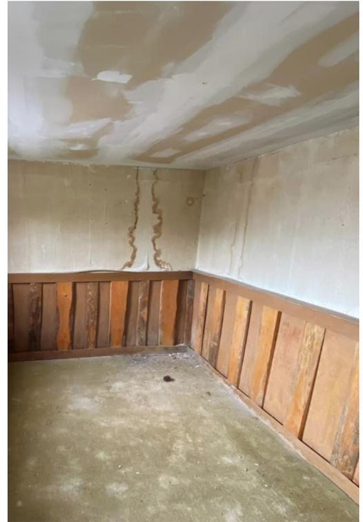
Feuchteschäden an Brettschalung und Putz erkennbar
