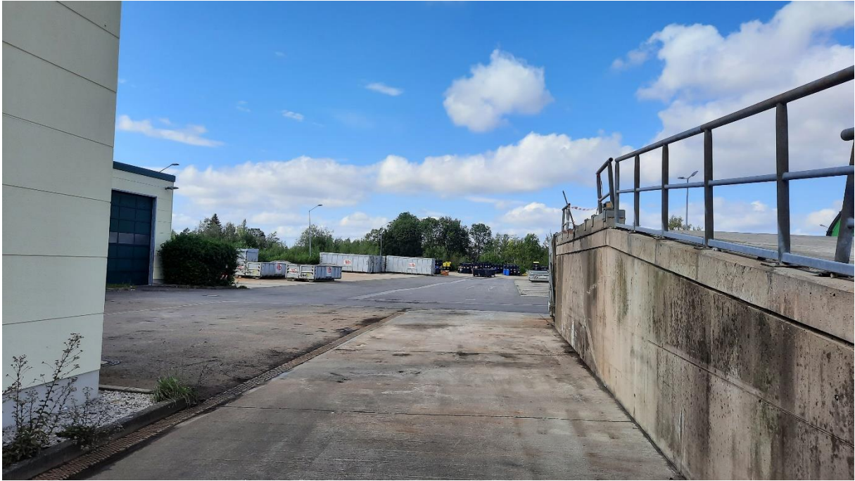
Abbildung 19 Ansicht Rampe seitlich
