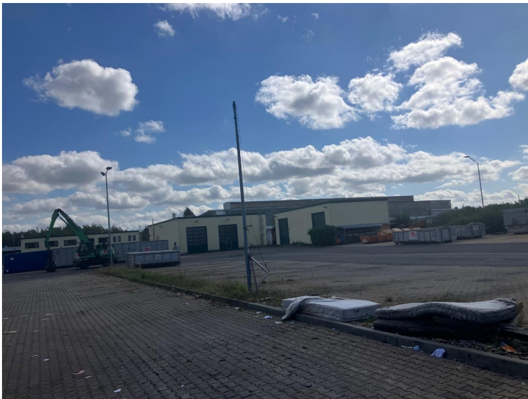
Abbildung 10 Ehemaliger Parkplatz Fuhrpark, Bick auf Verwaltungsgebäude/ Werkstatt Blickrichtung Süd-Ost
