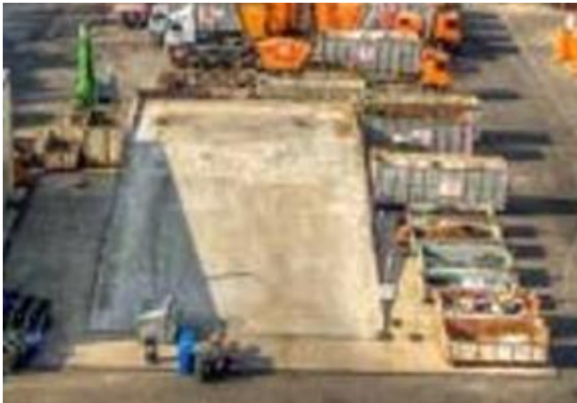
Abbildung 17 Luftbild Rampe ca. 34x13 m, Fläche ca. 450 m 2
