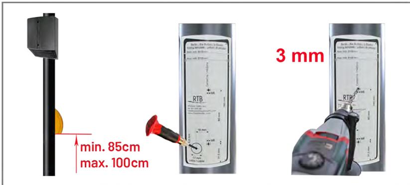
3. Nach Schablone 5mm /12mm Löcher bohren. In 5mm- Löcher mit M6 Gewinde schneiden und die Schablone abziehen.
