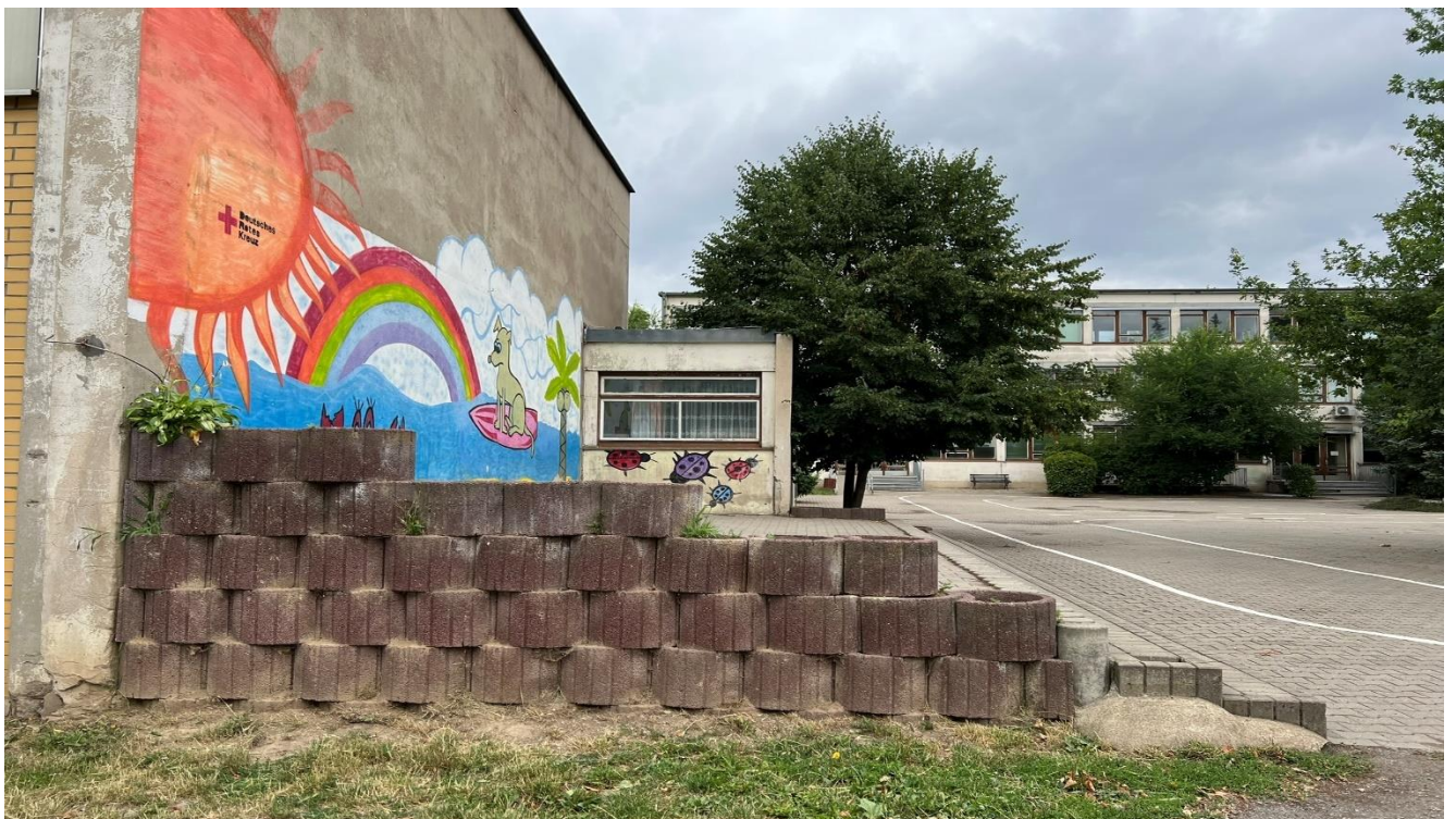
Sporthalle/ Schulhof, Blick von Süden
