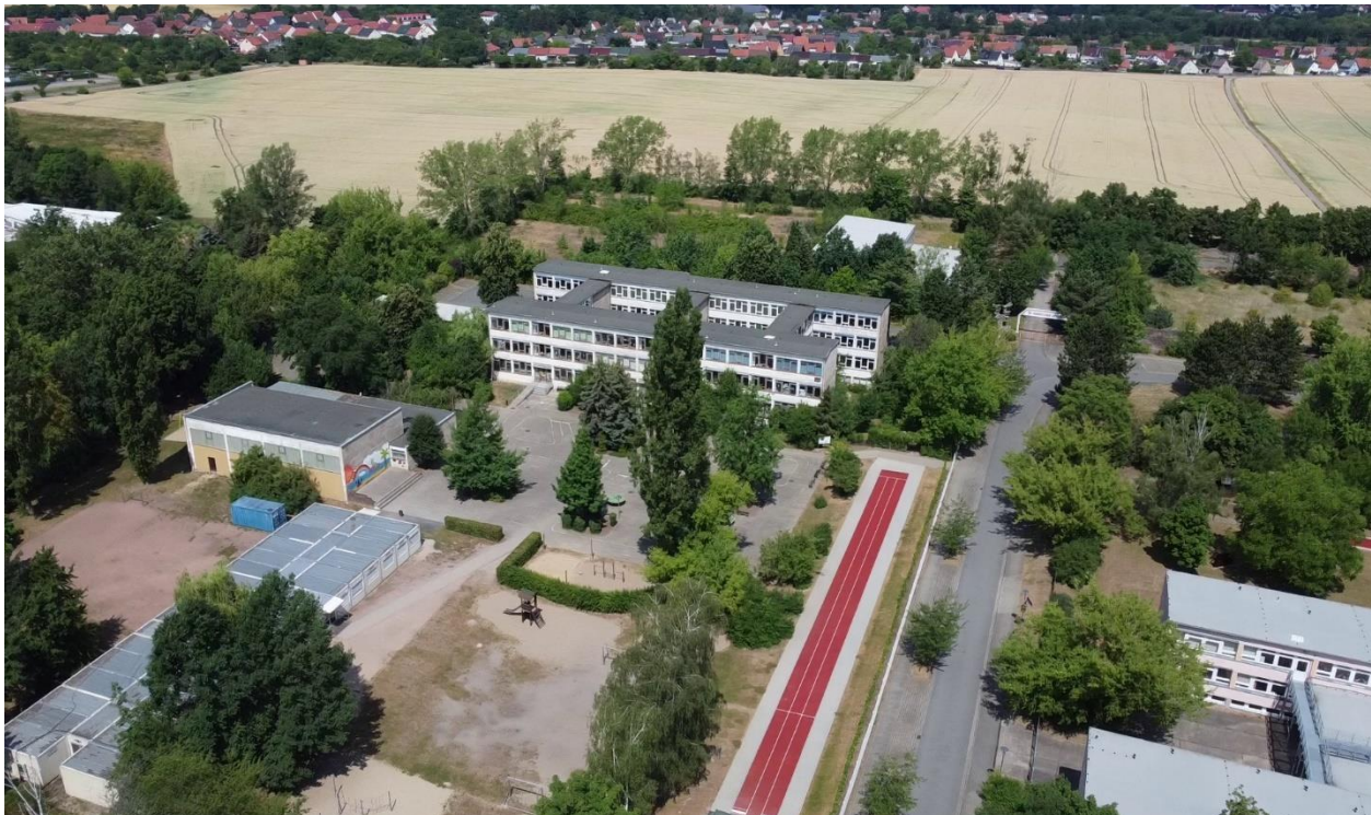
Draufsicht aus Richtung Süden mit Schulgebäude, Sporthalle, Pausenhof und Sportbereich, Container im Vorfeld beräumt
