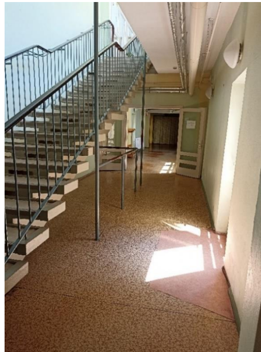
KG Treppe mit Unterlaufschutz Zugang Innenhöfe
