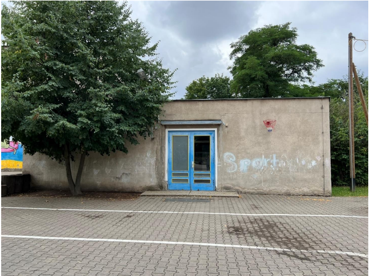
Sporthalle Zugang Ostfassade
