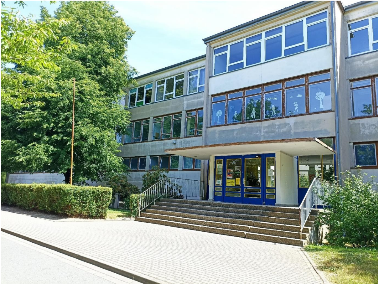
Bisheriger Zugang Schule Nordfassade
