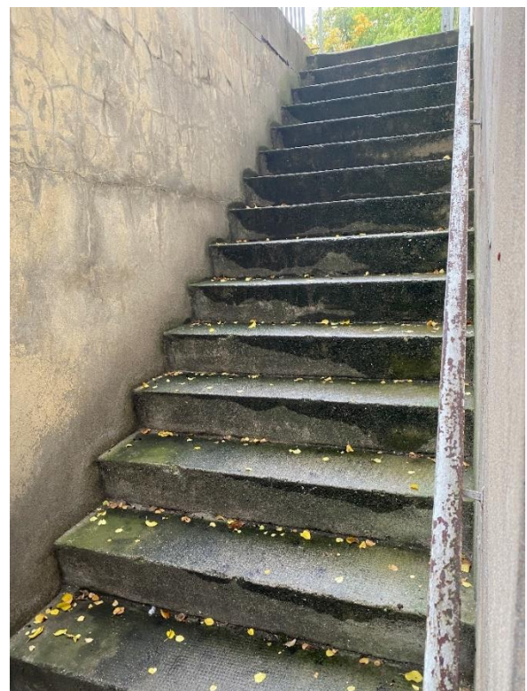
Keller Außentreppe Südfassade
