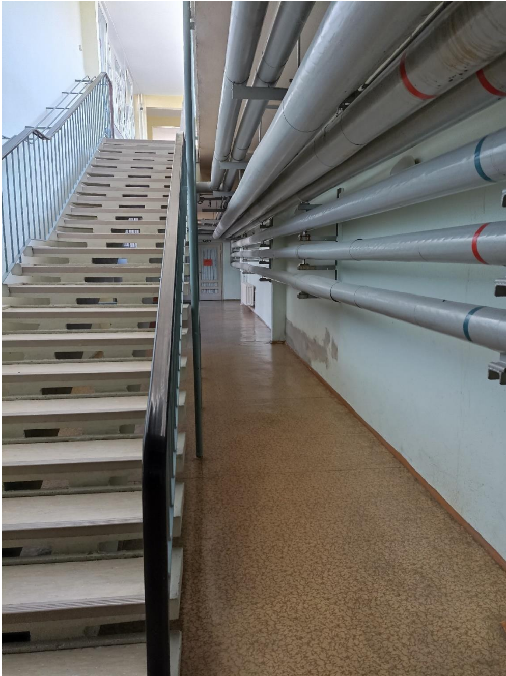
Schulgebäude Kellergeschoss Treppenaufgang
