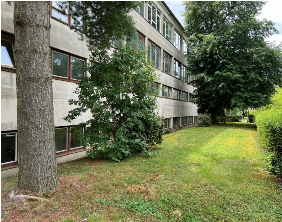
Geländesituation zum Gebäude Nordfassade
