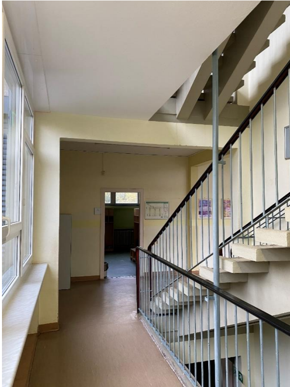
Treppenanlage mit Geländer
