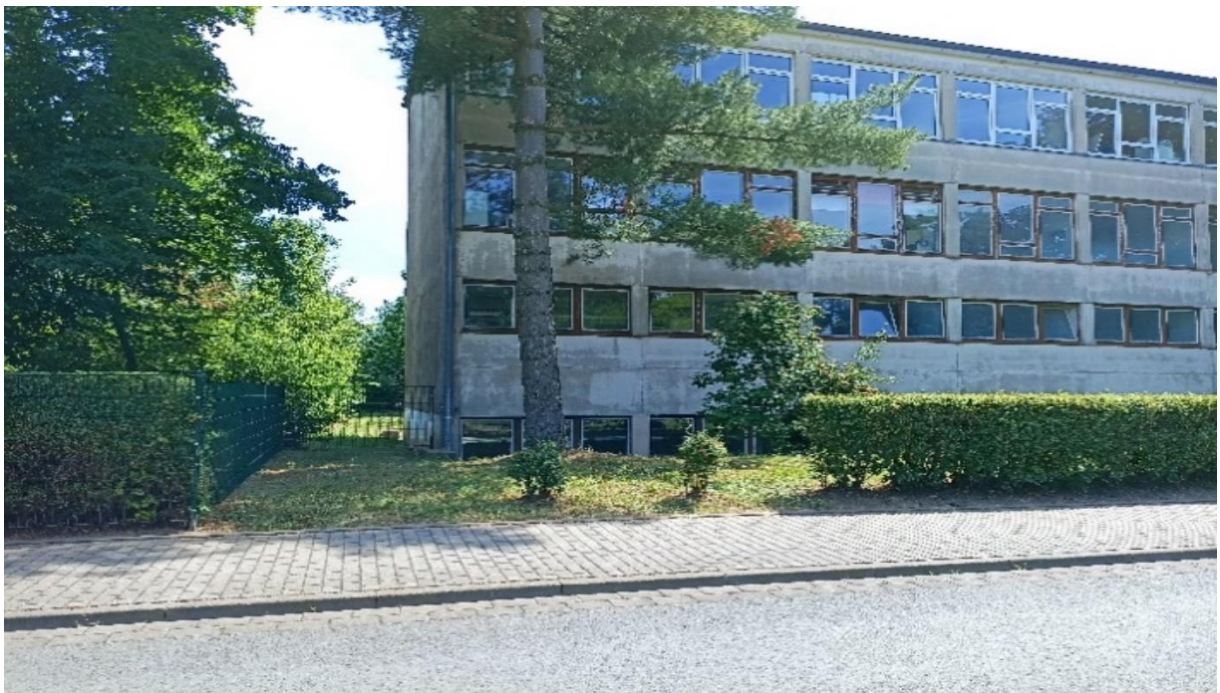
Nordfassade mit 4 Geschossen UG bis 2. OG
