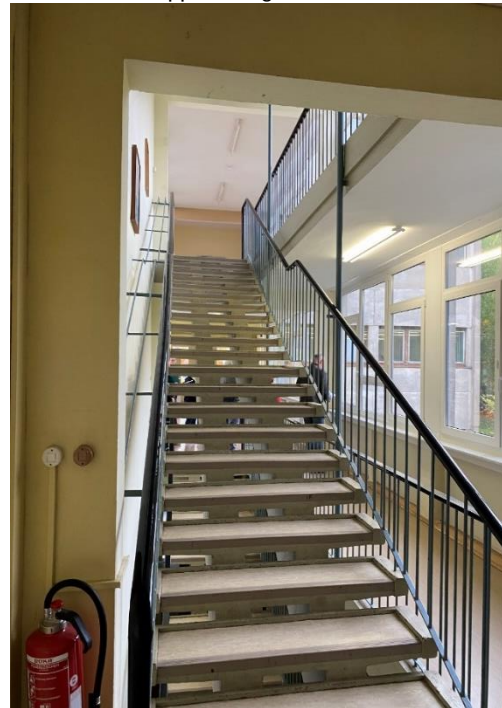
Schule, EG, Treppenanlage
