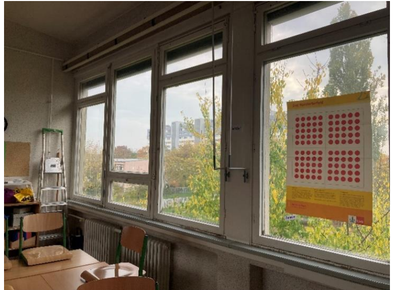
Fenster Hort - Verbund Klassenzimmer, Fenster mit Sonnenschutz
