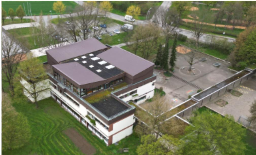
Im Zuge der Baumaßnahme wird das bestehende Gebäude weitgehend entkernt und anschließend energetisch saniert. Das aufgesetzte zweite Obergeschoß wird komplett abgebrochen und durch ein neues, größeres Geschoß in Holzbauweise (Holzständer- und Massivholzwände, CLT Decken) mit drei aufgesetzten Sheddächern ersetzt.
