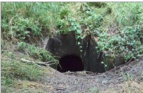
Foto 23: Unterquerung mit unterdimensioniertem Maulprofil, und Sedimentablagerungen
