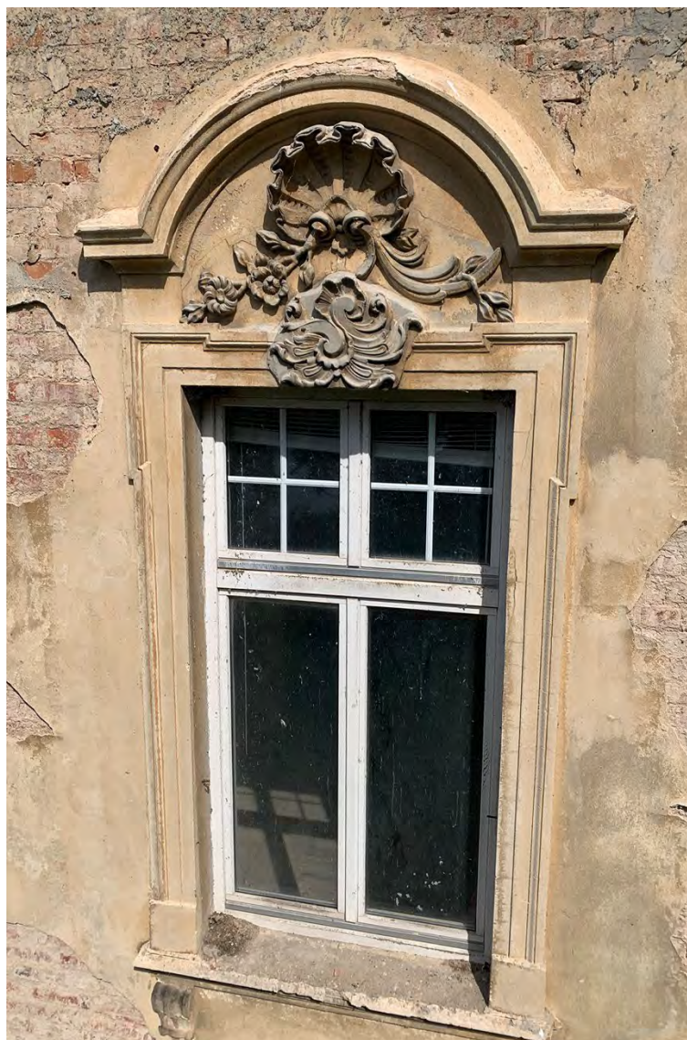
Abb. 33 Kernbau, Südseite, Obergeschoss, Fenster mit Bekrönung, Juni 2017
