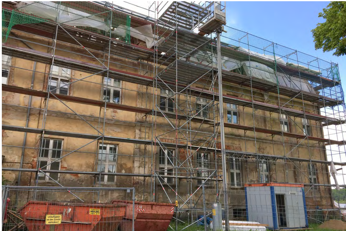
Abb. 68 Nordflügel, Ansicht von Nordosten, Juni 2017
