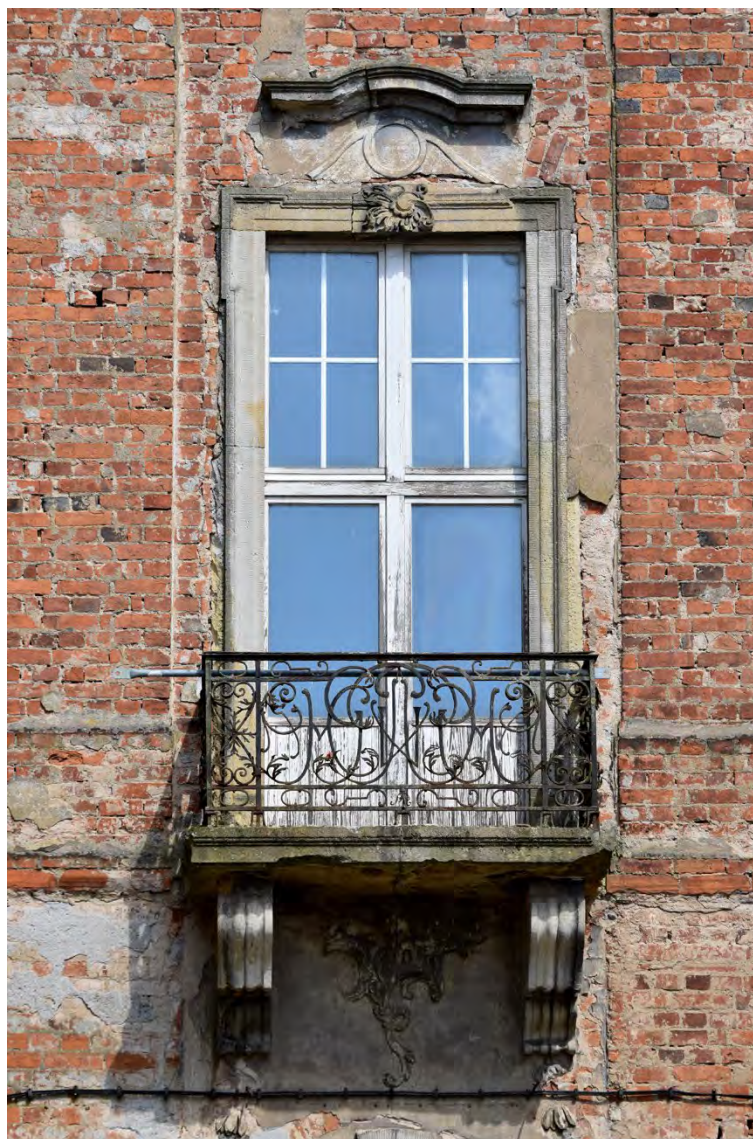
Abb. 46 Kernbau, Westseite; Mittelrisalit, Obergeschoss, Balkontür, Juni 2017
