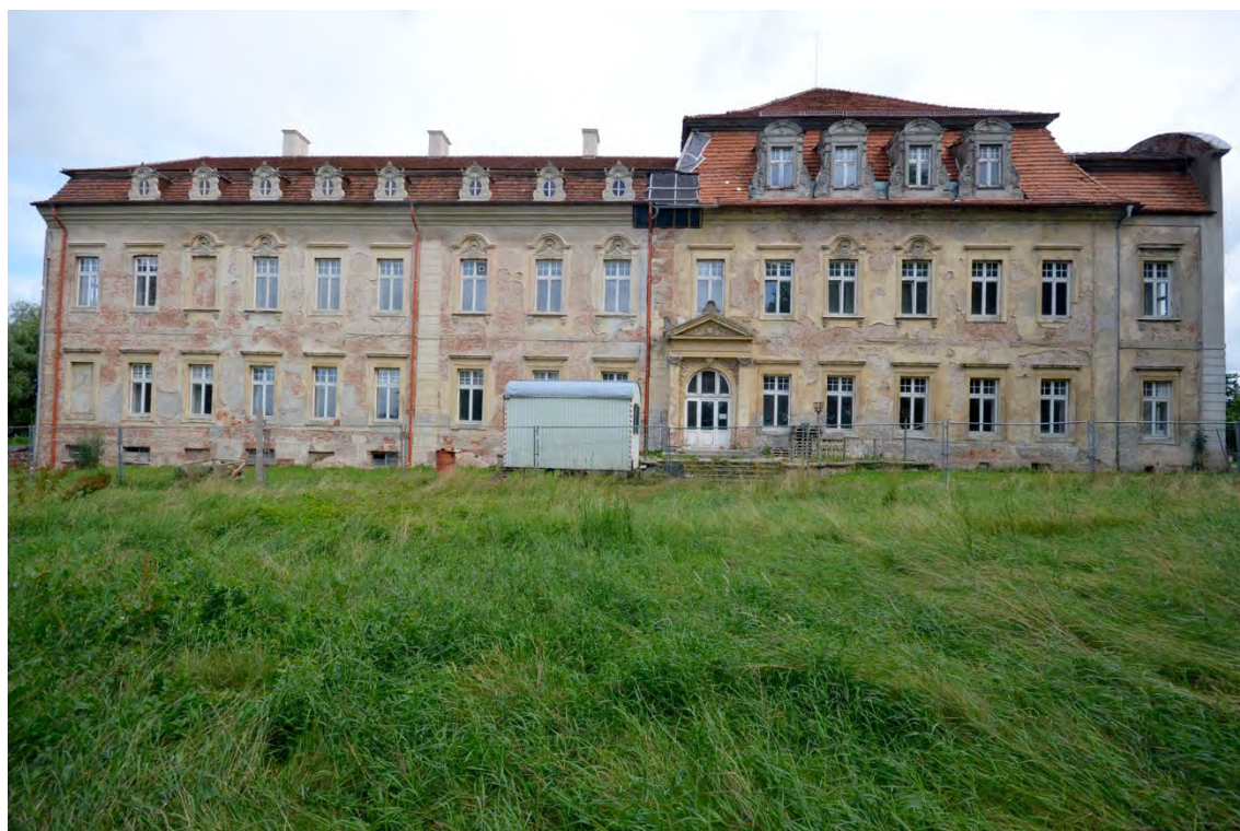
Abb. 26 Ansicht von Süden, Juni 2017
