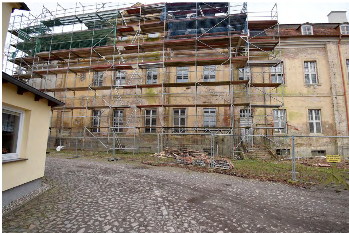
Abb. 69 Kernbau, Nordseite, Juni 2017
