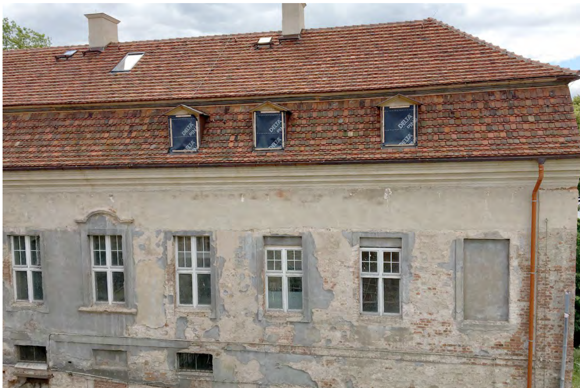
Abb. 49 Südflügel, Nordseite, Ober- und Dachgeschoss, Juni 2017
