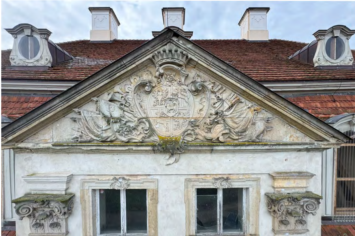
Abb. 12 Kernbau, Ostseite; Mittelrisalit, Dachgeschoss, Fenster und Fassadenschmuck, Januar 2025
