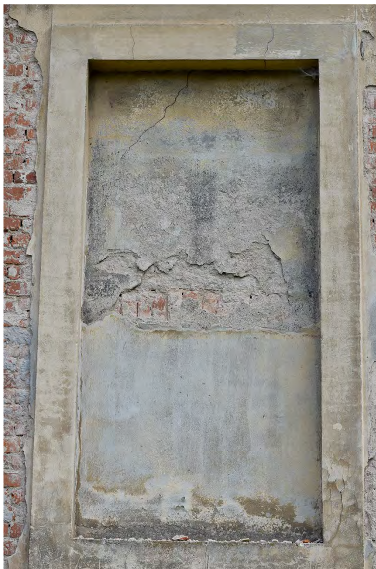
Abb. 36 Südflügel, Südseite; Erdgeschoss, Blindfenster, Juli 2019
