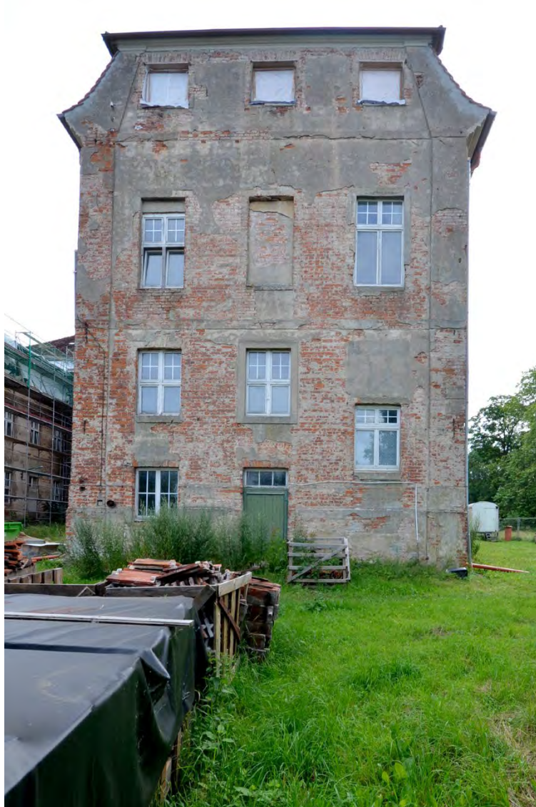
Abb. 55 Südflügel, Ansicht von Westen, Juni 2017
