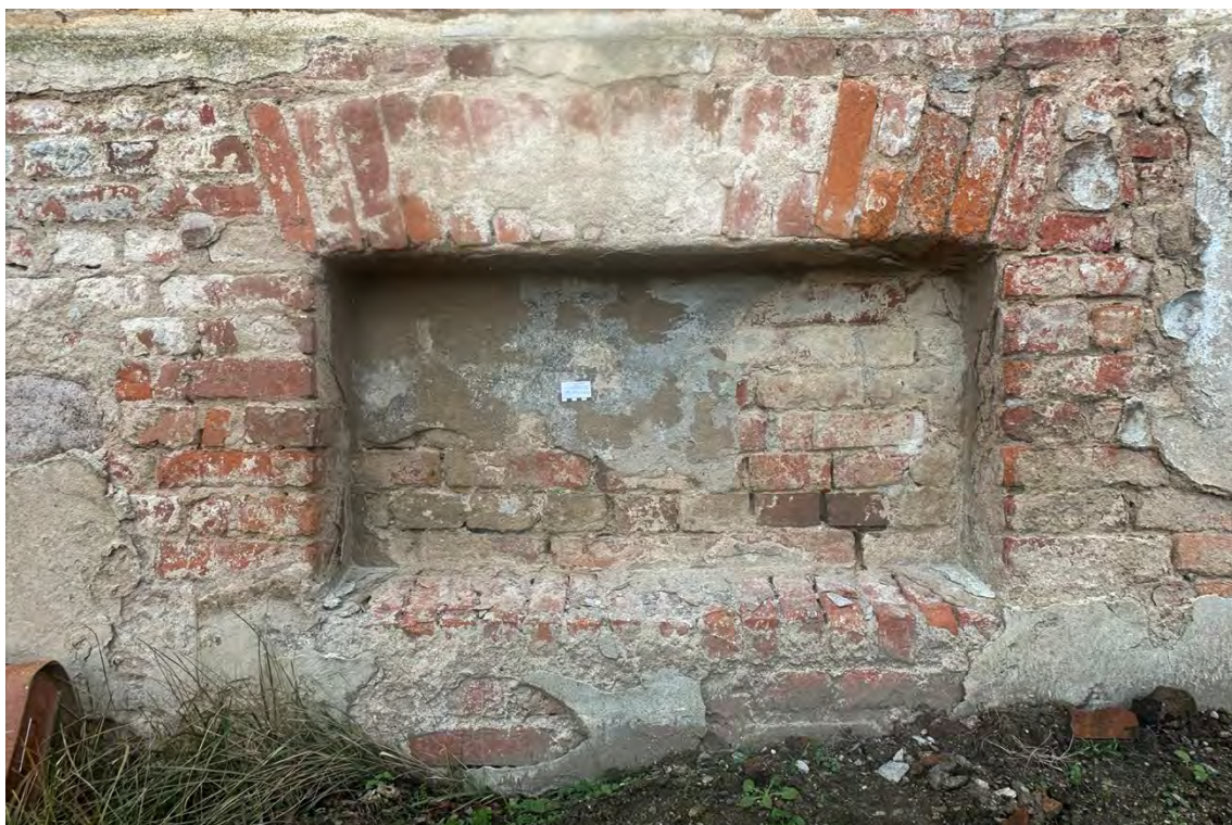
Abb. 39 Südflügel, Südseite. Kellergeschoss, Blindfenster, Juni 2017
