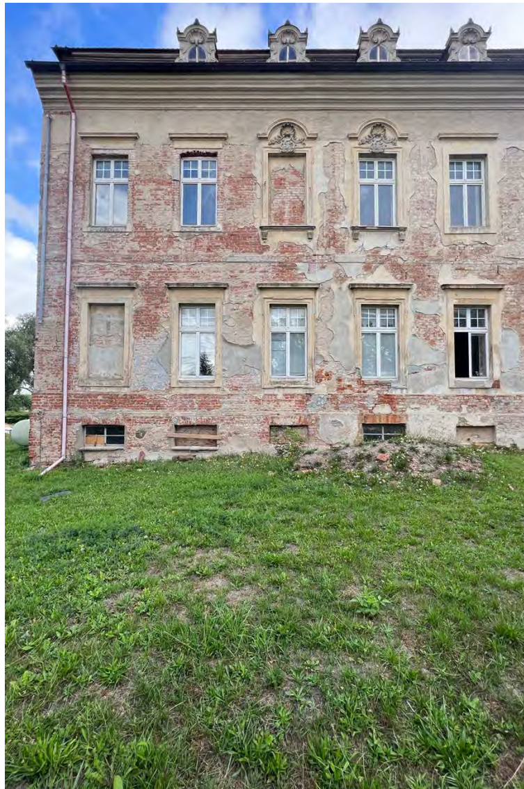
Abb. 29 Kernbau, nördlicher Eckrisalit, Juli 2019
