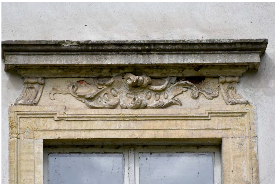
Abb. 21 Kernbau, Ostseite; nördlicher Eckkrisalit, Obergeschoss, Fensterbegrönung, Juni 2017
