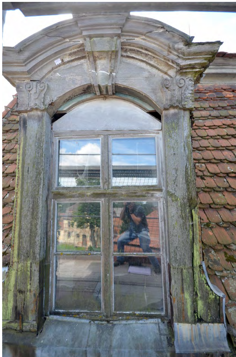
Abb. 75 Kernbau, Nordseite, Dachgaube, Fenster, Juni 2017
