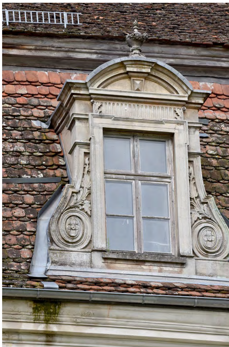
Abb. 17 Kernbau, Ostseite, nördliche Dachgaube, Juni 2017
