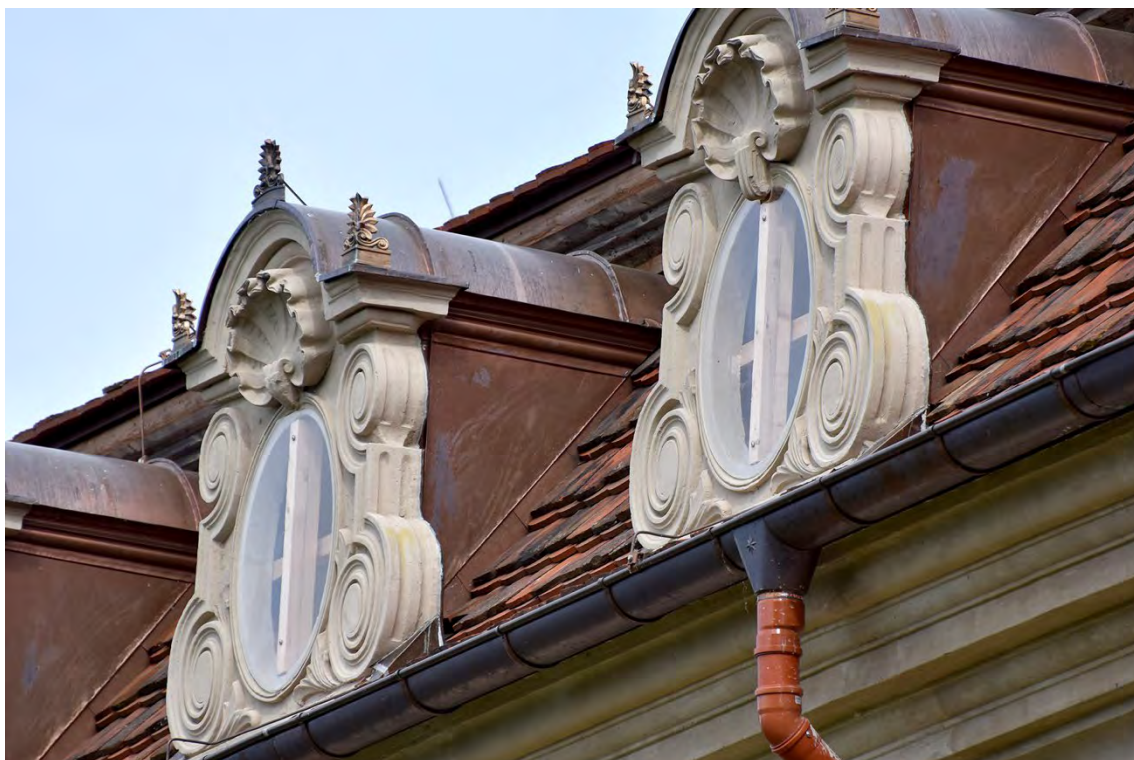
Abb. 38 Südflügel, Südseite; Dachgauben, Juni 2017
