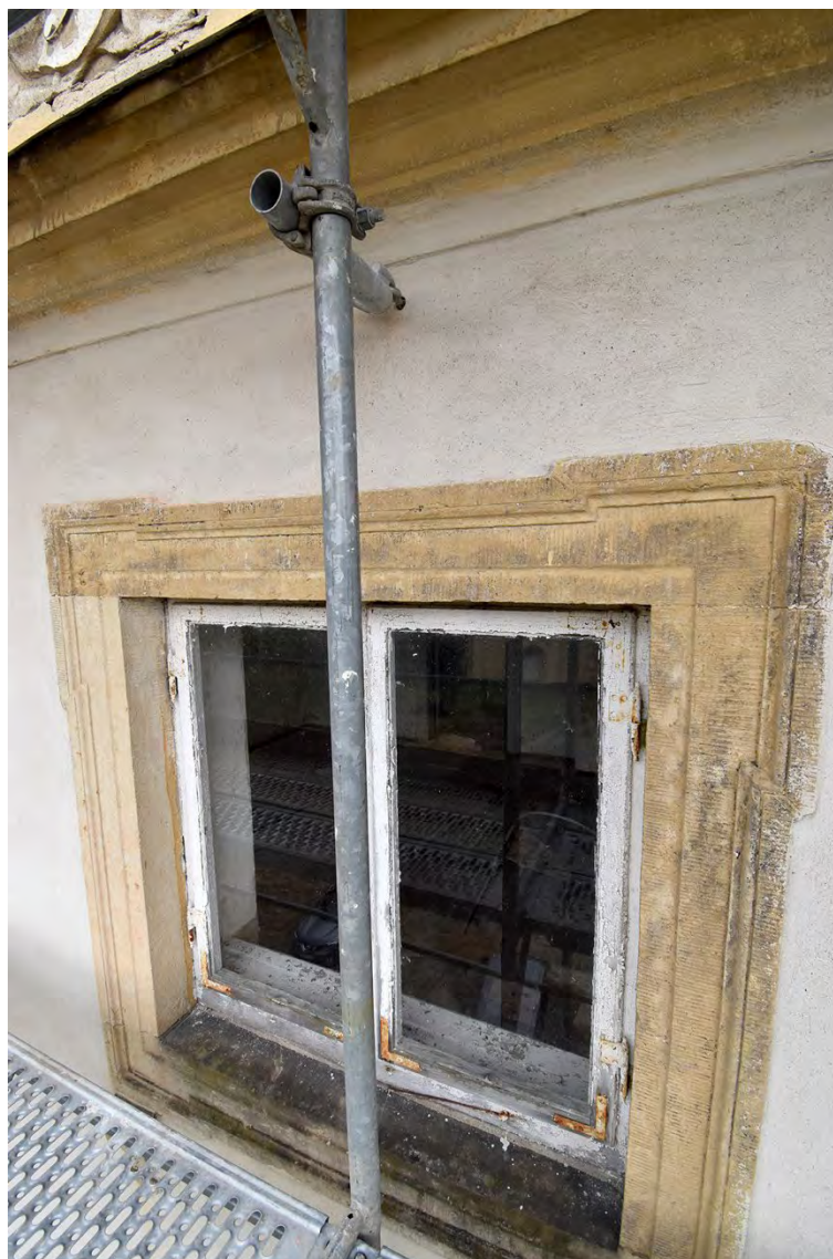
Abb. 15 Kernbau, südlicher Eckrisalit, Dachgeschoss, Fenster, April 2018
