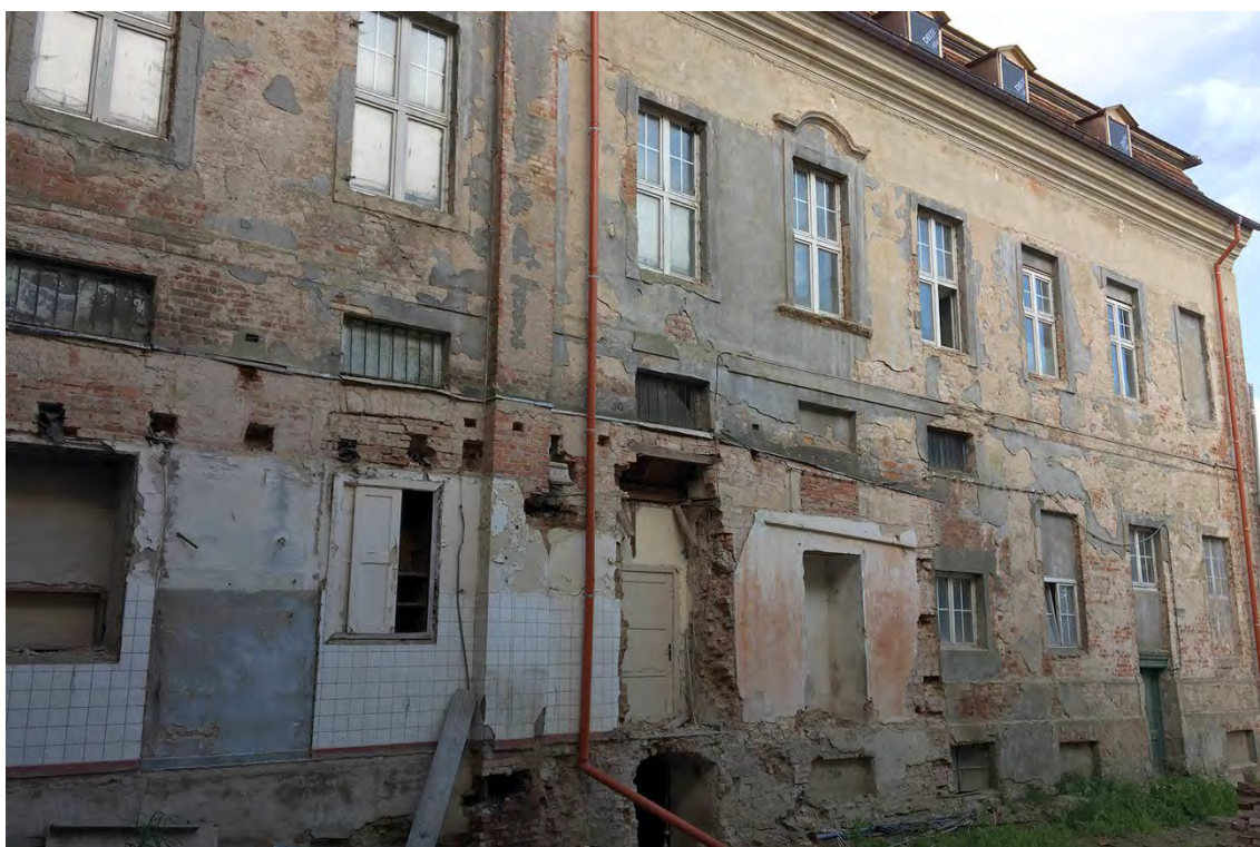
Abb. 50 Südflügel, Nordseite, Juni 2017
