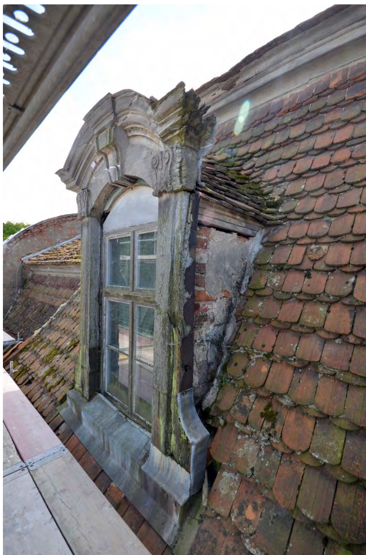
Abb. 74 Kernbau, Nordseite; Dachgaube, Juni 2017
