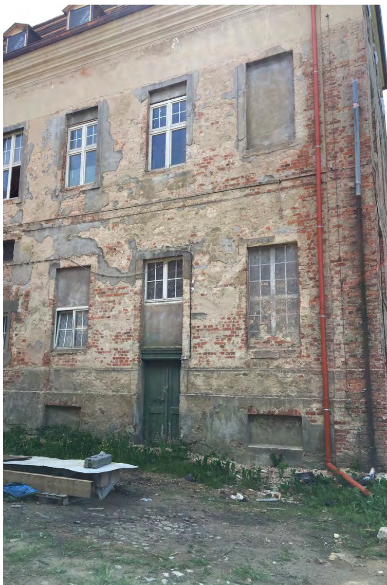
Abb. 51 Südflügel, Nordseite, westlicher Abschluss, Juni 2017
