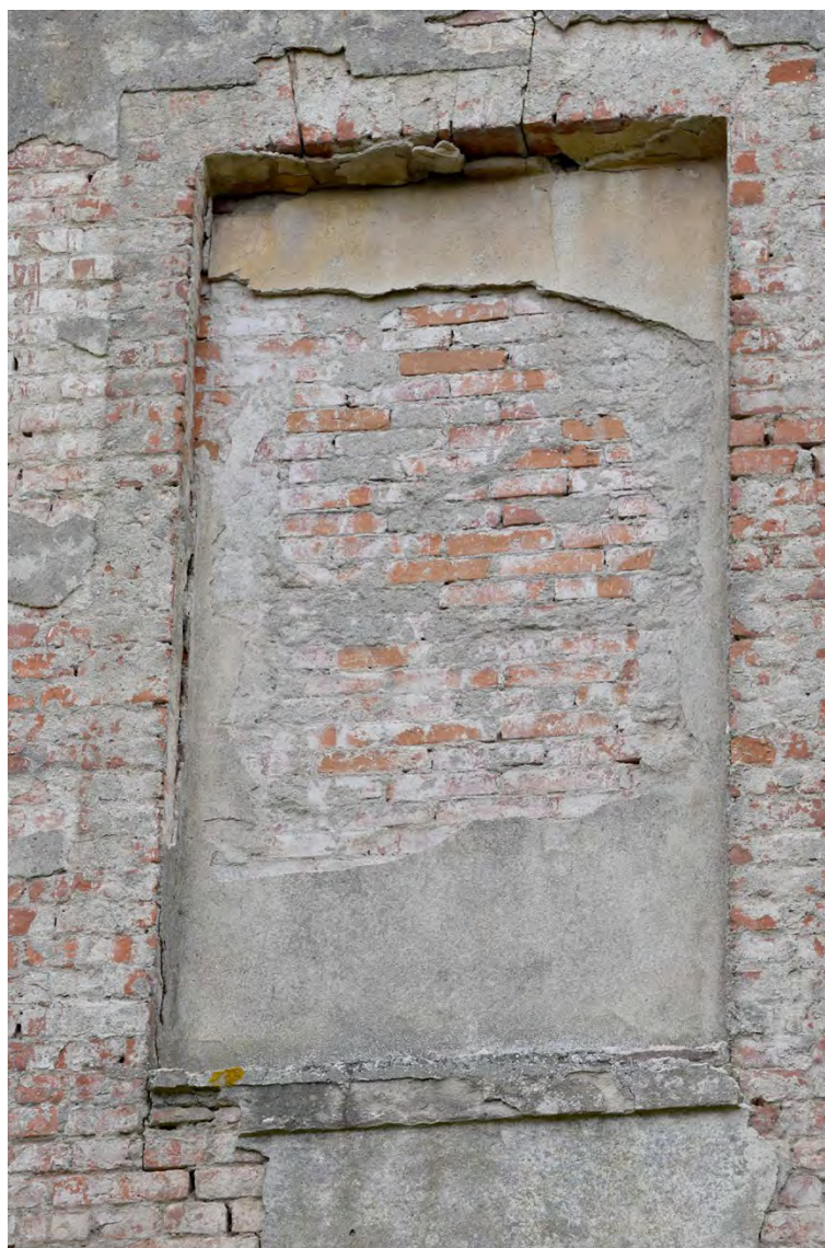
Abb. 57 Südflügel, Westseite, Obergeschoss, Blindfenster, Juni 2017
