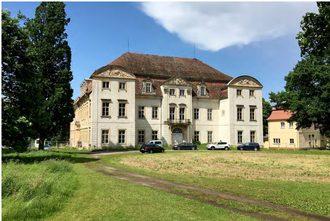
Abb. 7 Ansicht von Südosten (Kernbau), Juni 2017
