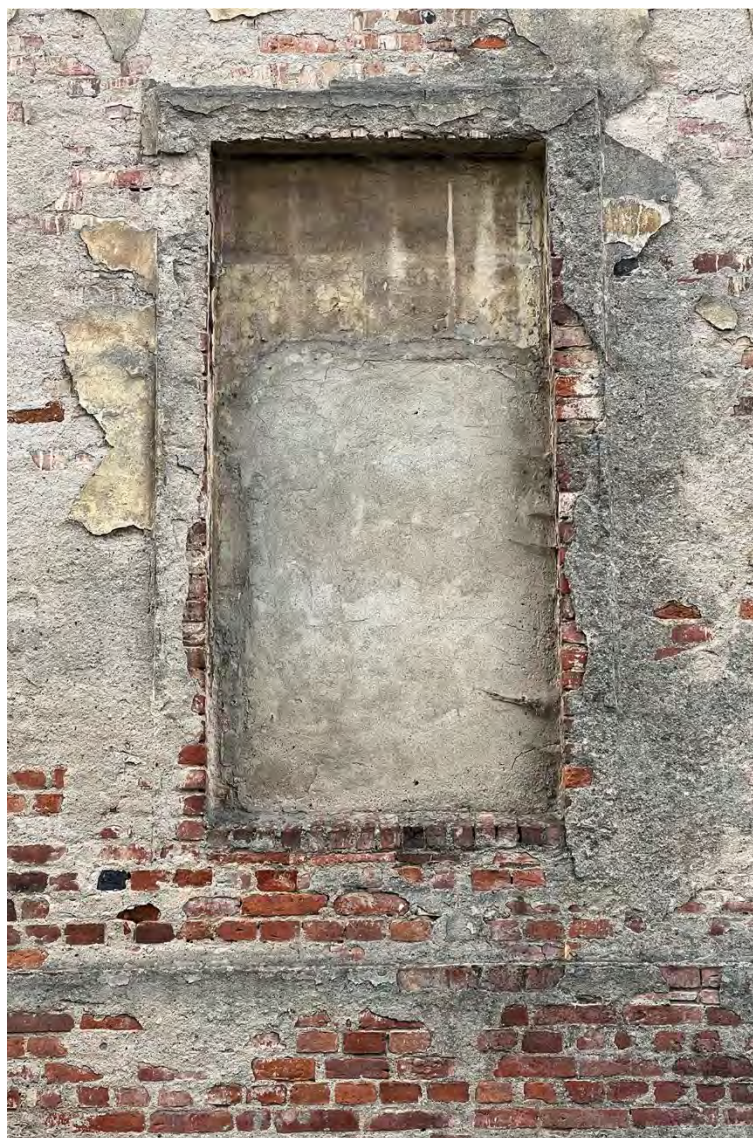
Abb. 76 Nordflügel, Nordseite, Erdgeschoss, Blindfenster, Juni 2017
