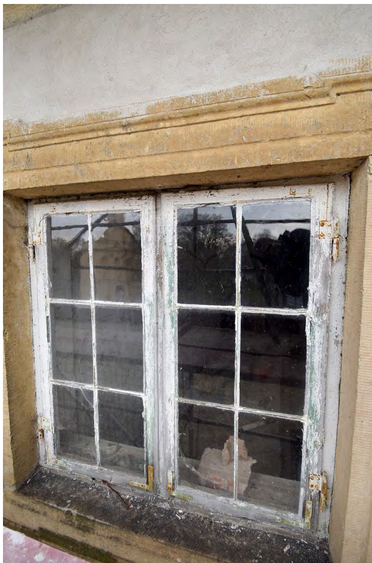
Abb. 16 Kernbau, nördlicher Eckrisalit, Dachgeschoss, Fenster, April 2018
