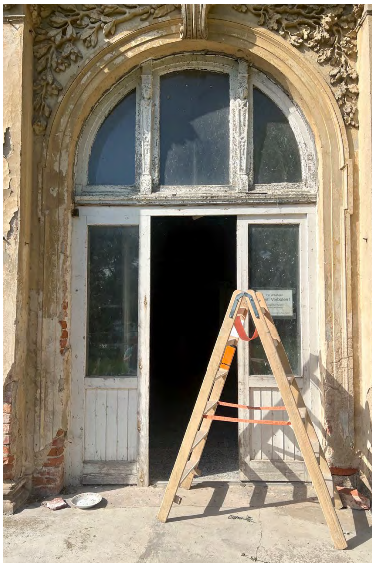
Abb. 32 Kernbau, Südseite, Tür, August 2023
