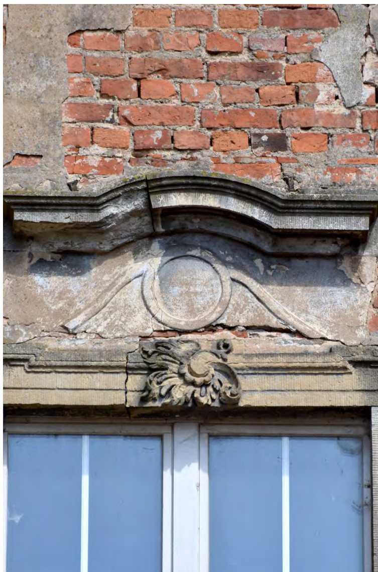
Abb. 47 Kernbau, Westseite; Mittelrisalit, Obergeschoss, Bekrönung der Balkontür, Juni 2017
