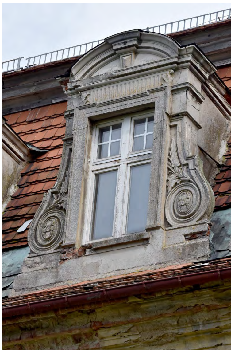
Abb. 37 Kernbau, Südseite; Dachgaube, Juni 2017
