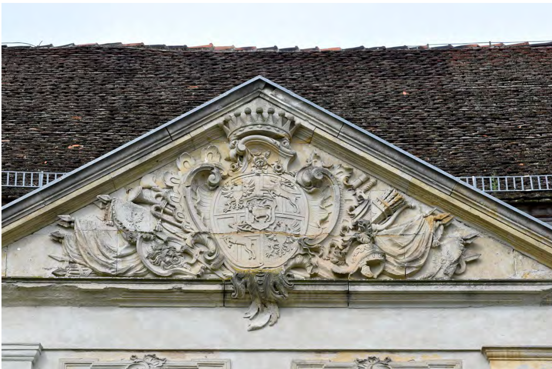
Abb. 13 Kernbau, Ostseite; Mittelrisalit, Dreiecksgiebel, Juni 2017
