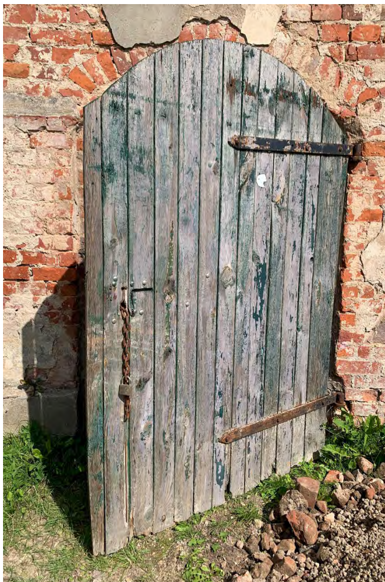
Abb. 63 Nordflügel, Westseite, Tür, Juni 2017
