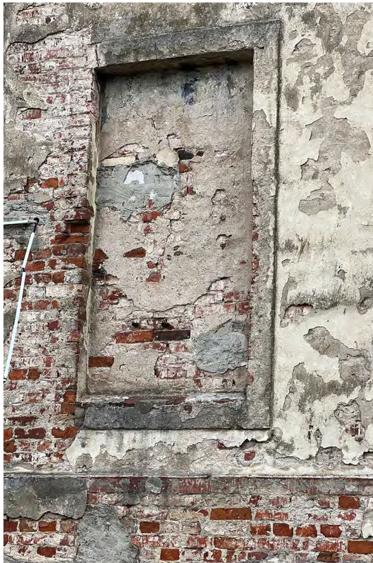
Abb. 65 Nordflügel, Westseite, Erdgeschoss, Blindfenster, September 2022
