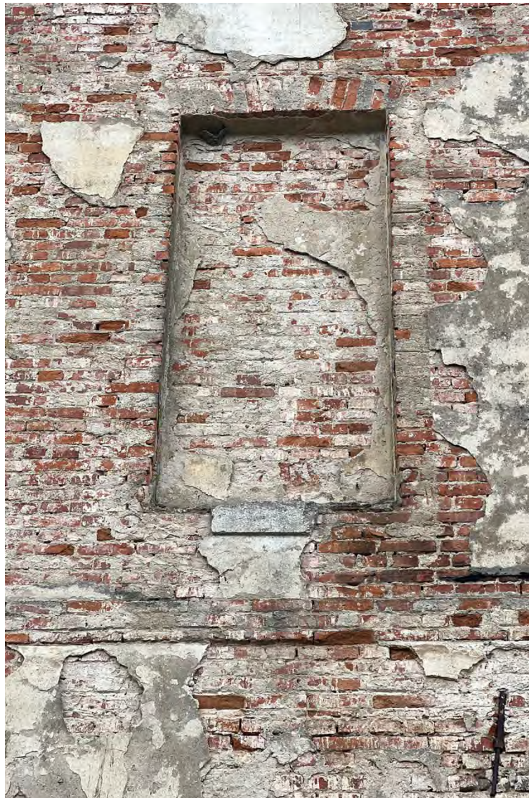
Abb. 64 Nordflügel, Westseite, Obergeschoss, Blindfenster, September 2022
