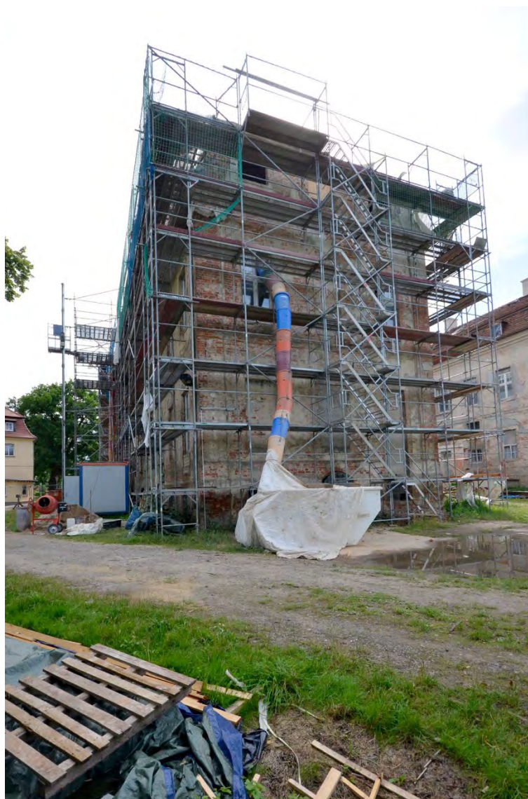
Abb. 61 Nordflügel, Ansicht von Westen, Juni 2017
