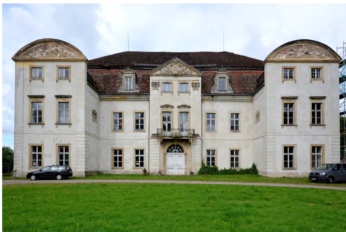
Abb. 8 Ansicht von Osten (Kernbau), Juni 2017
