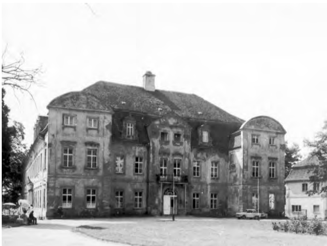
Abb. 6 Schloss und Marstall, Ansicht von Südosten, Foto 1960er Jahre
