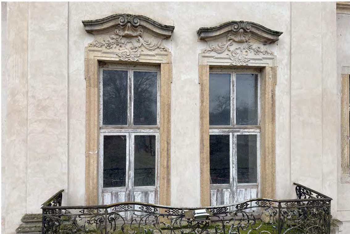
Abb. 11 Kernbau, Ostseite; Mittelrisalit, Obergeschoss, Fenster, Januar 2025
