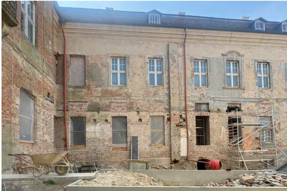
Abb. 52 Südflügel, Nordseite, Juli 2024
