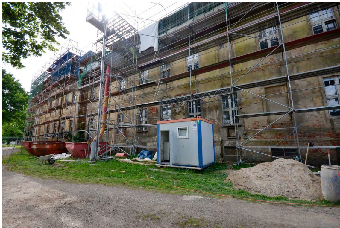
Abb. 66 Ansicht von Nordwesten, Juni 2017
