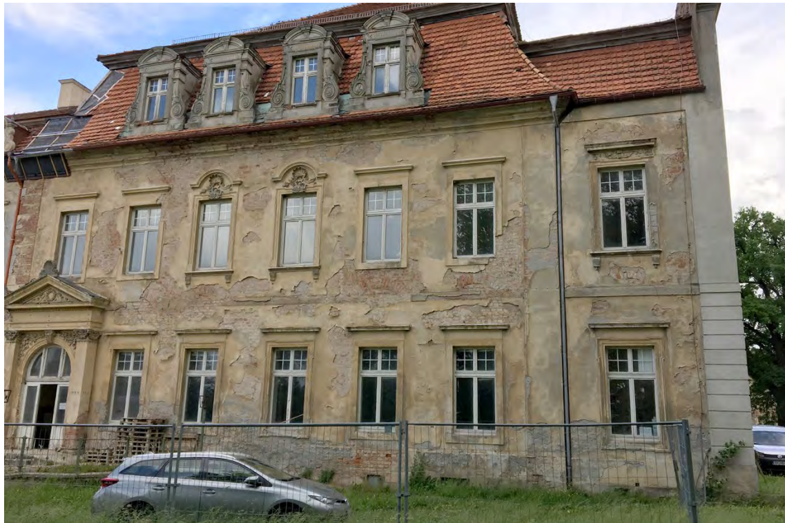
Abb. 27 Kernbau, Südseite, Juni 2017
