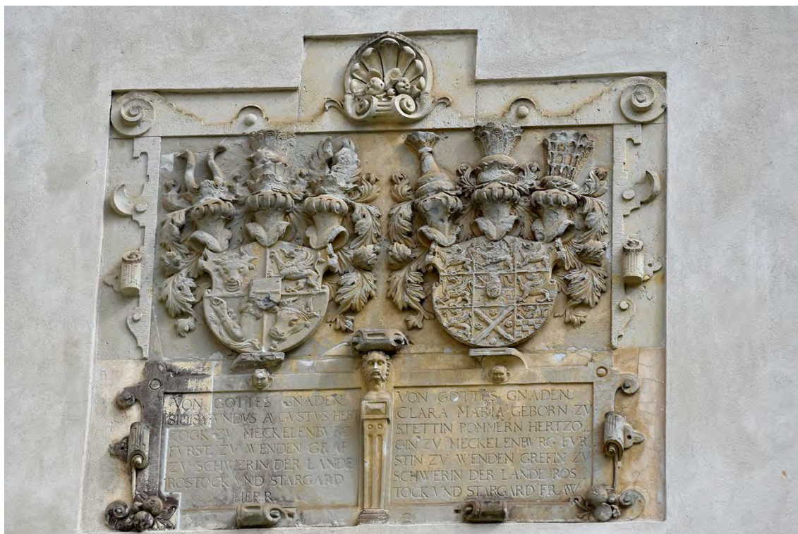
Abb. 23 Kernbau, Ostseite; südlicher Eckkrisalit, Wappentafel Südseite, Juni 2017
