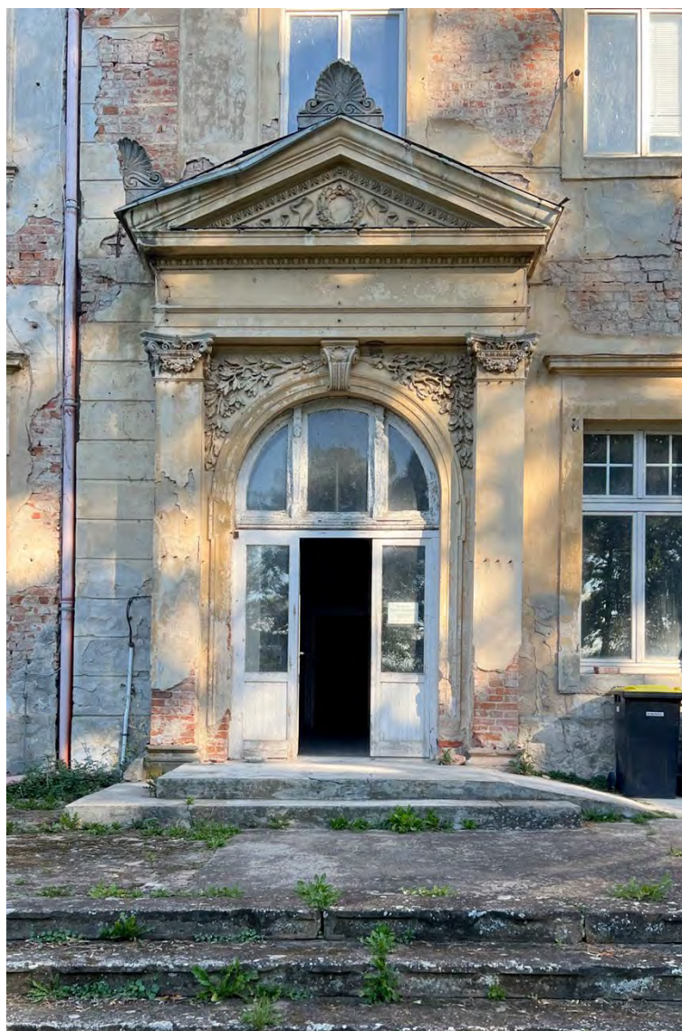
Abb. 31 Kernbau, Südseite, Eingangsbereich, September 2022
