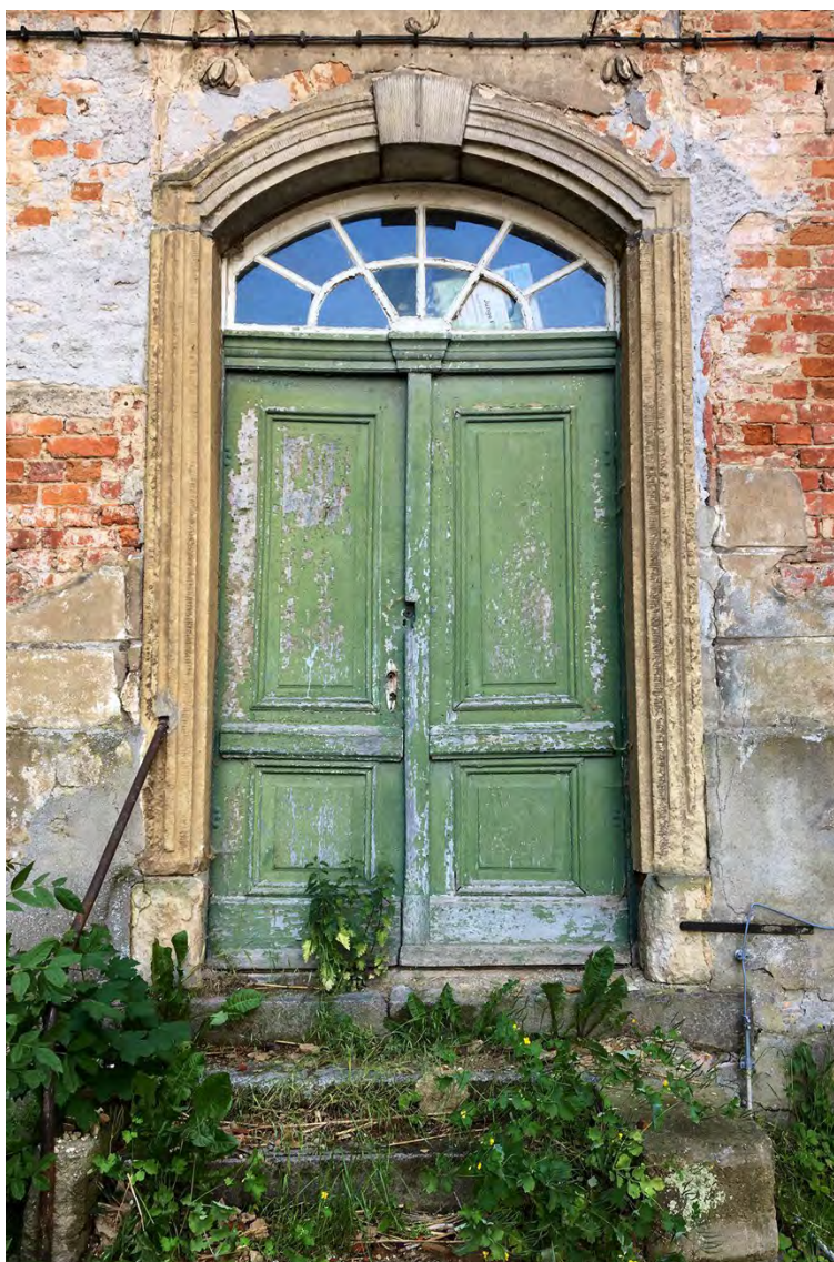
Abb. 45 Kernbau, Westseite; Mittelrisalit, Tür, Juni 2017
