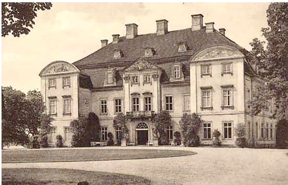
Abb. 5 Schloss, Ansicht von Nordosten, Foto 1920er Jahre
