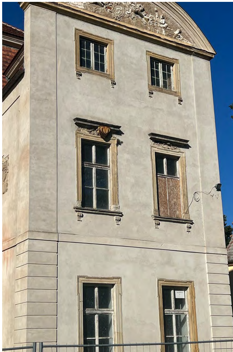
Abb. 14 Kernbau, nördlicher Eckrisalit, Juli 2019
