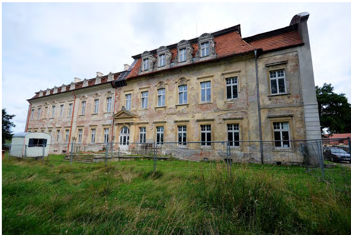
Abb. 25 Ansicht von Südosten, Juni 2017
