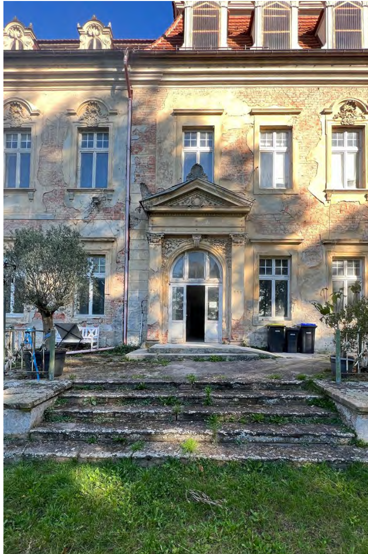
Abb. 30 Kernbau, Südseite, Eingangsbereich, September 2022
