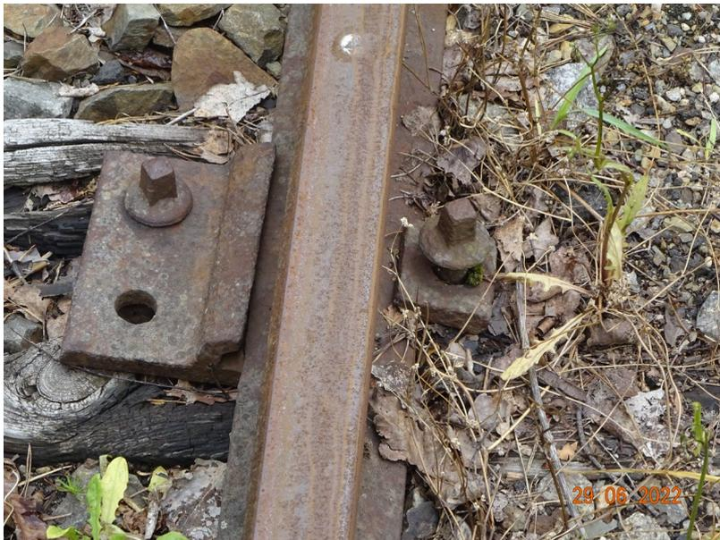
*Foto 2: Defekte Befestigung auf Holzschwelle*
