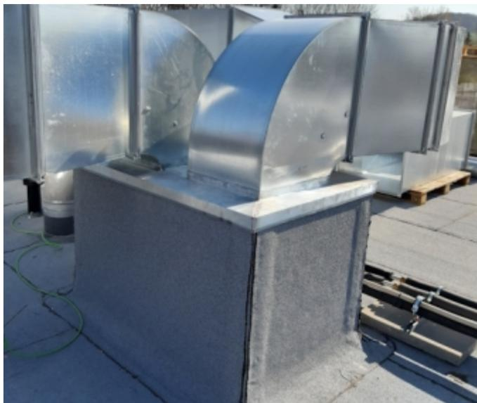
Foto: Beispiel für den fertig eingedichteten Einfasskasten der Lüftung
