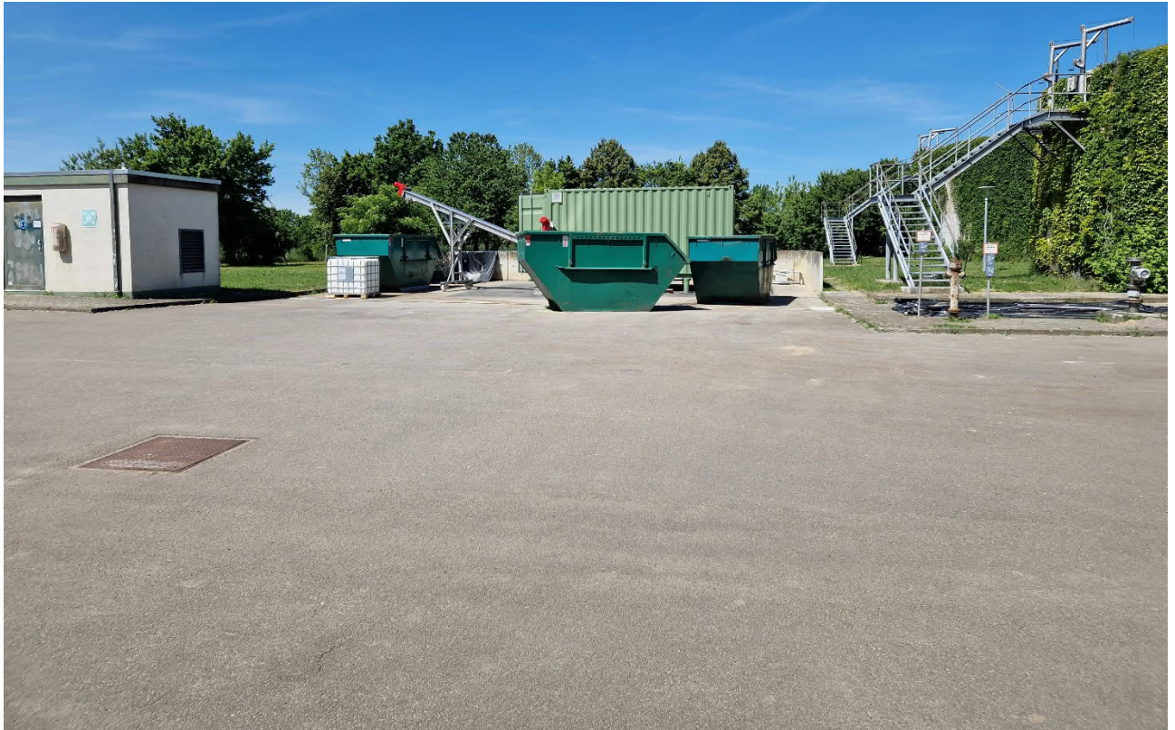
Abbildung 3: Aufstellung der Absetzcontainer für Schlammabwurf und davor liegende Freifläche
