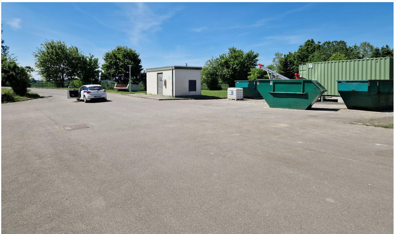
Abbildung 4: Freifläche vor Schlammmentwässerung, vollumfänglich nutzbar für Containerwechsel/-abholung
