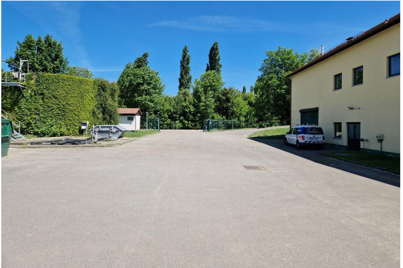
Abbildung 1: Zufahrt Kläranlage und Manövrierbereich für Containerwechsel
