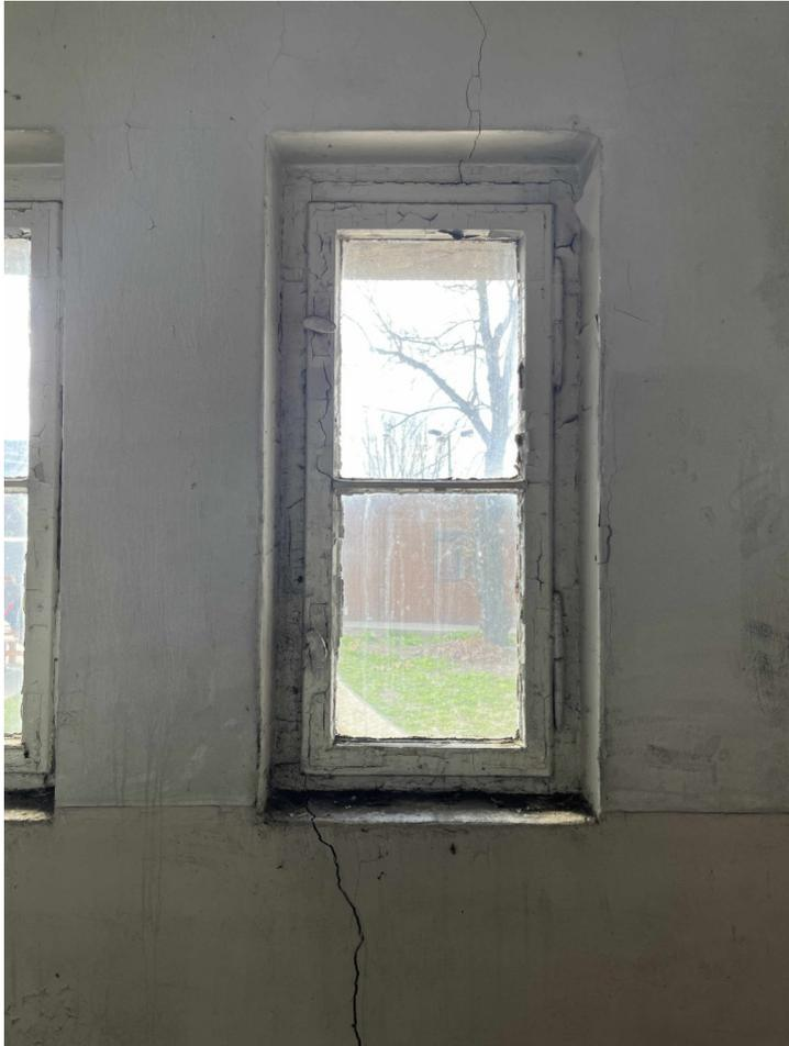
Die Montage der Fenster erfolgt in vorhandener, bauzeitlicher Mauerwerksöffnung, die vorhandene Fensterbank ist als Rollschicht (Sichtmauerwerk) ausgeführt, bauseits vorhanden ist ein Mauerwerksanschlag.
