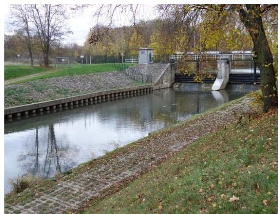
Abbildung 4: Nahlewehr - Wehrkörper, Tosbecken, Furt
