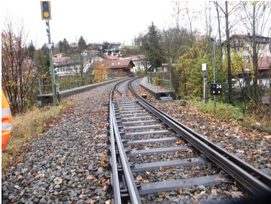
Abb. 102 Weiche 24 mit Ortsbedieneinrichtung (Blickrichtung Tegernsee vor Mangfallbrücke – km 7,85)
