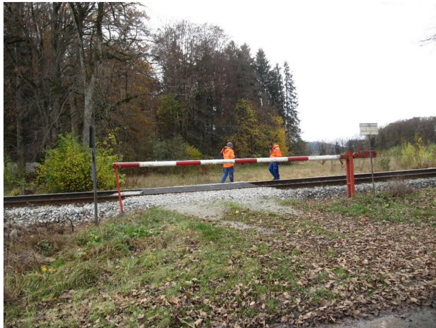
Abb. 42 BÜ Privatweg / Anwesen Zisthof km 3,752 - Blickrichtung Nordosten (Nebengebäude Zisthof)
