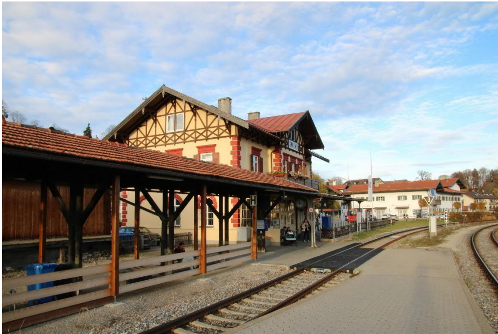
Abb. 100 Empfangsgebäude mit Stellwerk
