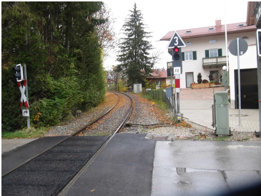
Abb. 103 Einfahrtsignal F2 aus Richtung Tegernsee (km 7,980)
