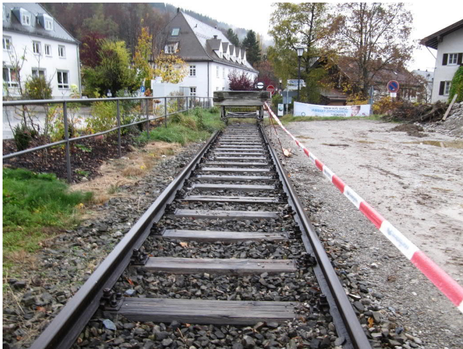
Abb. 110 Streckenende, Gleisabschluss im Gleis 11 (km 12,45)
