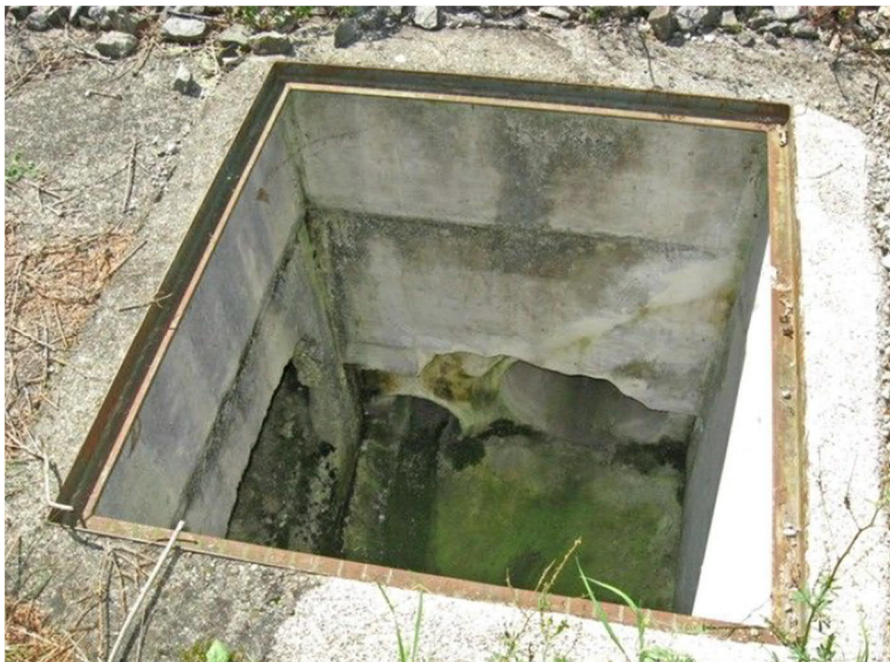
Abb. 6 Durchlass „Trockenbett“ (km 4,828) - Offener Kontrollschacht
