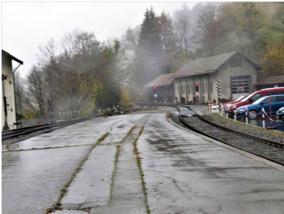
Abb. 106 Ausfahrtsignale P11 und P15 Richtung Gmund (km 12,118)
