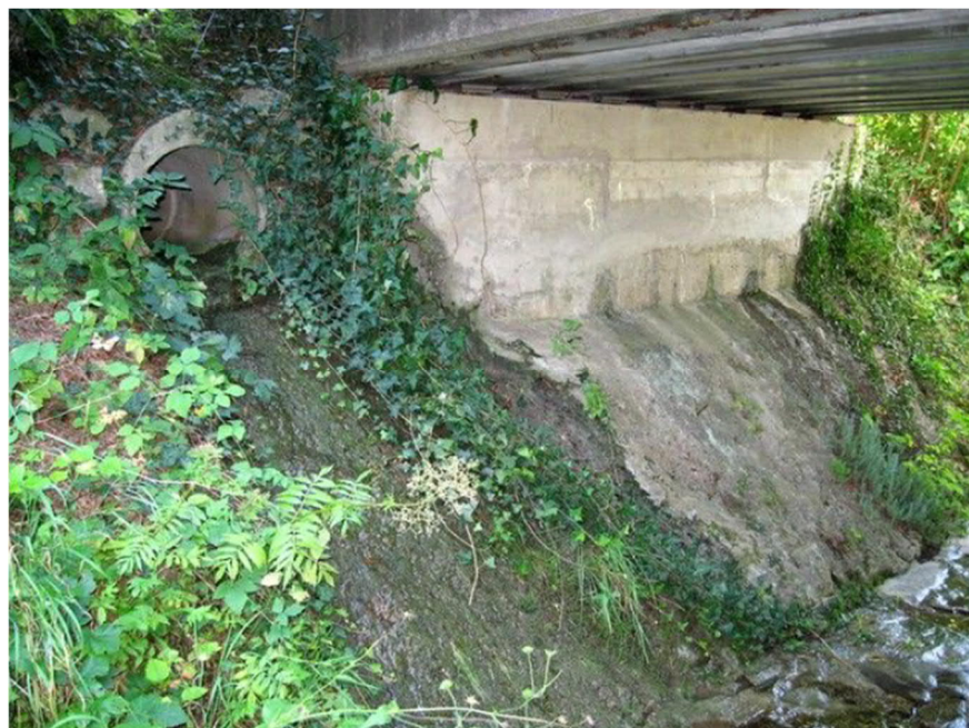
Abb. 18 EÜ Grainbach (km 10,242) - Blick auf das südliche Widerlager
