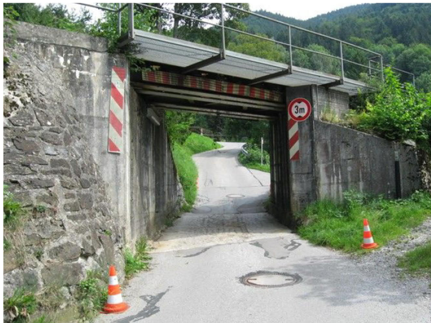
Abb. 20 EÜ Schäferbrücke (km 10,725) - Ansicht von bahnrechter Seite
