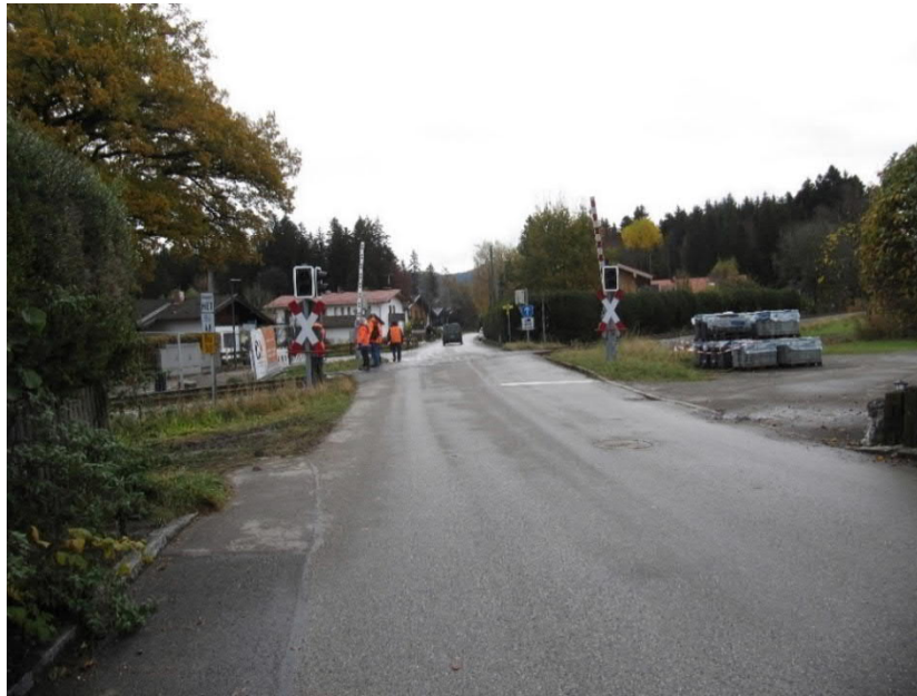
Abb. 48 BÜ Kerndlweg II km 4,815 - Blickrichtung Südosten
