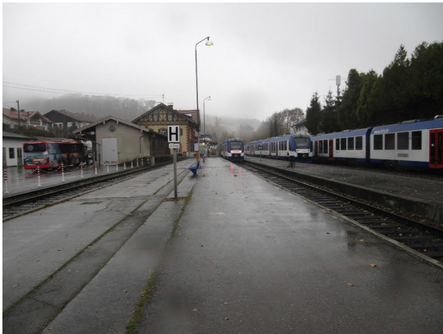
Abb. 108 Mittelbahnsteig Blickrichtung Süden zum Bahnhofsgebäude (km 12,24)
