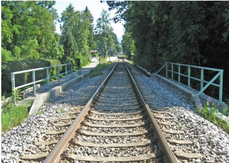
Abb. 3 EÜ Moosbach (km 4,529) - Blick in Richtung Gmund
