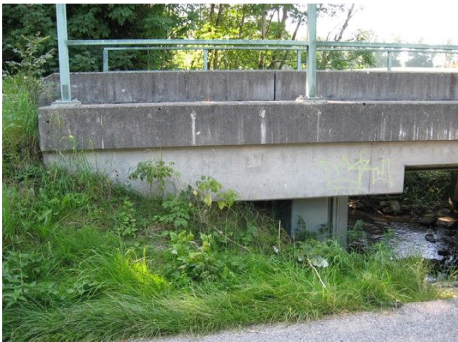
Abb. 4 EÜ Moosbach (km 4,529) - Ansicht von bahnlinker Seite (südliches Widerlager)
