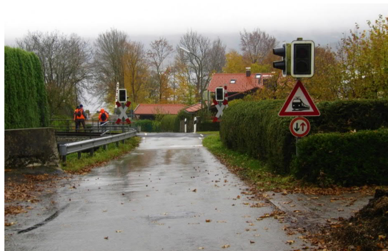
Abb. 81 BÜ Buchbergweg km 10,234 – Blickrichtung Westen (B 307)
