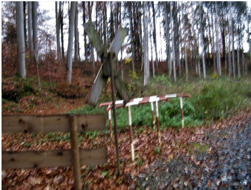
Abb. 61 BÜ öffentlicher Fußweg km 6,750 - Blickrichtung Westen
