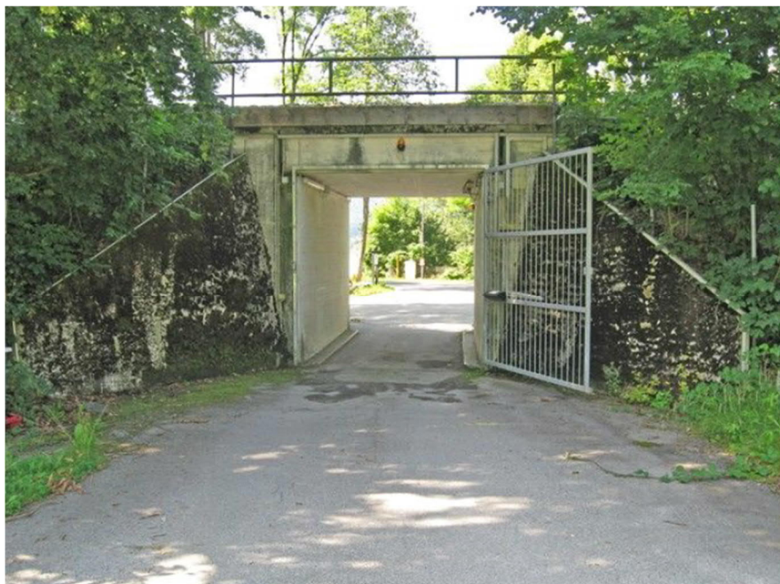
Abb. 16 EÜ Unterführung „Bildungsstätte der Staatsregierung“ (km 9,980) - Ansicht von bahnlinker Seite
