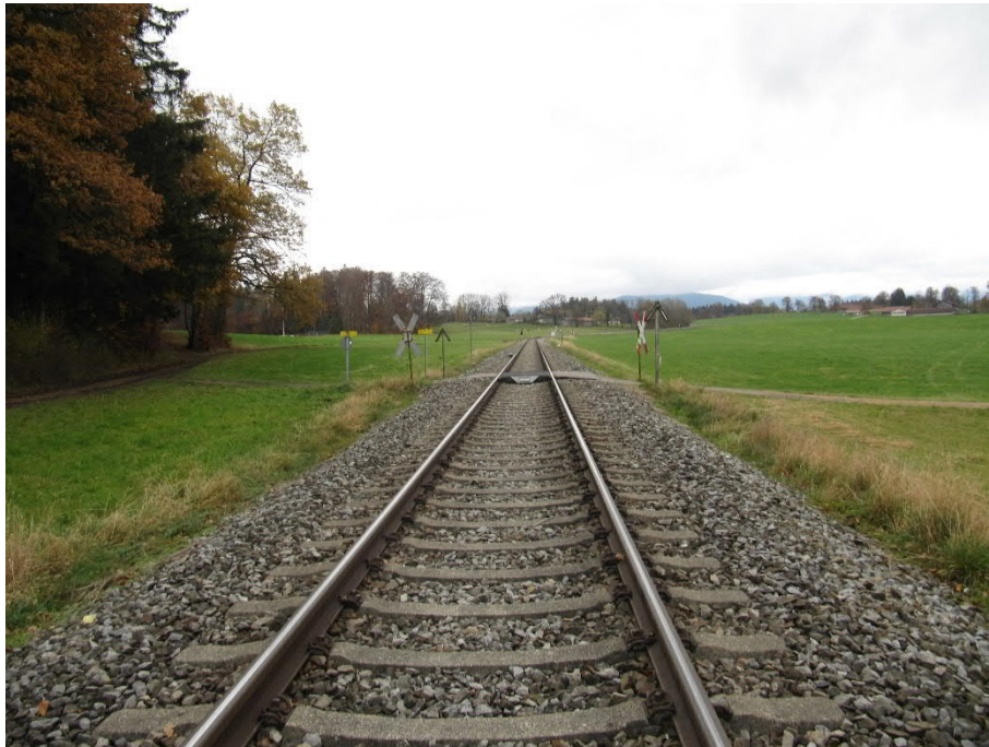
Abb. 21 BÜ-Fußweg km 0,738 - Blickrichtung Gmund
