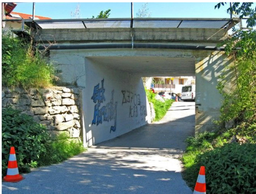
Abb. 10 EÜ Seeuferweg (km 7,822) - Ansicht von bahnrechter Seite
