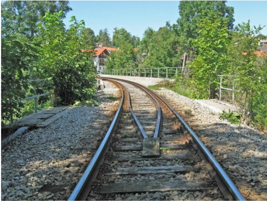
Abb. 13 EÜ Seestraße (km 7,912) - Blick zurück in Richtung Bahnhof Gmund
