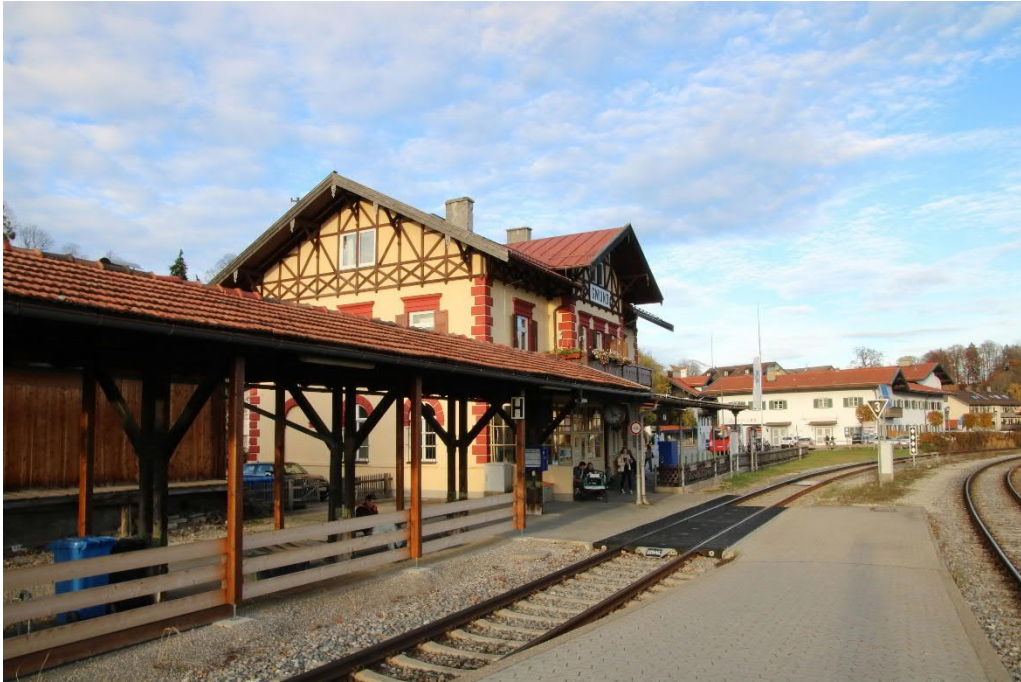
Abb. 100 Empfangsgebäude mit Stellwerk
