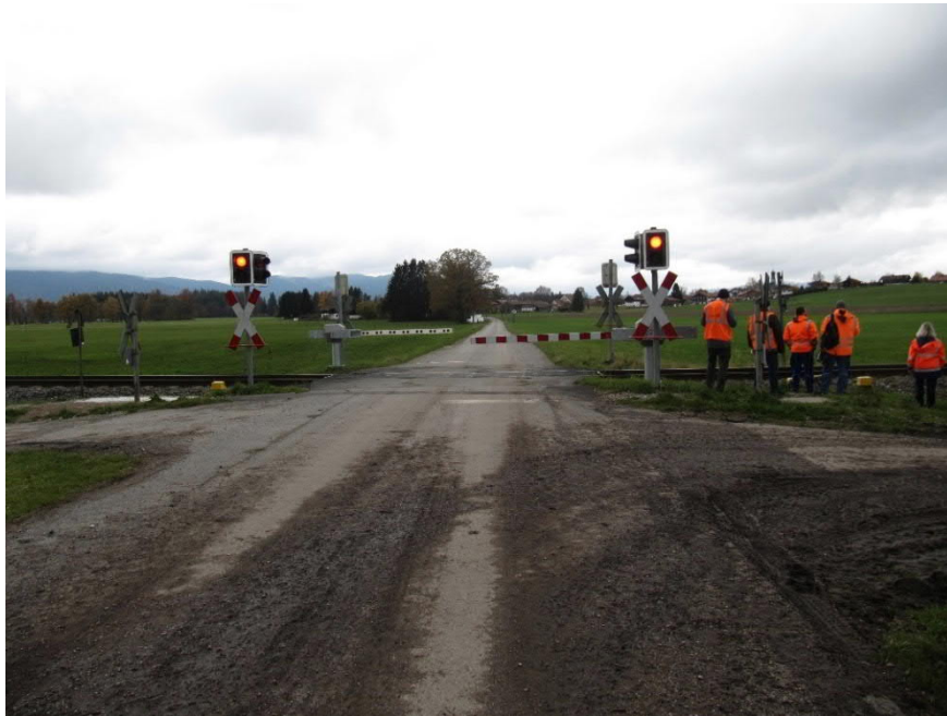
Abb. 22 BÜ Krottenthaler Str. km 1,089 - Blickrichtung Südwest (Schaftlach)
