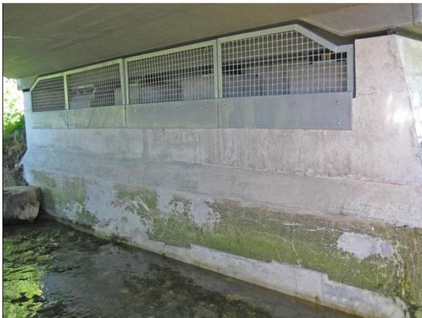
Abb. 8 EÜ Dürnbach (km 6,047) - Ansicht Widerlager, Gitterelemente zwischen Lagerbank und Überbau
