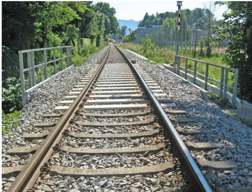
Abb. 7 EÜ Dürnbach (km 6,047) - Blick in Richtung Gmund, Betonflachschwellen auf dem Überbau
