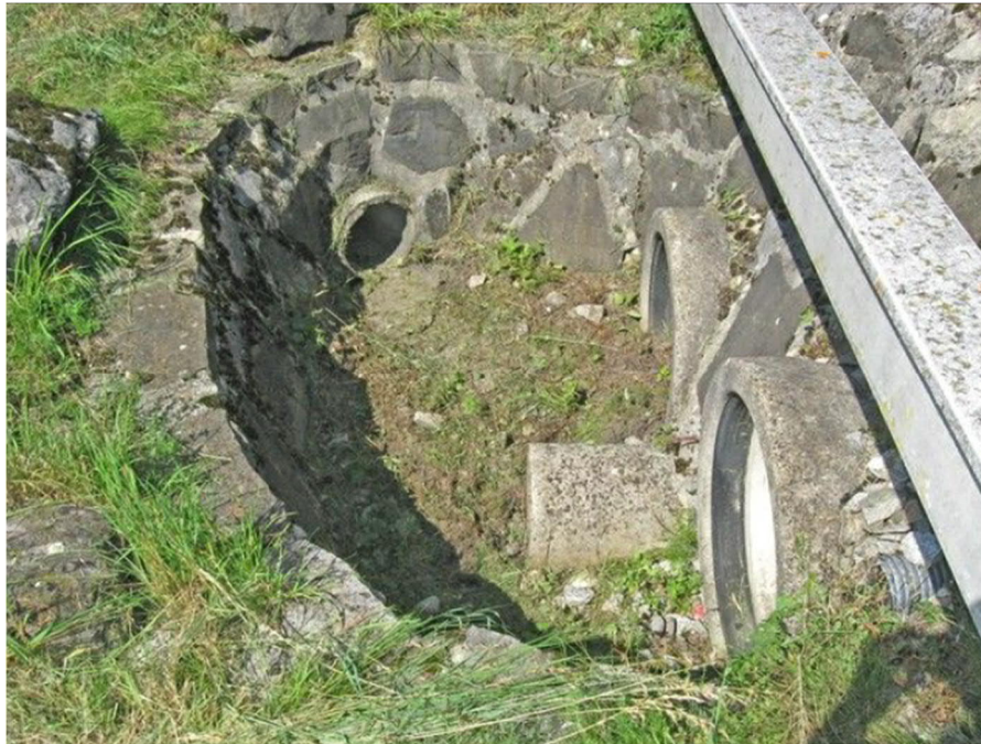
Abb. 5 Durchlass „Trockenbett“ (km 4,828) - Einlaufbecken
