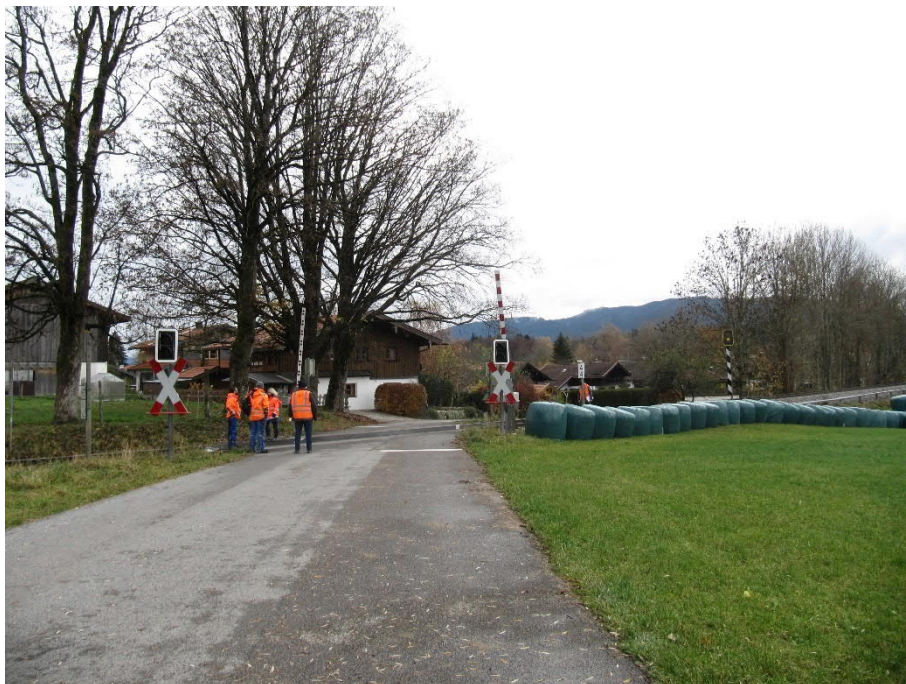
Abb. 46 BÜ Kerndlweg I km 4,395 - Blickrichtung Osten (Moosbach)
