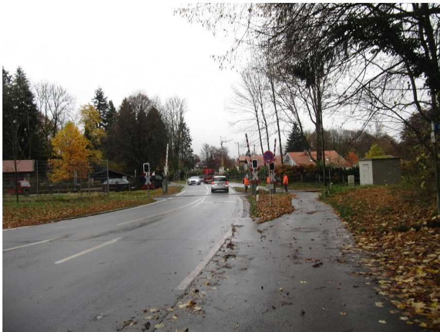
Abb. 58 BÜ Finsterwald km 6,451 - Blickrichtung Osten
