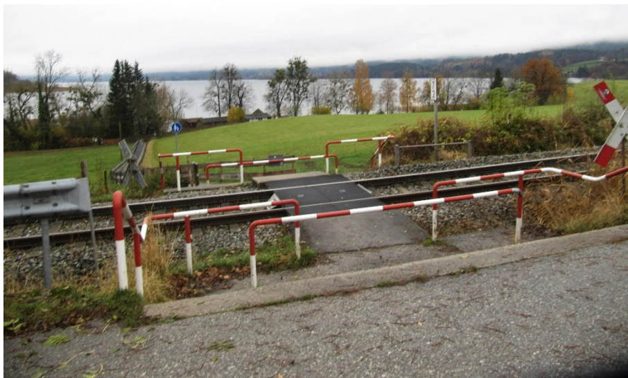
Abb. 67 BÜ öffentlicher Fußweg km 7,208 - Blickrichtung Süd (Tegernsee)
