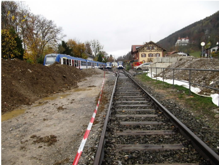
Abb. 109 Streckenende Blickrichtung Bahnhof, Gleis 11 mit Weiche 17 (km 12,45)
