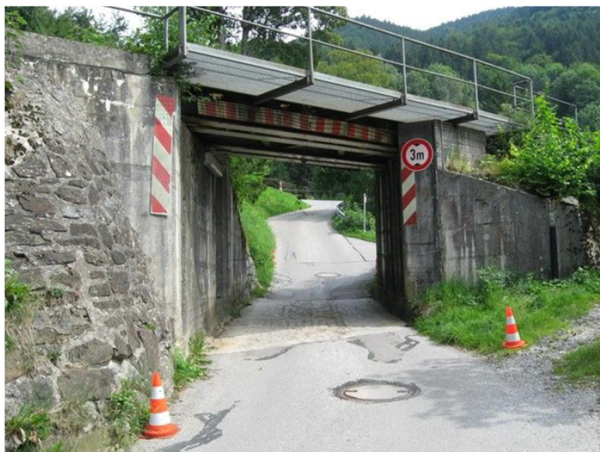
Abb. 20 EÜ Schäferbrücke (km 10,725) - Ansicht von bahnrechter Seite
