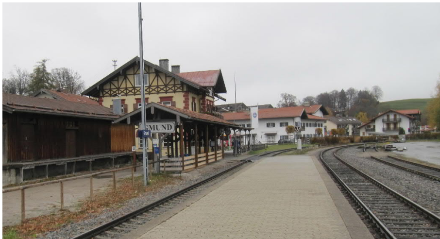
Abb. 69 BÜ Bahnsteigzugang km 7,700 - Blickrichtung Osten
