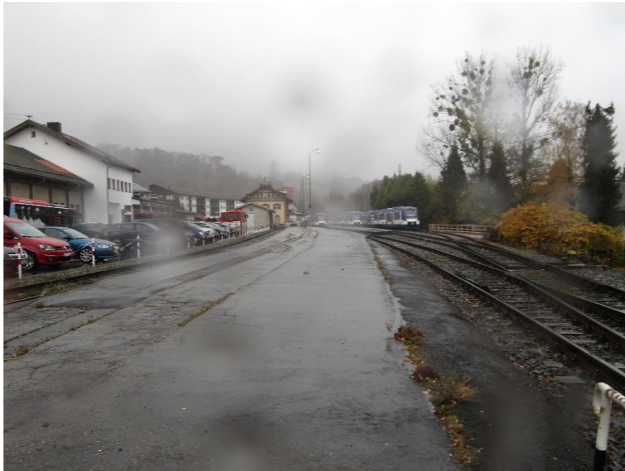
Abb. 107 Ende Mittelbahnsteig Blickrichtung Süden zum Bahnhofsgebäude (km 12,14)
