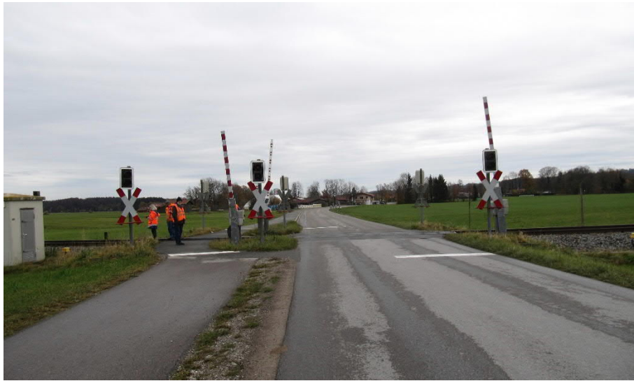
Abb. 54 BÜ Dürnbacher Feld km 5,875 - Blickrichtung Osten (Dürnbach)
