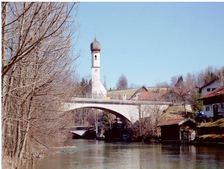
Abb. 12 EÜ Mangfall (km 7,875) - Ansicht von Westen
