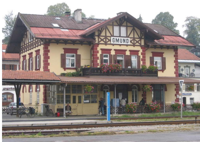
Abb. 94 Bf Gmund – Empfangsgebäude und angrenzende Überdachung des Wartebereiches
