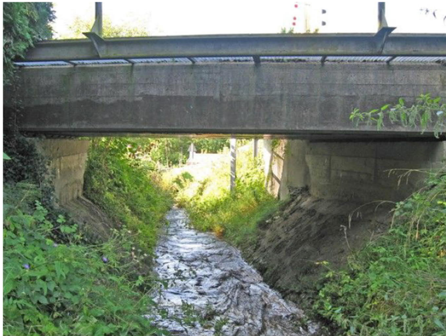
Abb. 17 EÜ Grainbach (km 10,242) - Ansicht von bahnlinker Seite
