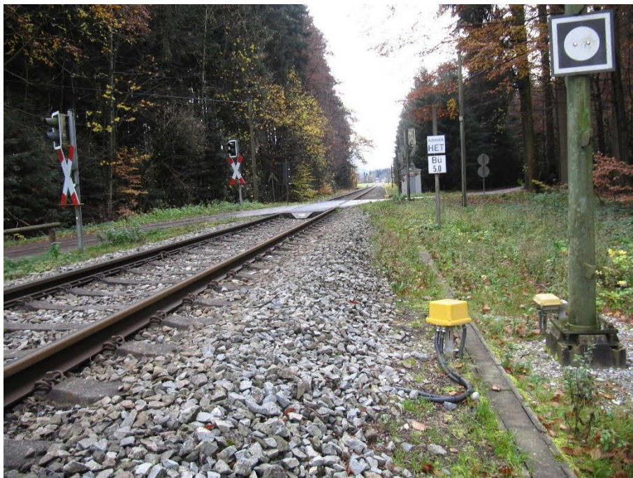
Abb. 51 BÜ An der Bahn km 5,032 - Blickrichtung Bf Gmund
