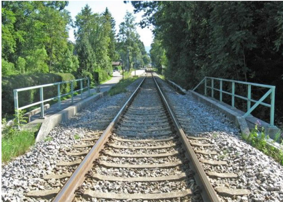
Abb. 3 EÜ Moosbach (km 4,529) - Blick in Richtung Gmund
