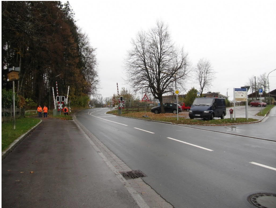
Abb. 57 BÜ Finsterwald km 6,451 - Blickrichtung Westen
