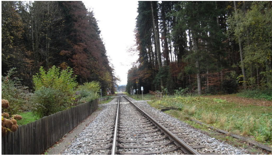
Abb. 50 BÜ An der Bahn km 5,032 - Blickrichtung Bf Gmund
