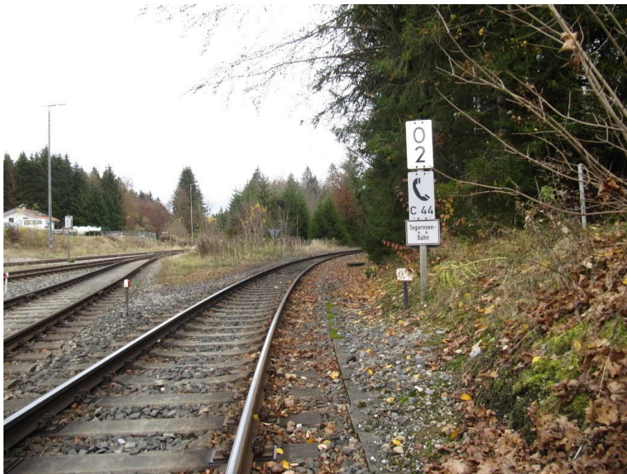
Abb. 96 Infrastrukturgrenze TBG / DB Netz AG (Schweißnaht Weiche 6) – km 0,2
