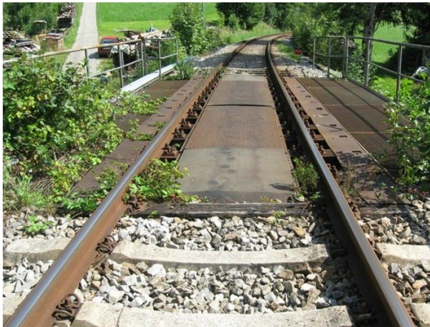
Abb. 19 EÜ Schäferbrücke (km 10,725) - Blick in Richtung Bf Tegernsee
