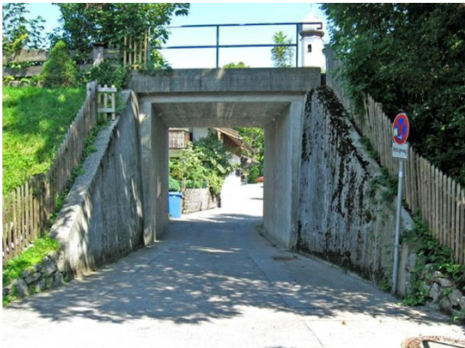
Abb. 14 EÜ Seestraße (km 7,912) - Ansicht von bahnrechtlicher Seite
