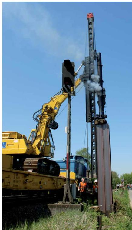
**Abb. 132 Bsp. Tiefgründung mit Explosionsramme**
