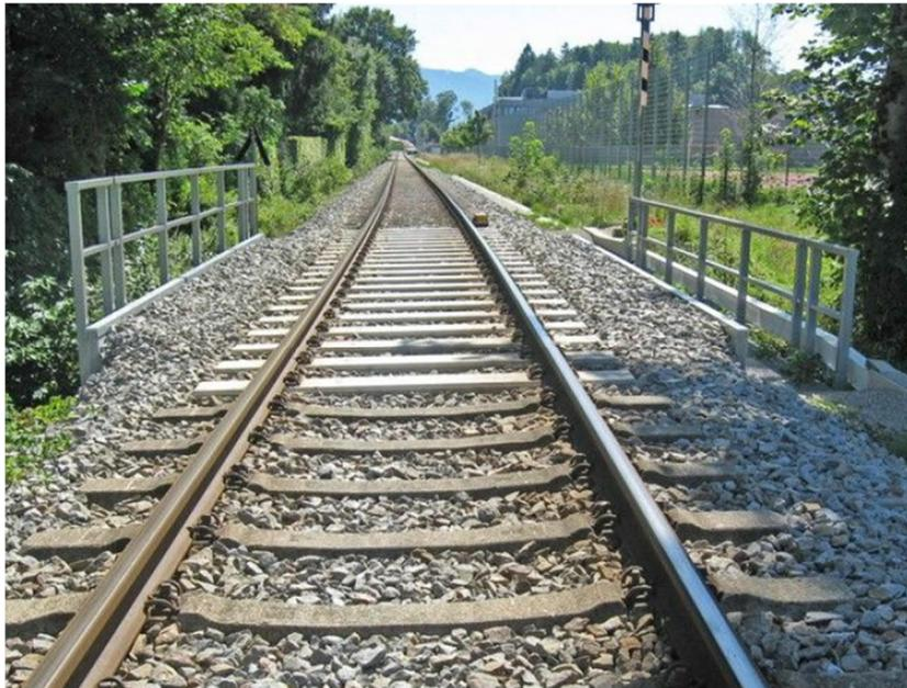
Abb. 7 EÜ Dürnbach (km 6,047) - Blick in Richtung Gmund, Betonflachschwellen auf dem Überbau
