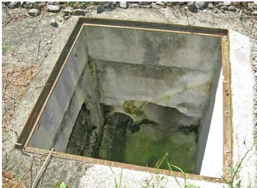
Abb. 6 Durchlass „Trockenbett“ (km 4,828) - Offener Kontrollschacht
