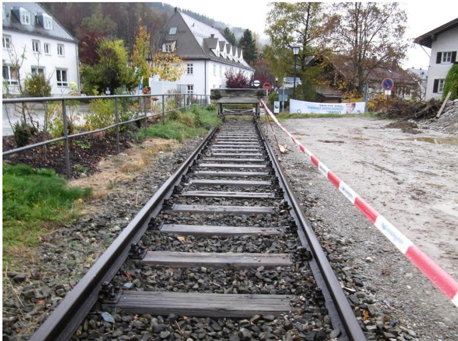
**Abb. 110 Streckenende, Gleisabschluss im Gleis 11 (km 12,45)**
