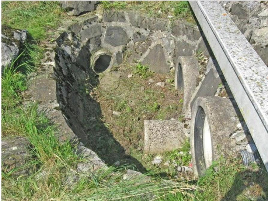
Abb. 5 Durchlass „Trockenbett“ (km 4,828) - Einlaufbecken
