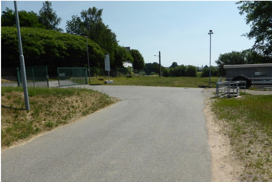
Abbildung 3: Einfahrt zur Kläranlage Hartha
