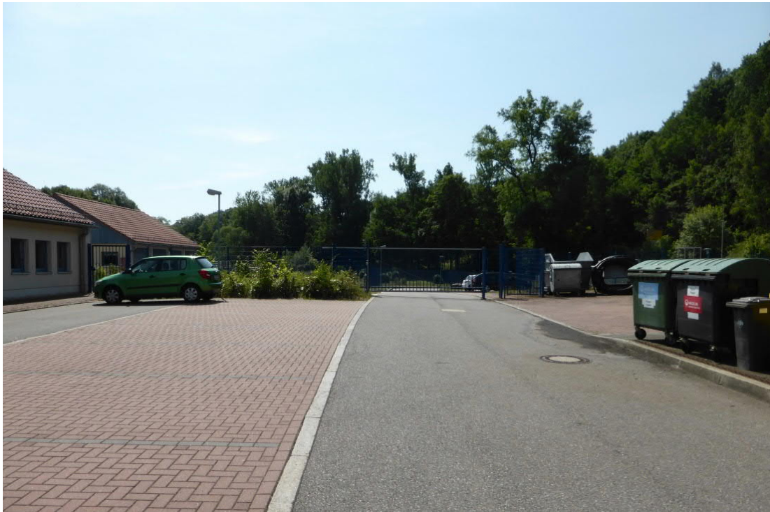
Abbildung 1: Hauptzufahrt der Kläranlage Waldheim
