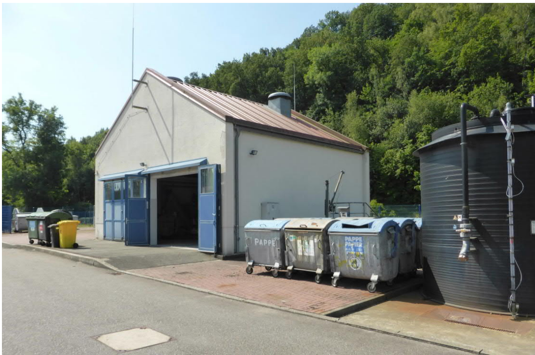
Abbildung 2: Rechengebäude der Kläranlage Waldheim; Stellplatz der Container für Rechen- und Sandfangrückstände
