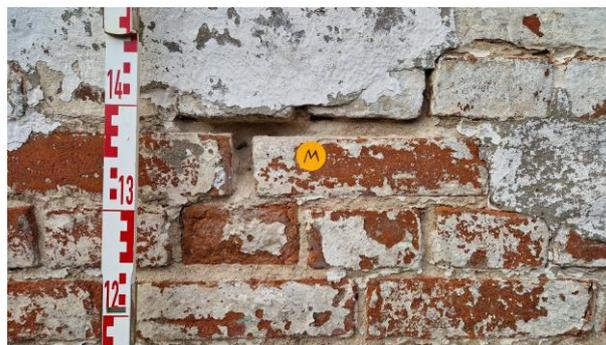
Abb. 25 Ostseite, nördlicher Gebäudebereich, Probenahmepunkt Fugenmörtel, 138 cm über GOK
