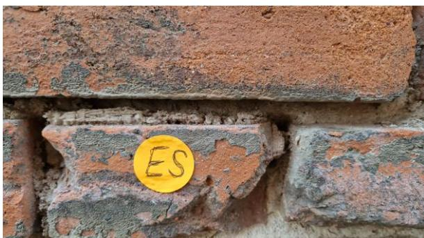
Abb. 6 Probenahmepunkt FES, 125 cm über GOK, Fugen sind vollständig mit Schadsalzen ausgefüllt, Gips- und Schmutzauflagen auf Ziegeloberflächen
