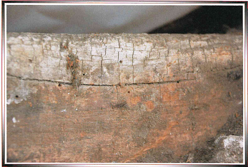
Bild 9 Vereinzelt Fluglöcher von Insekten und Oberflächenfäulnis an Mauerlatte
