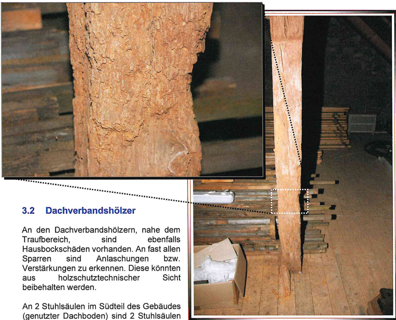
Bild 14 Stuhlsäule mit Schäden vom Gew. Nagekäfer
