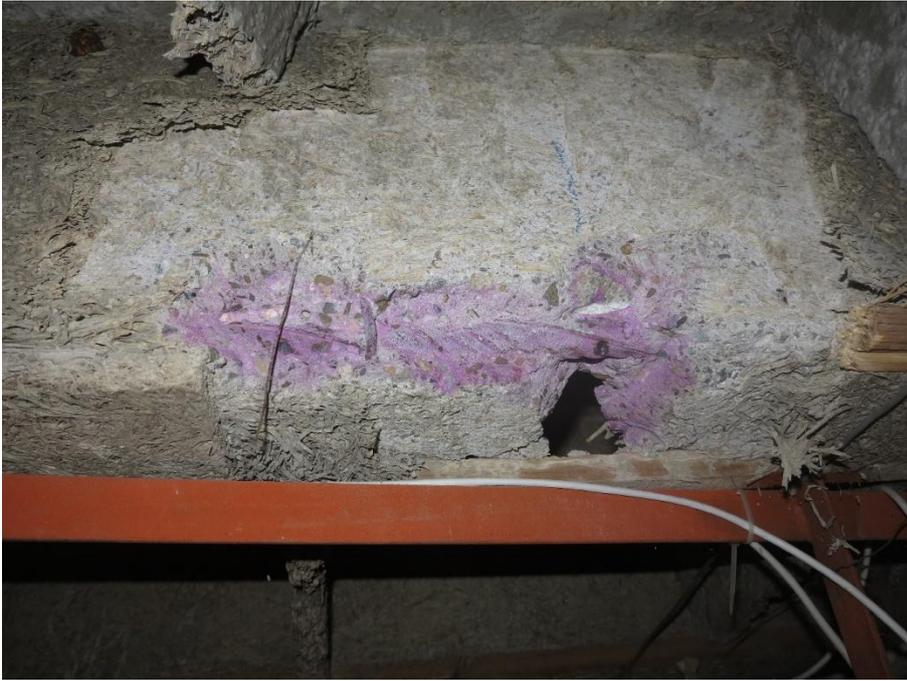
Abbildung 46: : Messstelle D 2, freigelegte Längsbewehrung und Bügel.
