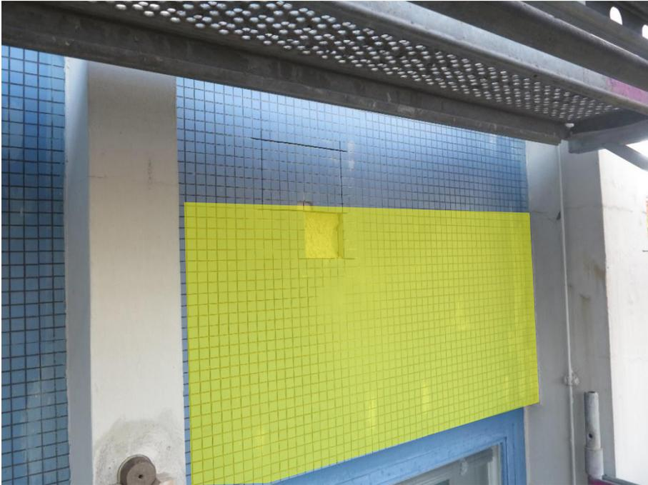
Abbildung 93: Übersichtsaufnahme mit Einzeichnung der Hohllage.
