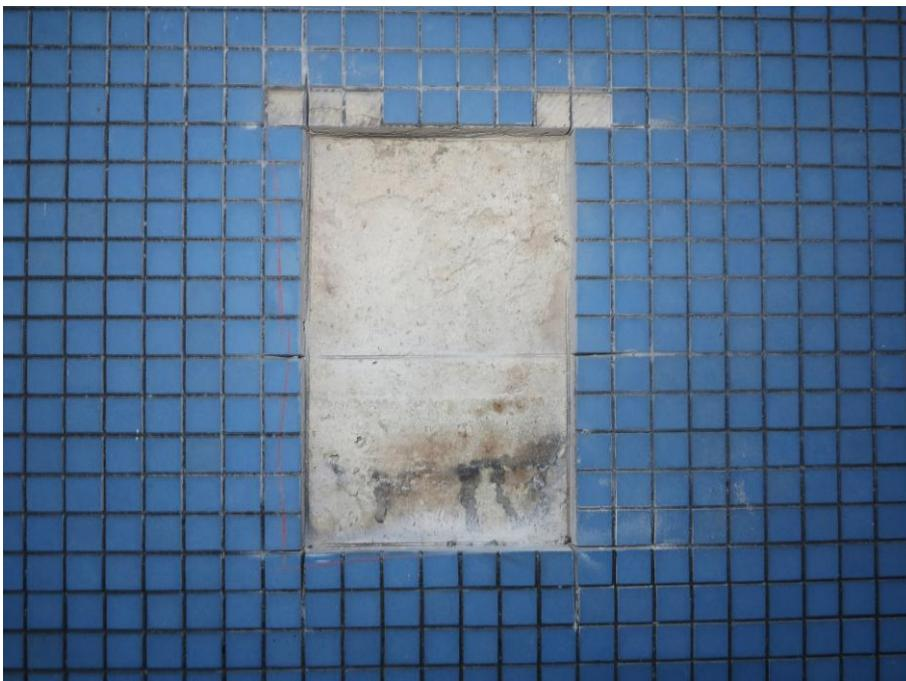
Abbildung 101: Entfernte Fliesenpartie mit freiliegender, verschmutzter Betonoberfläche.
