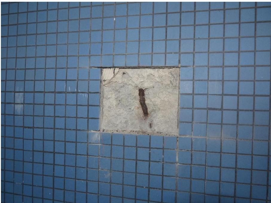
Abbildung 99: Entfernte Fliesenpartie mit korrodiertem Bewehrung.
