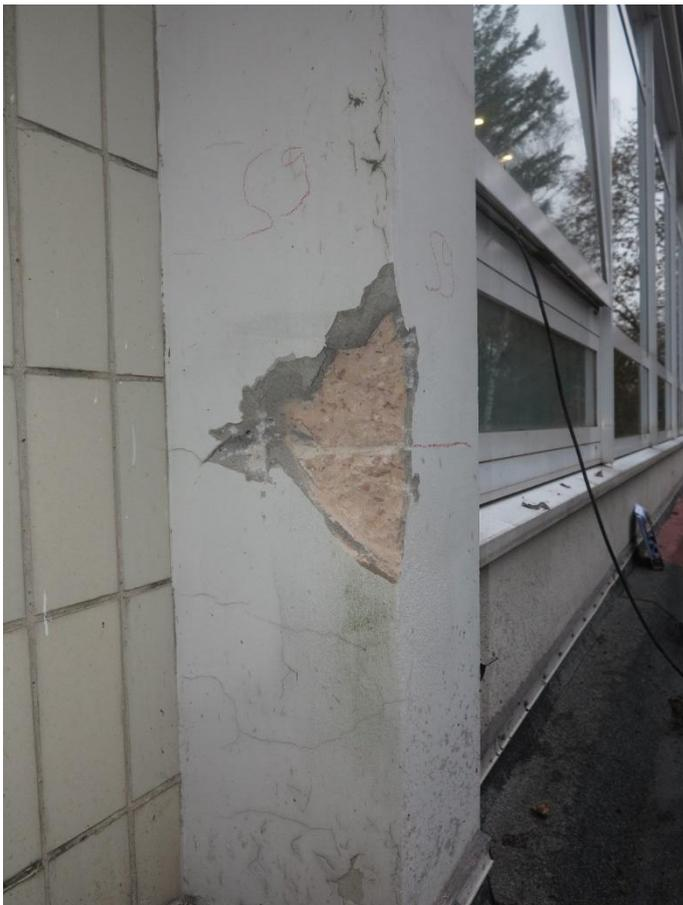
Abbildung 69: Messstelle S 9. Stütze aus Ziegelsplittbetonsteinen.
