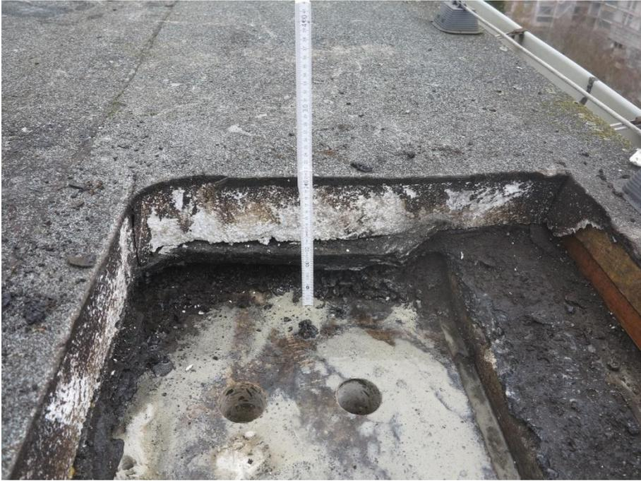
Abbildung 54: Messstelle D 11, Schichtenaufbau.
