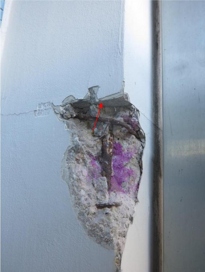
Abbildung 77: Messstelle S 13, Trennung in der Anschlussfuge, kein Verbund.
