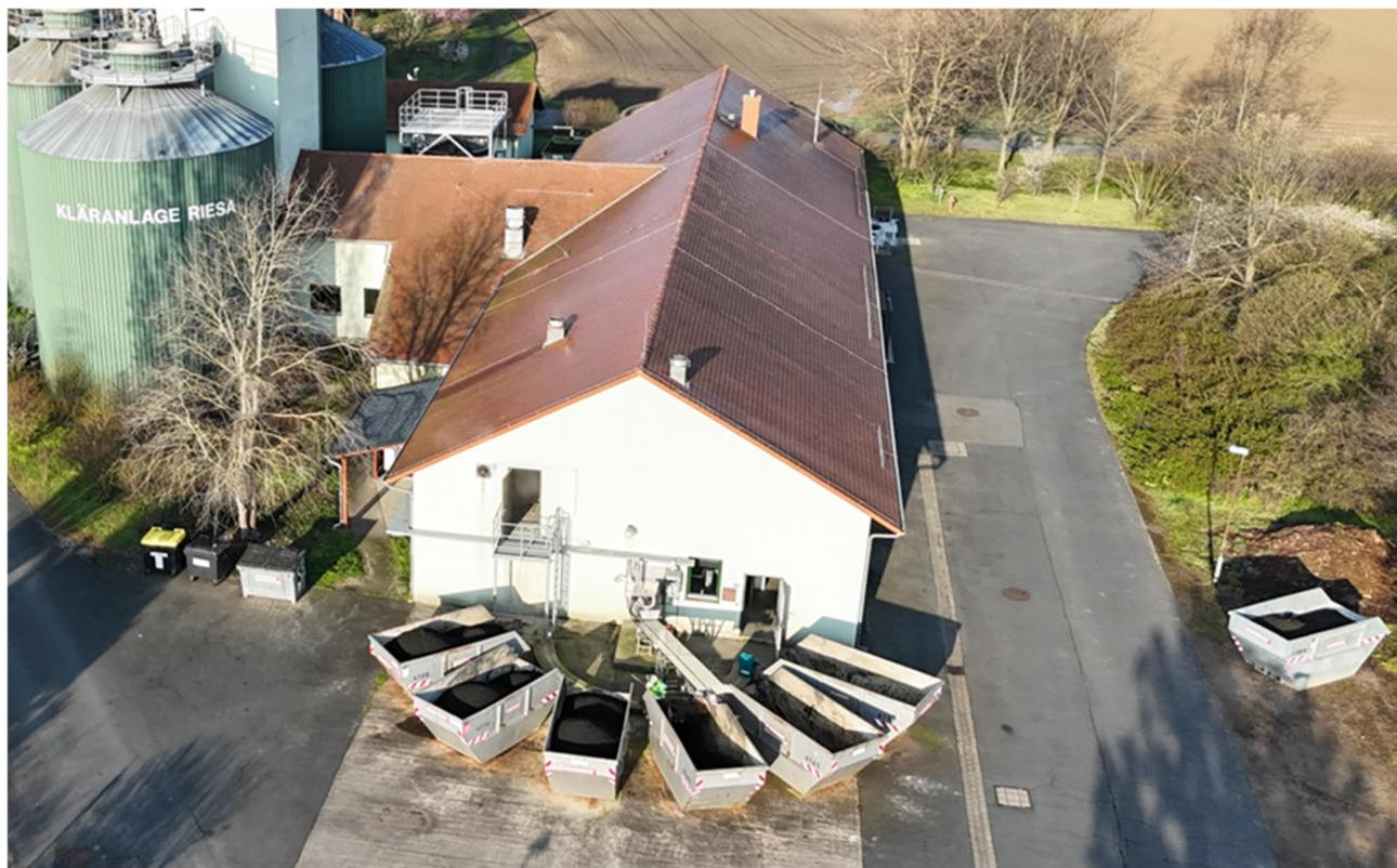
Abbildung 1: Aufstellung der sechs Absetzcontainer zur Befüllung im Bereich des Schenkförderers am Maschinenhaus (rechts im Bild: Fläche zur Zwischenlagerung von sechs weiteren Absetzcontainern)
