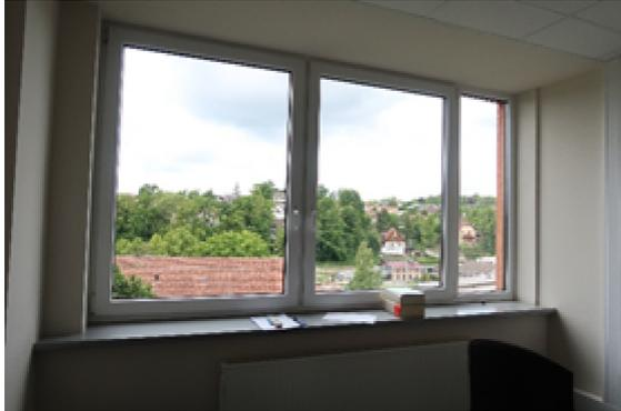
**Ansicht eines Fensterelementes mit Teilflügeln & Festverglasung**
