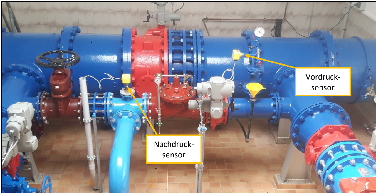
Abbildung 031 Beispiel Druckminderungsstation (DMA)
