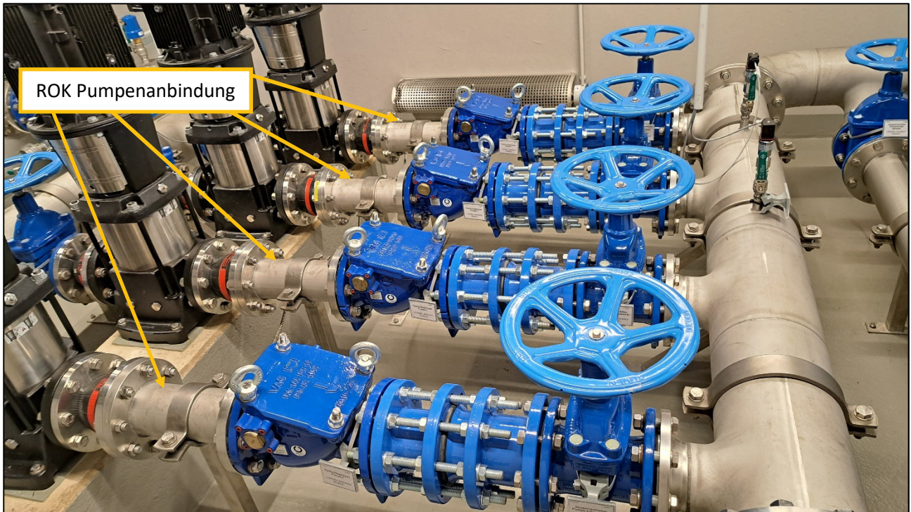
Abbildung 028 Beispiel Druckerhöhungsstation (DEST)
