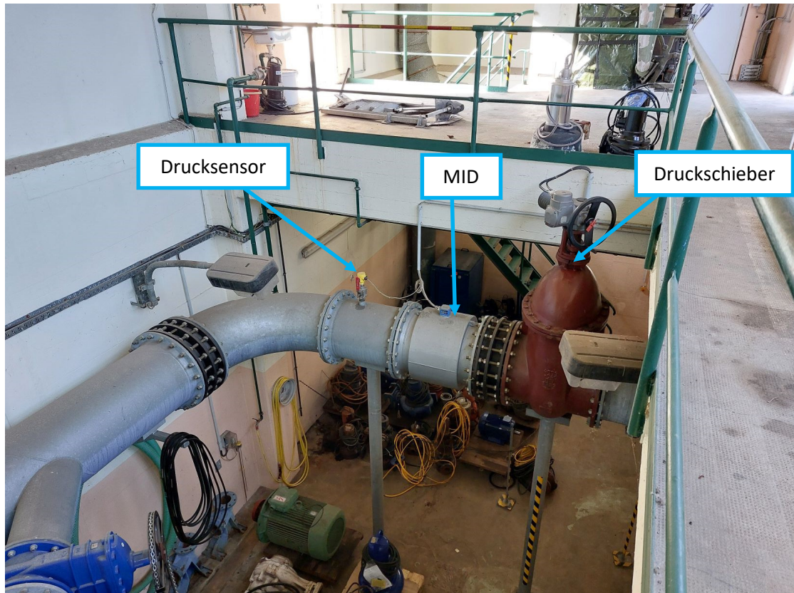
Abbildung 046 Abwasserpumpanlage (APA) Maschinenraum
