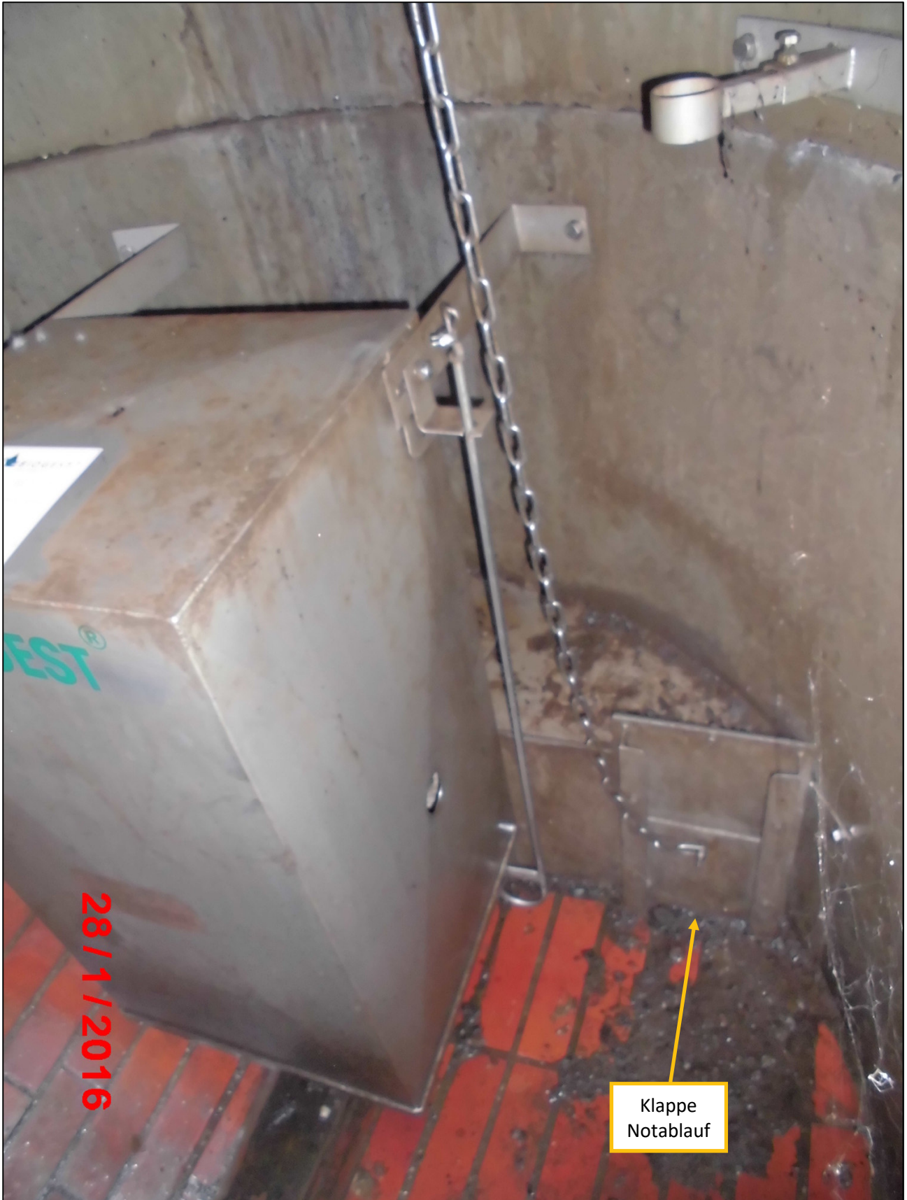
Abbildung 057 Drosselbauwerk mit Schieberdrossel in Nassaufstellung
