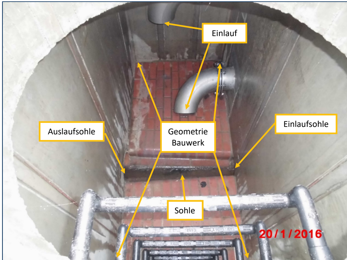
Abbildung 055 Drosselbauwerk mit Wirbeldrossel in Trockenaufstellung Kammer 3
