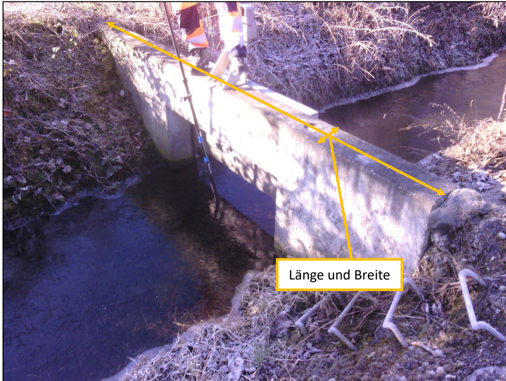
Abbildung 061 Wehrbauwerk mit Schieberdrossel
