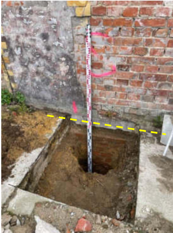
Abb. 1, Betonfundament 1,13 m unter OK Betonfläche, die unbewehrte Bodenplatte ist ca. 23 cm stark
