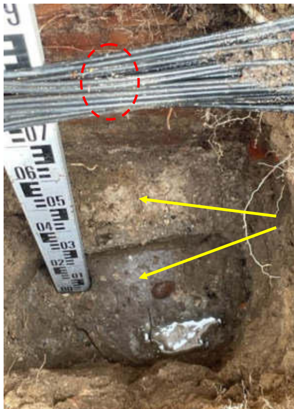
Abb. 6, Blick auf das vorspringende Streifenfundament, es wurden alte Leitungen freigelegt
