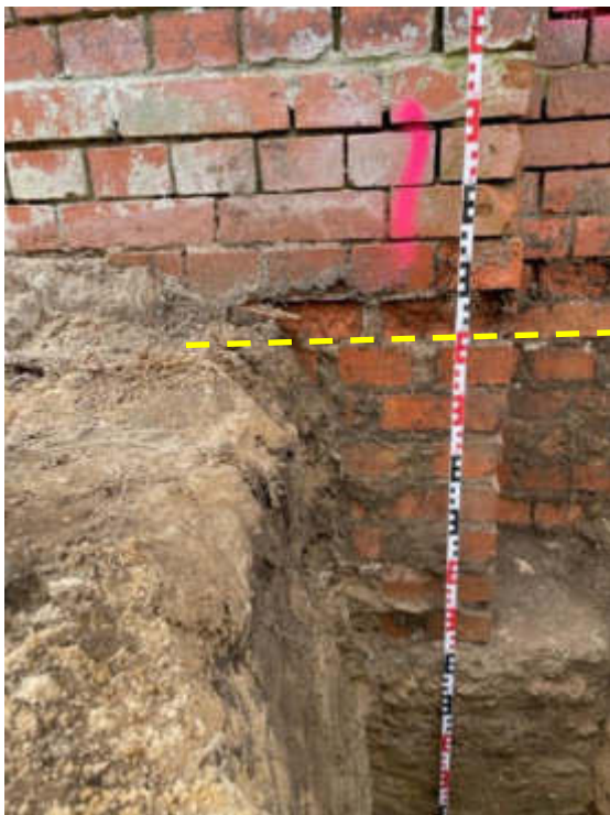
Abb. 3, Einbindetiefe ca. 1,10 m unter OKG, das Fundament ist ca. 0,40 m stark
