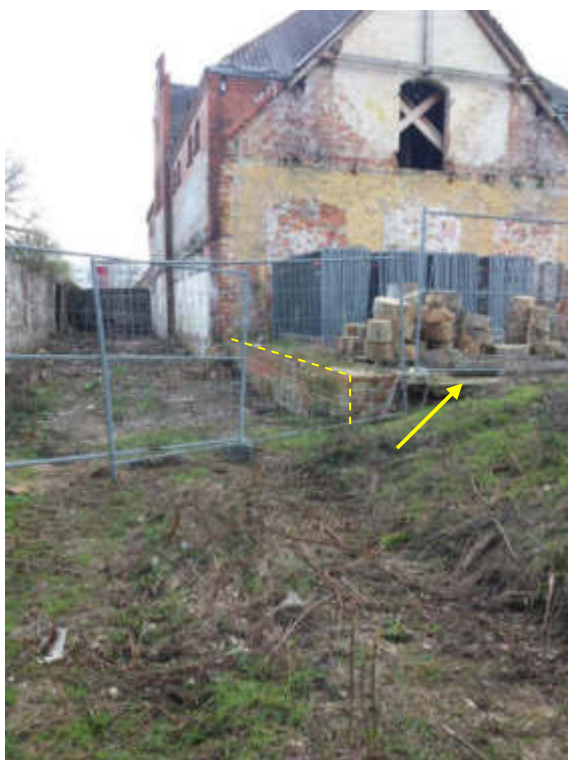
Abb. 7, vorhandene Fundamente + Betonflächen
