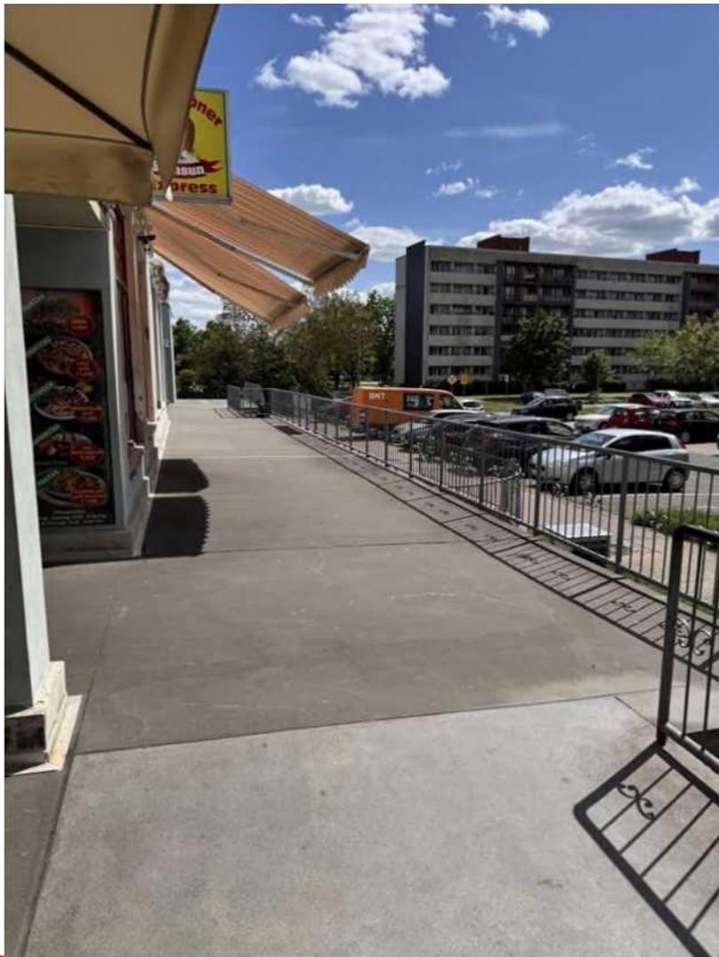
In Schönebeck, in der Moskauer Straße, befindet sich eine Ladenzeile, deren Terrasse einer Sanierung sowie eine angeschlossene Rampe unterzogen wird. Der vorhandene Bodenbelag wird vollständig entfernt und durch neuen Gussasphalt ersetzt. Die bestehenden Absturzsicherungen werden demontiert, instand gesetzt und anschließend wieder montiert.
