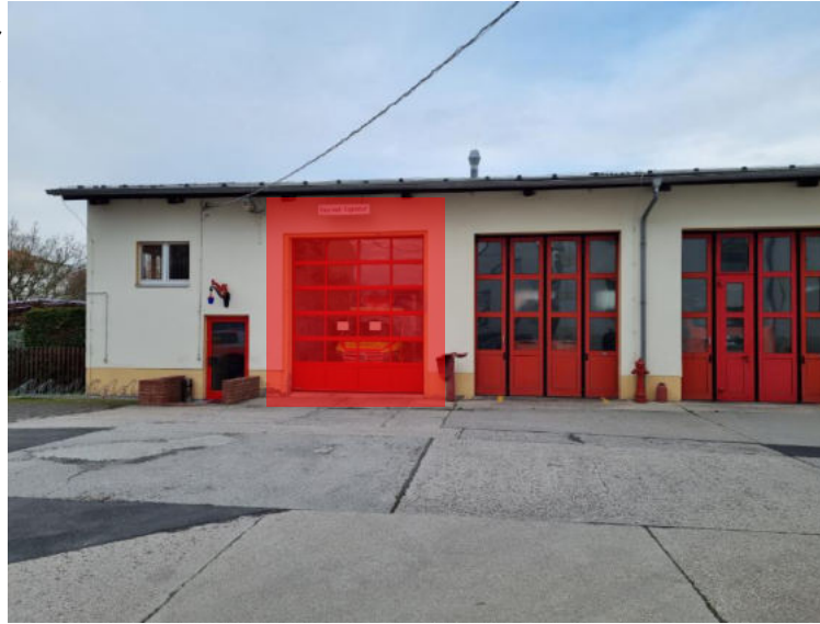
Blick auf die Fahrzeughalle
