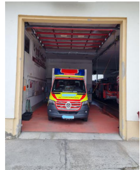
Blick in die Halle
