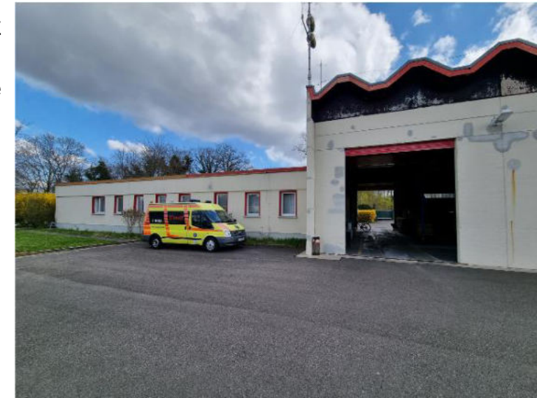
Stellplatz Reservefahrzeug Westseite
