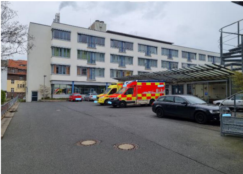
Eingang der Notaufnahme mit NEF-Stellplatz
