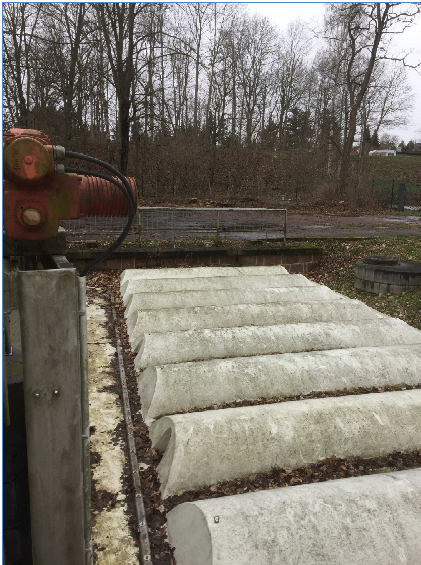
Abbildung 3: Foto Zulauf Übergang Maulprofil auf Rechteckgerinne
