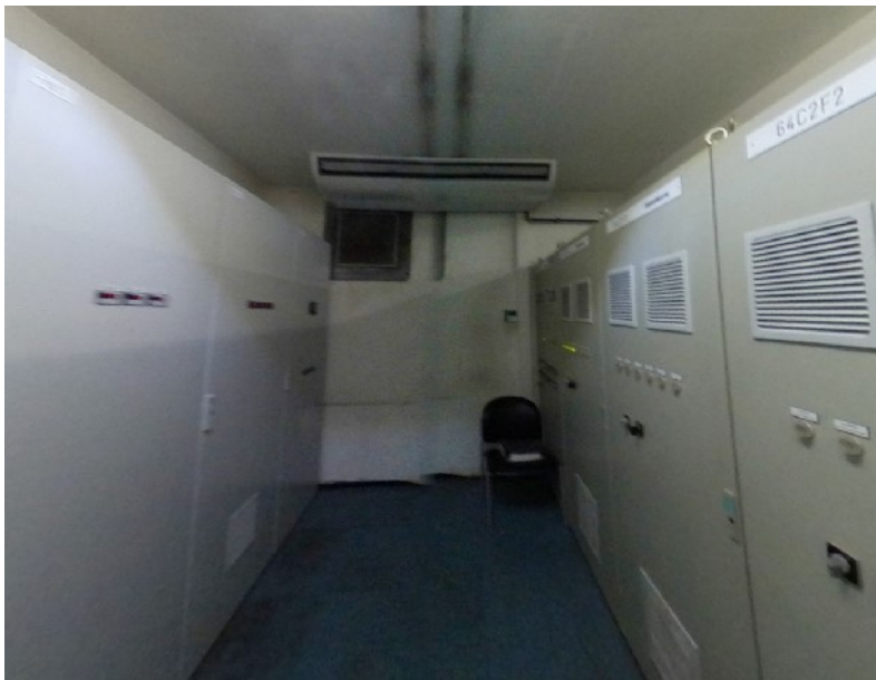
Abbildung 17 Klimaanlage (Innengerät) Schaltraum
