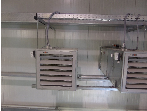
Abbildung 8 Lüfterhitzer mit Umluftkasten (rechts)
