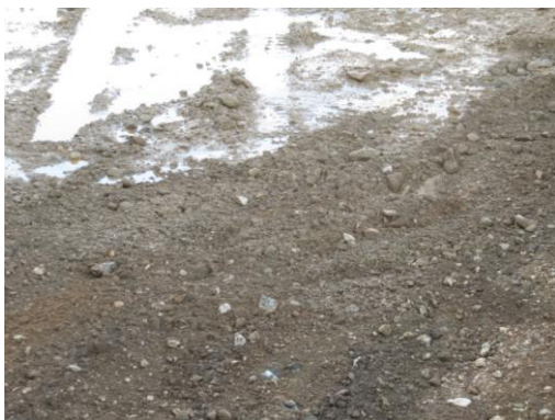
Abbildung 2: OK Flusskies in „trockengelegter“ Baugrube
