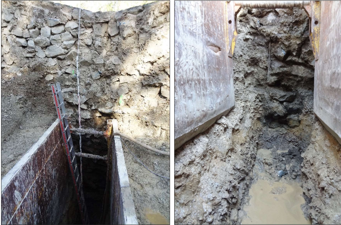
Abb. 16 und 17: Schurf an der HWE im Zuge der Baugrunderkundungen
