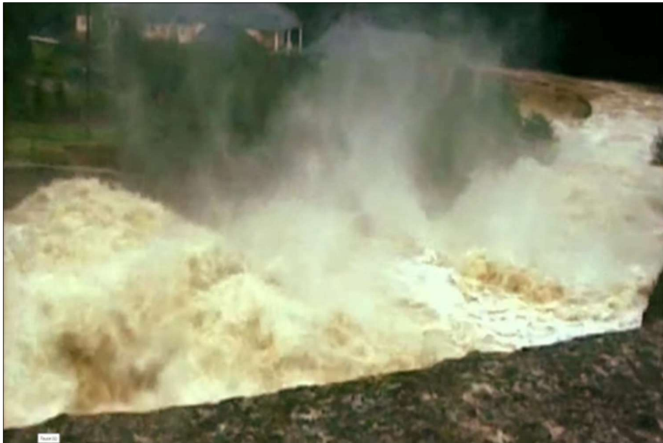
Abb. 3: Belastungssituation eine HWE-Kaskade bei Hochwasser am Beispiel der TS Klingenberg 2002
