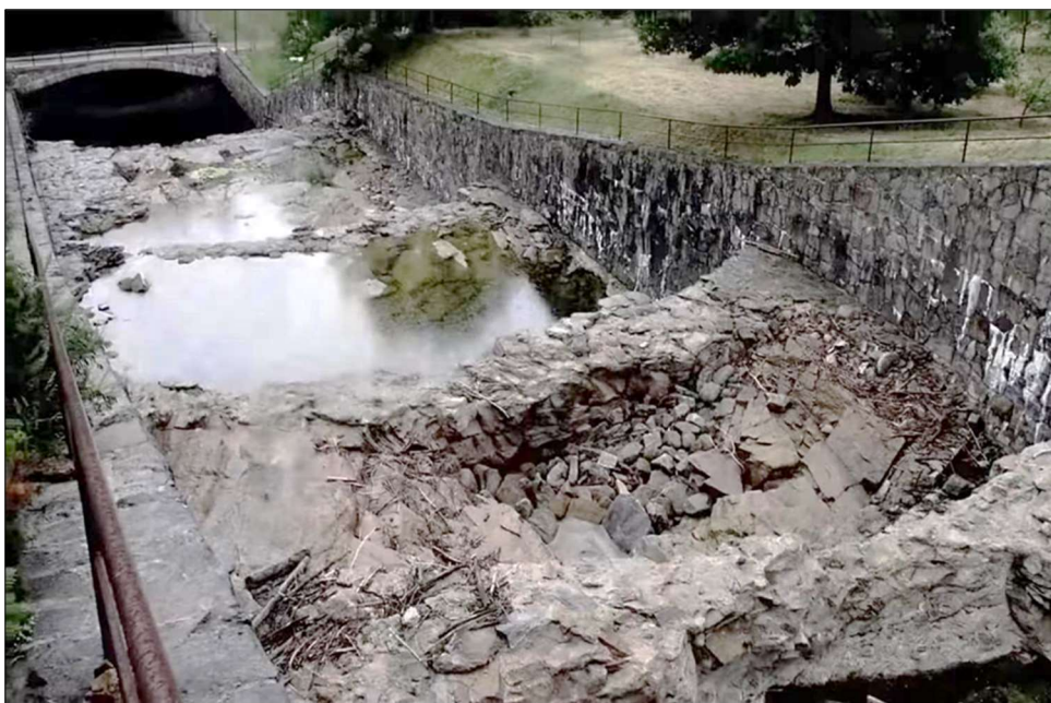
Abb. 4: Schadensbild an der HWE-Kaskade der TS Klingenberg 2002
