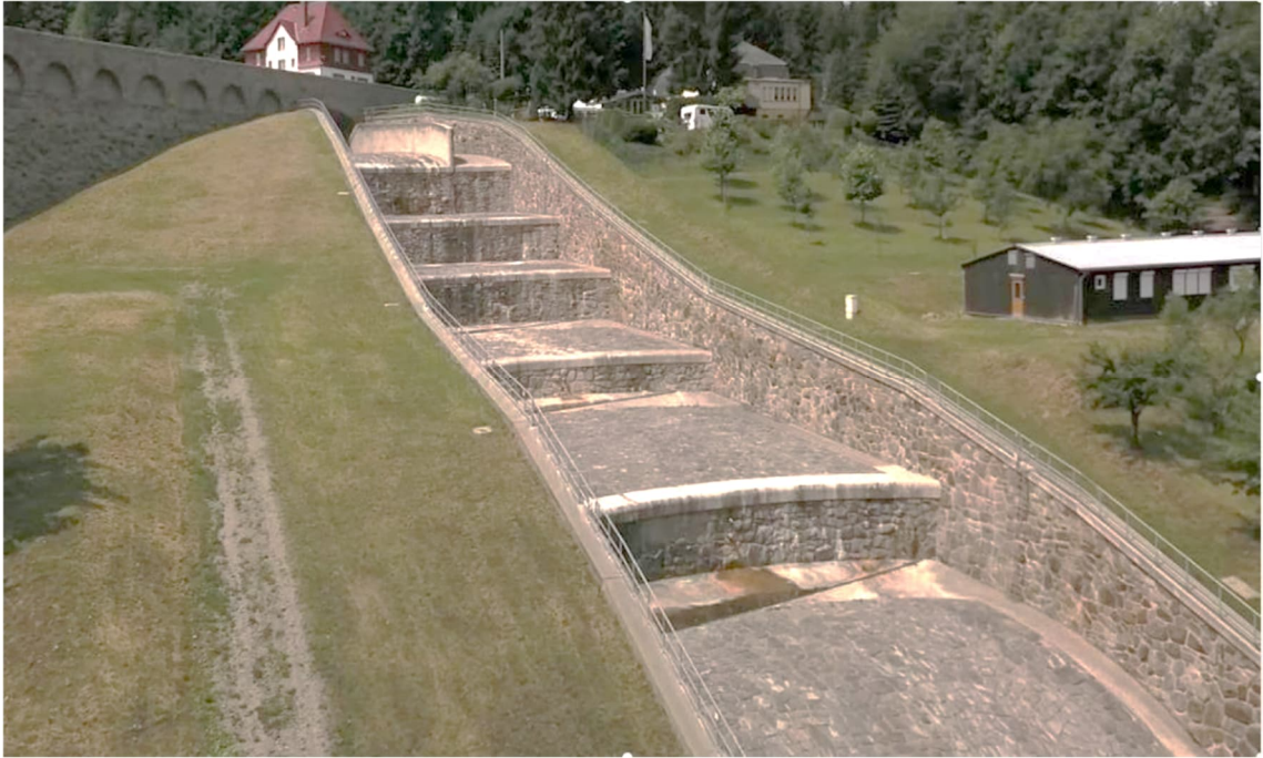
Abb. 3-4.: Beispiel Hochwasserentlastung Talsperre Klingenberg
