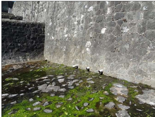
Abb. 14 und 15: Bestehende Punktdränagen im Bereich der Randmauern
