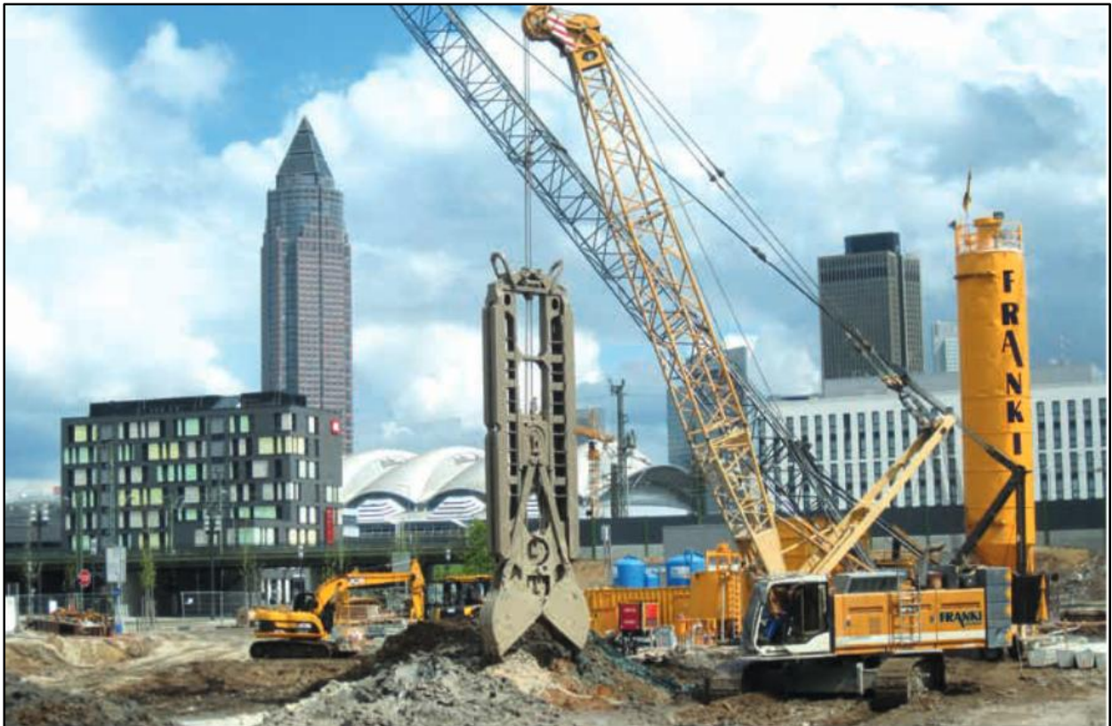
Abb. 6-44 Beispielfoto für die Herstellung einer Dichtwand (Quelle: Bauer)
