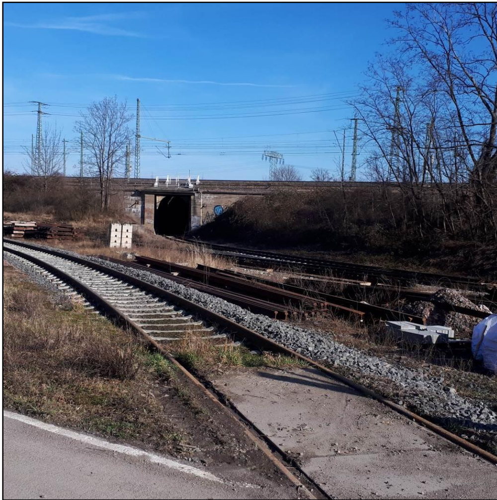
Abb. 7-16 Eisenbahntunnel in Richtung Osten („Südende“)
