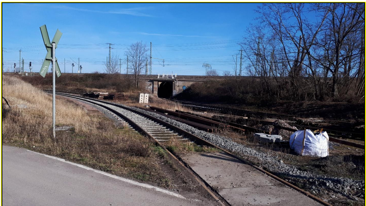
Abb. 2-8 Gleisanlagen innerhalb des Projektareals
