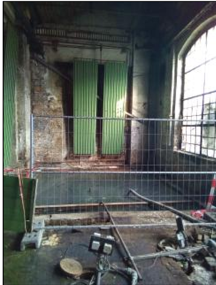
Abb. 6-14 Ehemalige TRI-Grube, die zum Zeitpunkt der Aufnahme im Februar 2022 zur Infiltration von gereinigtem Grundwasser im Rahmen der GW-Sanierung genutzt wurde (Aufnahme G.U.T. mbH)
