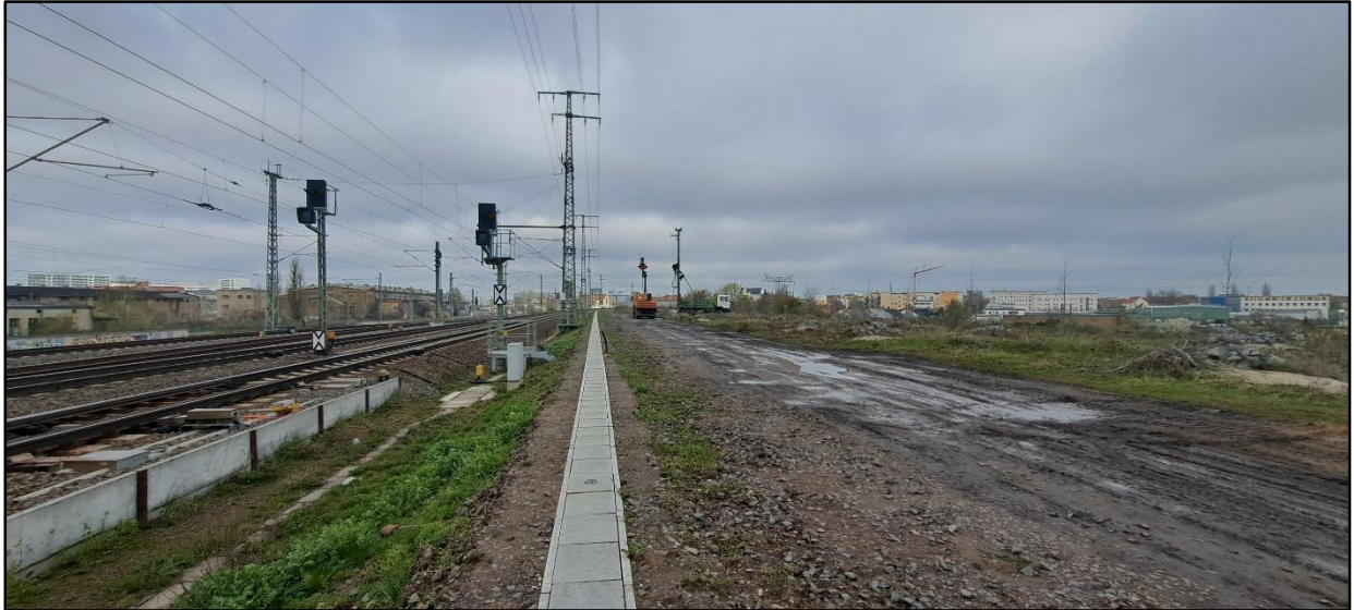
Abb. 2-3 Bahndamm östlich des RAW-Geländes
