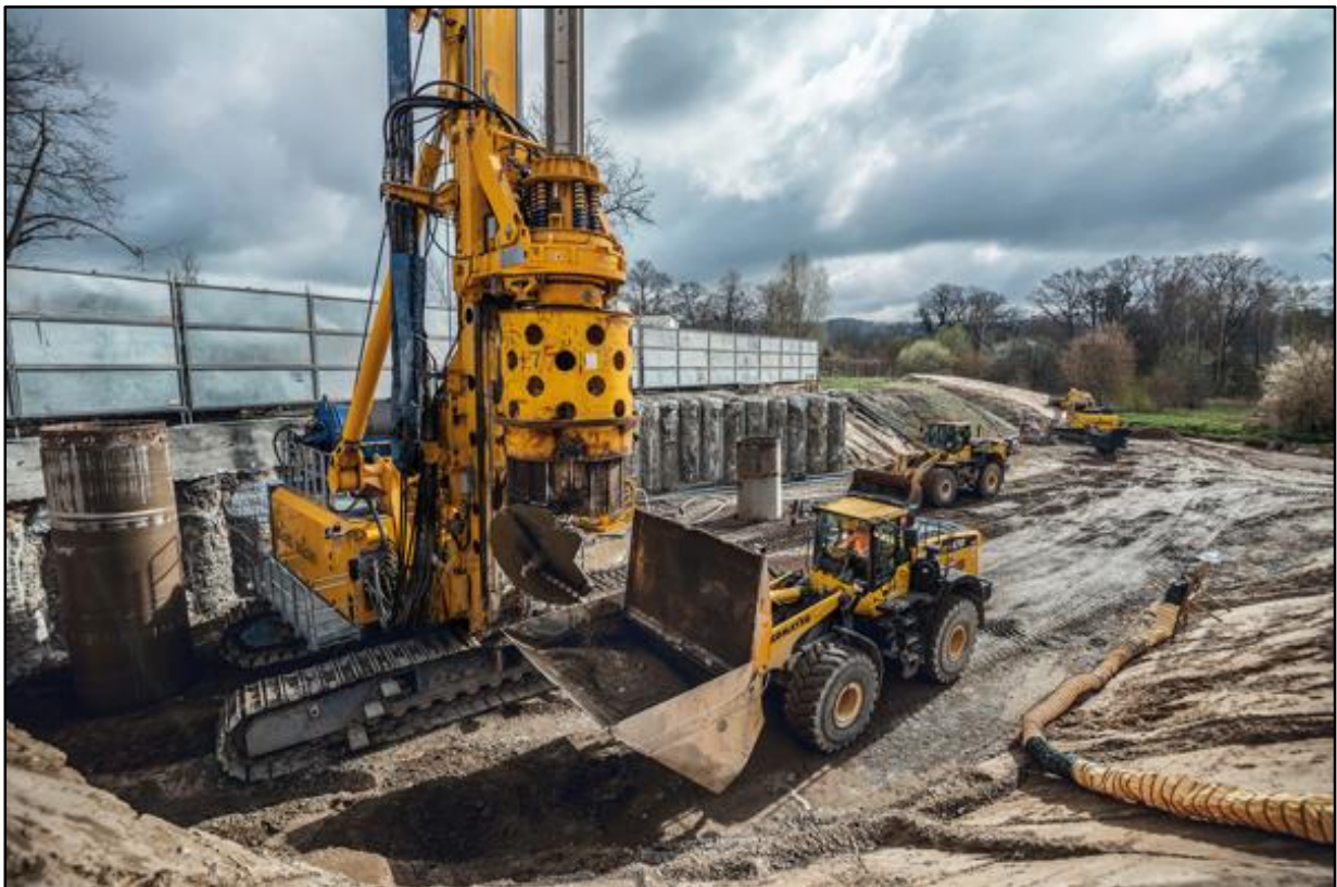
Abb. 6-42 Beispielfoto für eine Sanierung mittels Großbohrungen (Quelle: Bauer)
