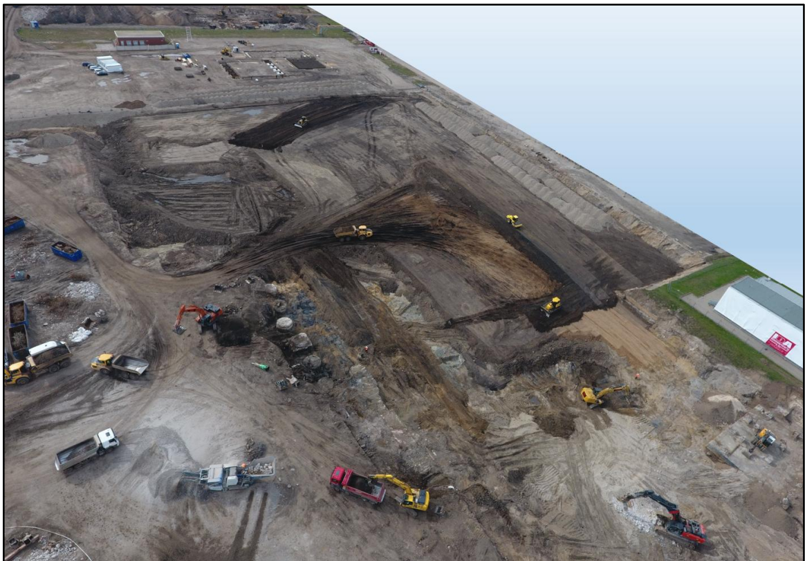
Abb. 7-13 Beispielfoto für eine großräumige Baufeldfreimachung
