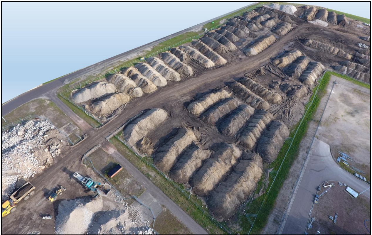
Abb. 7-19 Beispielfoto eines Boden-/Bauschuttlagers mit Aufbereitungsanlage (unten links)
