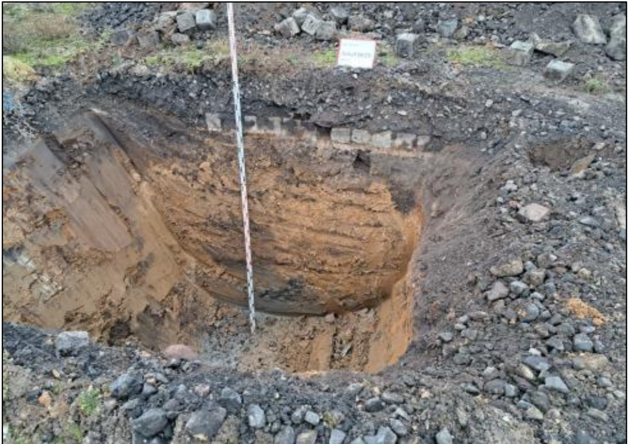
Abb. 7-5 Auffüllung (grau); darunter Geschiebemergel (braun) im Schurf S-04/23 im BF01
