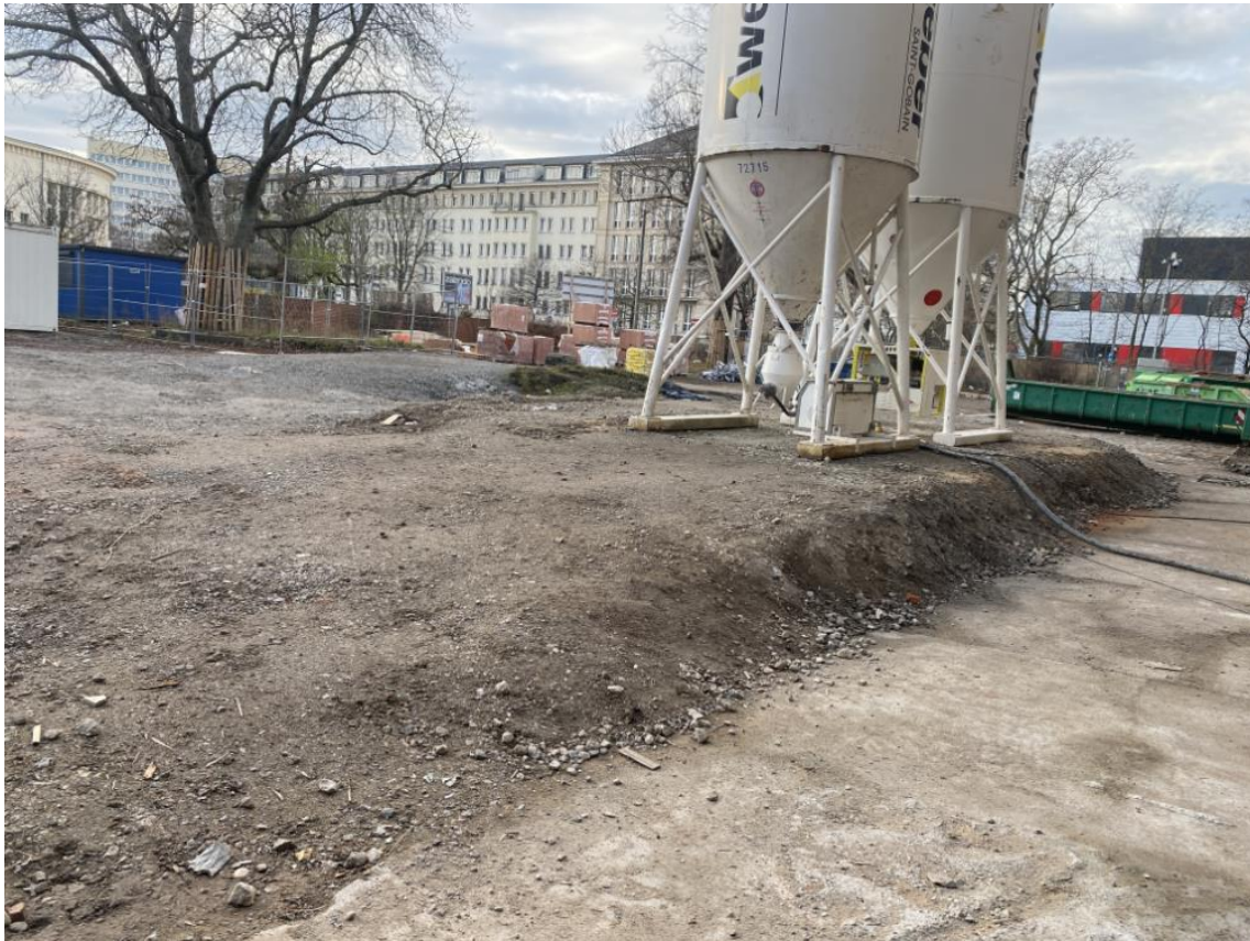
Abbildung 10 bauseits vorh. Recyclat zur Rückverfüllung / Bodenaustausch
