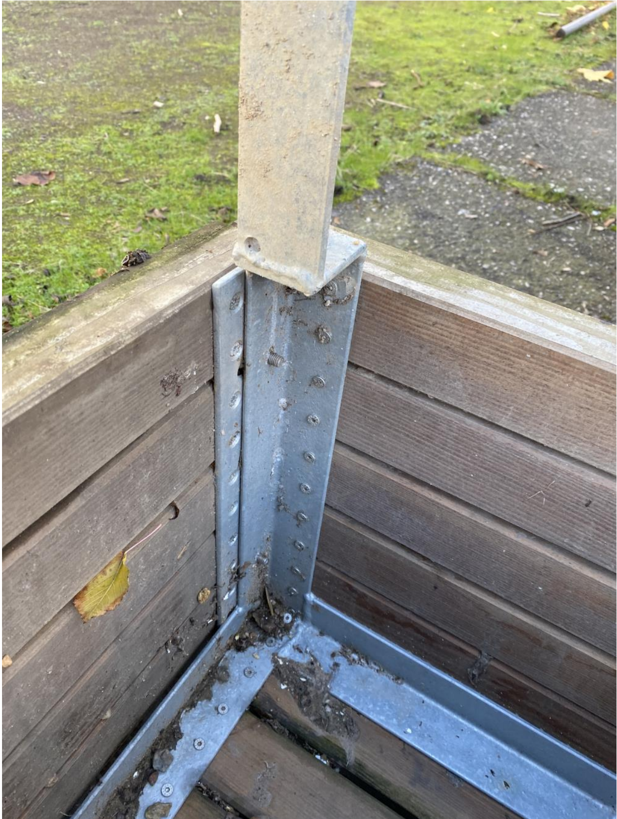
Abbildung 35 vorhandener Sitzwürfel - Unterkonstruktion
