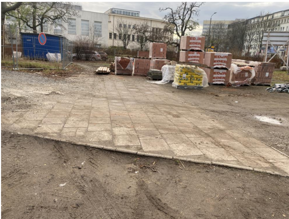
Abbildung 7 Baufeld Schulhof, Betonplatten 40/40/5 und Borde zum Abbruch
