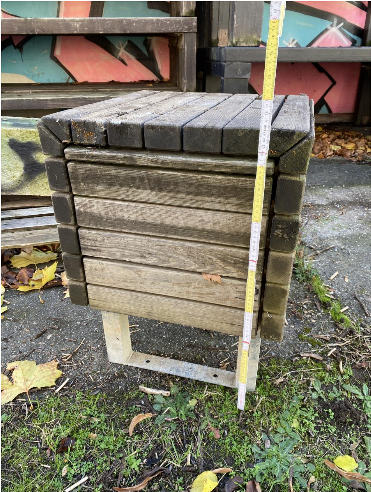
Abbildung 33 vorh. Sitzwürfel - Aufarbeitung / Austausch Verkleidung
