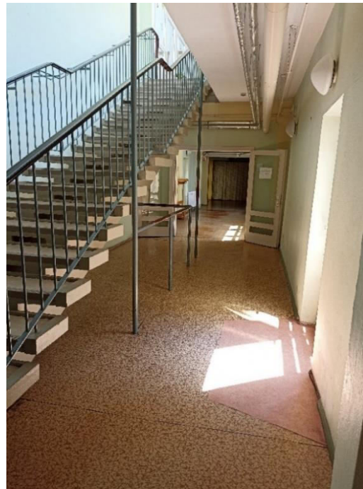
KG Treppe mit Unterlaufschutz Zugang Innenhöfe
