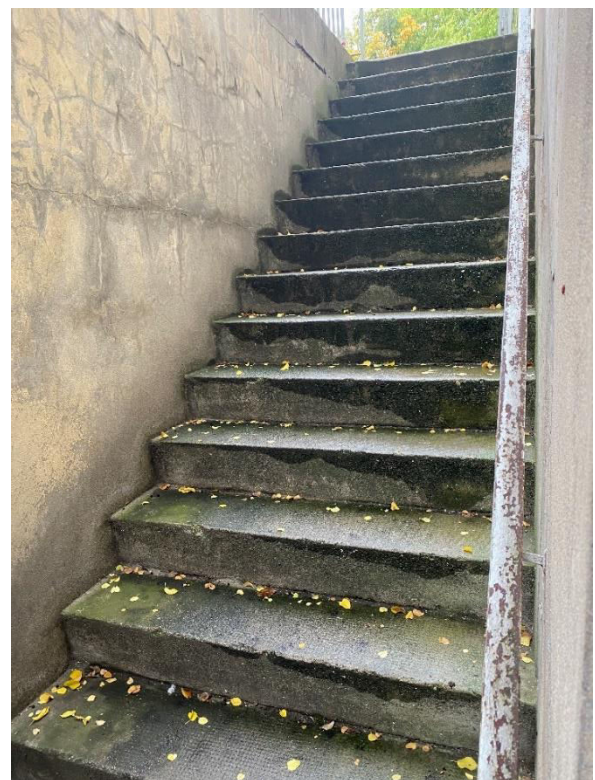
Keller Außentreppe Südfassade
