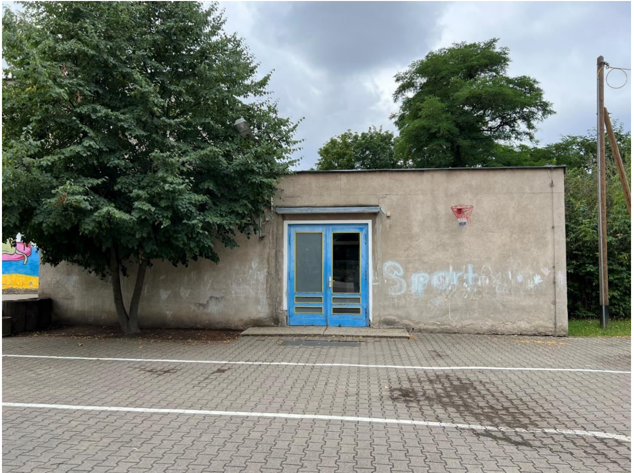
Sporthalle Zugang Ostfassade
