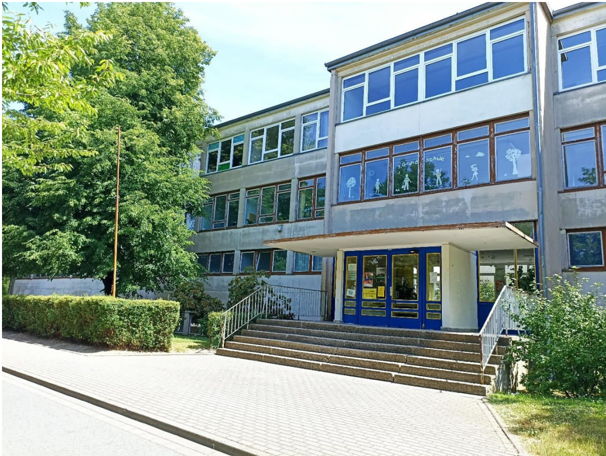
Bisheriger Zugang Schule Nordfassade
