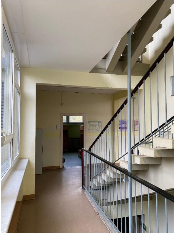
Treppenanlage mit Geländer
