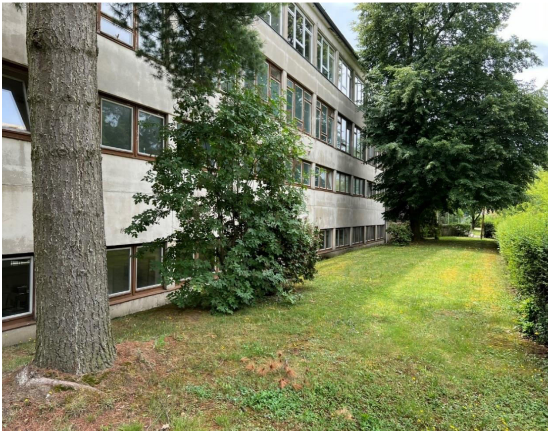
Geländesituation zum Gebäude Nordfassade
