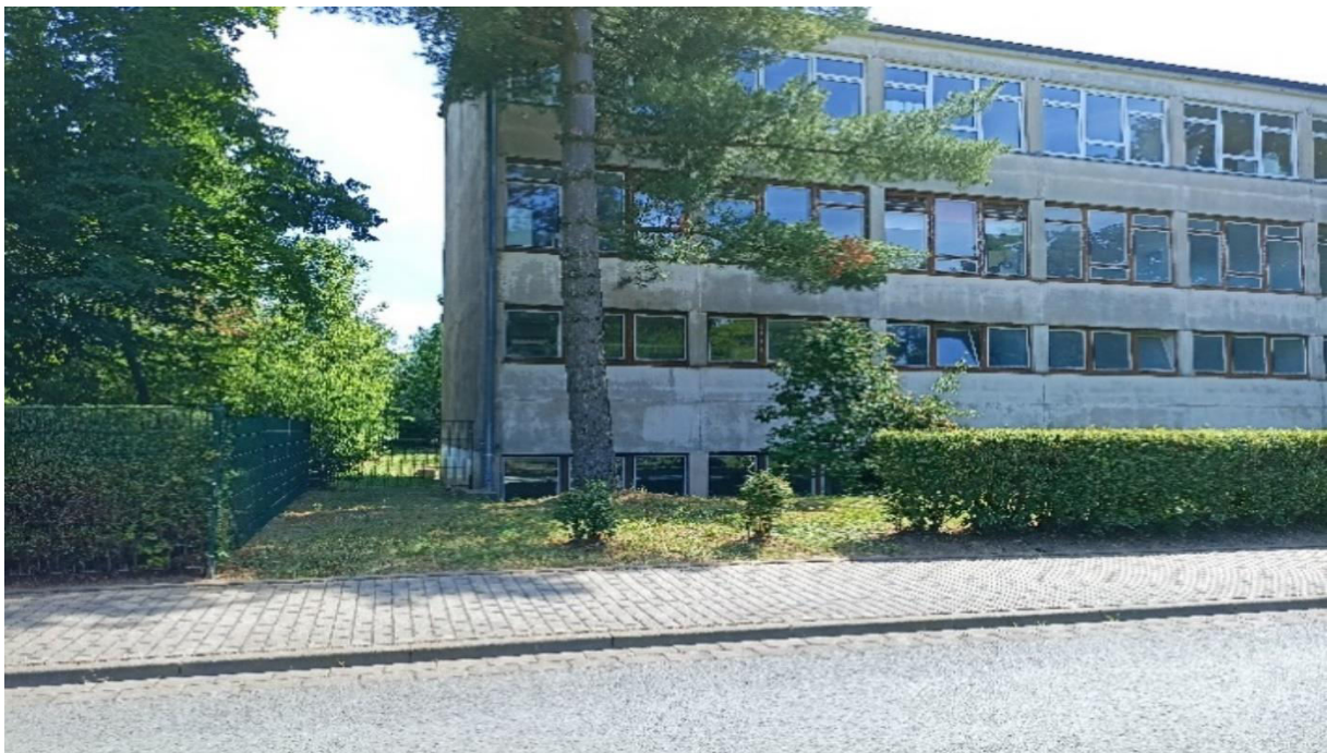
Nordfassade mit 4 Geschossen UG bis 2. OG
