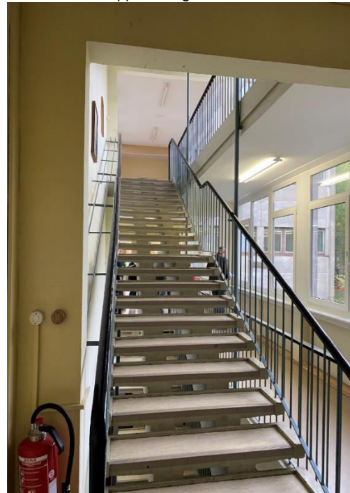
Schule, EG, Treppenanlage
