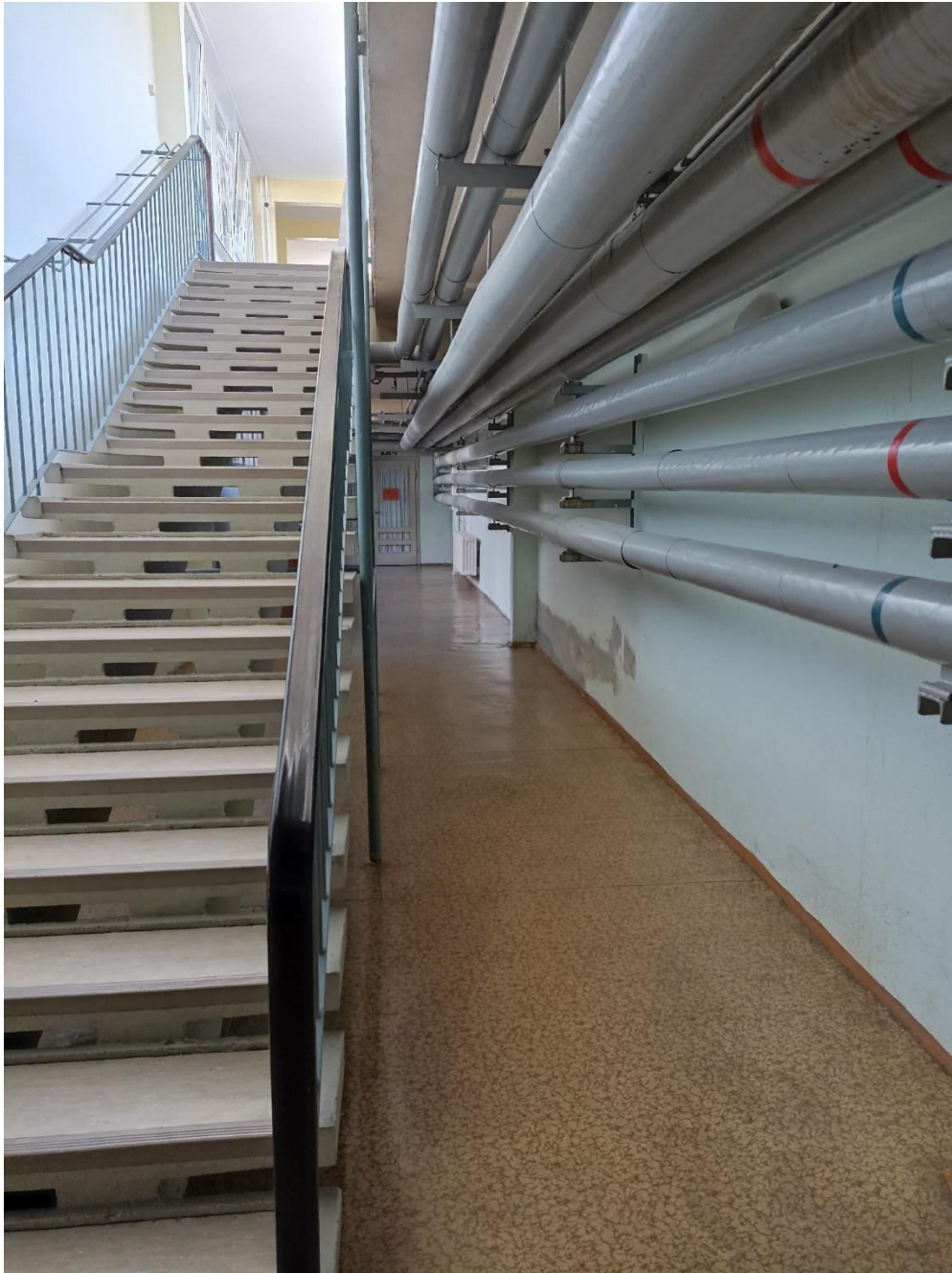
Schulgebäude Kellergeschoss Treppenaufgang
