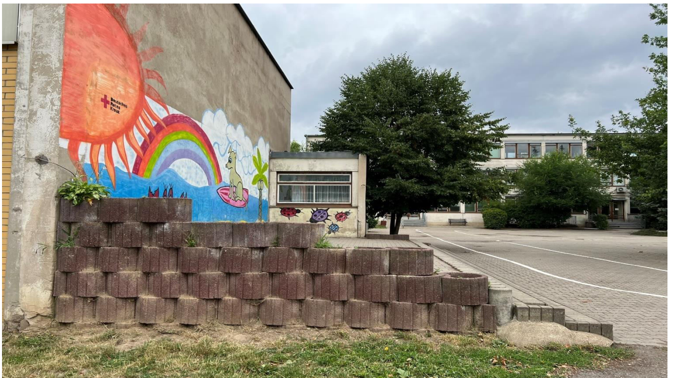
Sporthalle/ Schulhof, Blick von Süden
