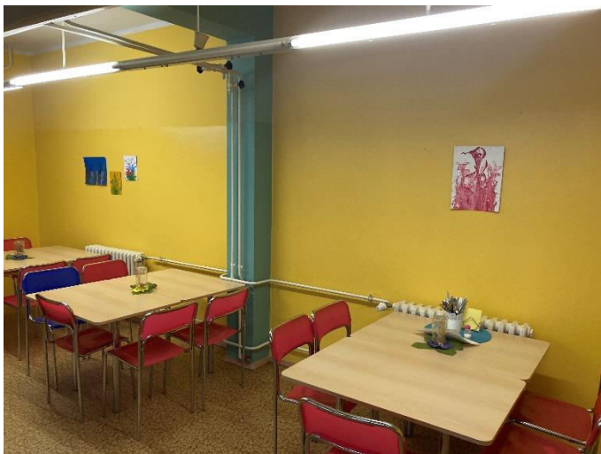
KG Wand Südfassade Speiseraum
