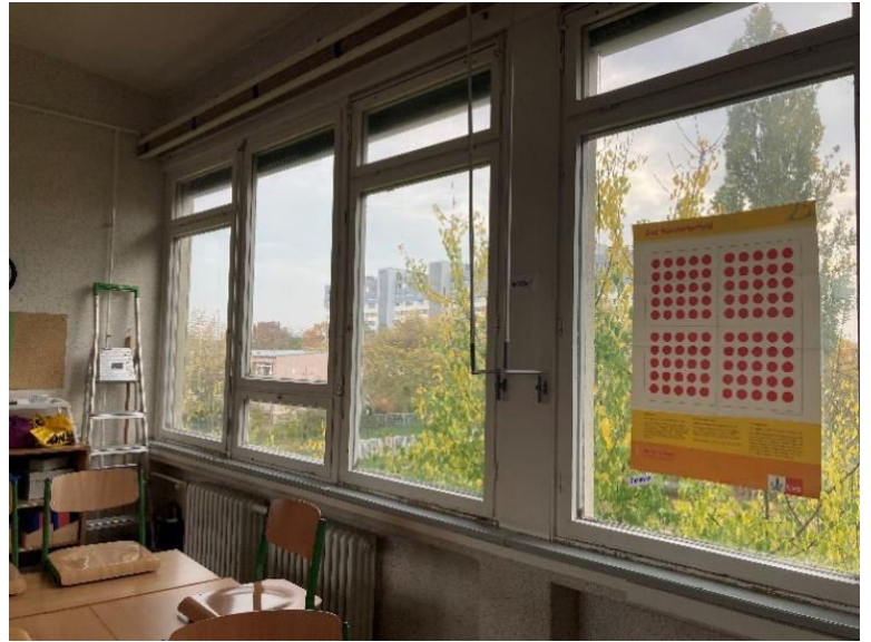
Fenster Hort - Verbund Klassenzimmer, Fenster mit Sonnenschutz
