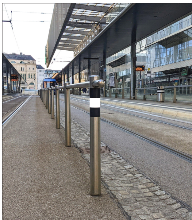
Abbildung 5: Gestaltung von Pollern mit Wechselkontrast
