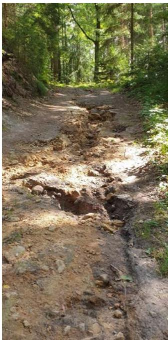
Bild 11: Oberfläche tiefgründig ausgespült
