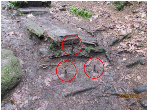
Bild 14: Beispiel für alte zu beräumende Stahlstichel
