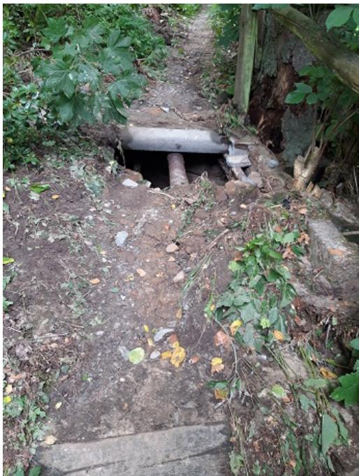
Bild 9: Ausspülung mit Einbruchsstelle
