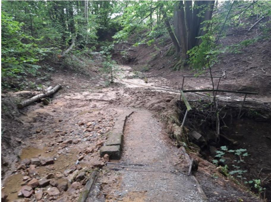
Bild 4: Ablagerungen aus Überströmung des Weges
