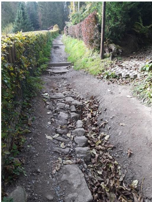
Bild 7: Oberfläche tiefgründig ausgespült
