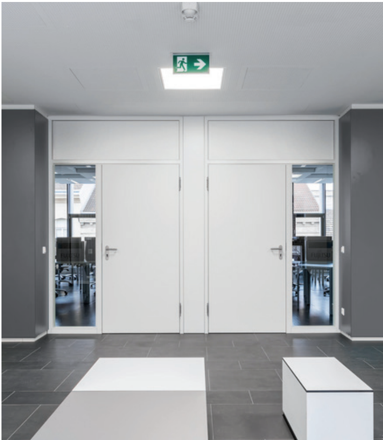
Beispiel Innenraumtür mit Stahlumfassungszarge und seitlicher Festverglasung, Türblatt hell
