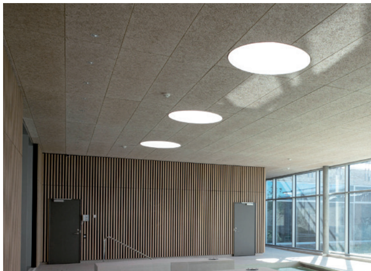
Beispiel 1 Akustikdecke Holzwohle-Akustikplatte
