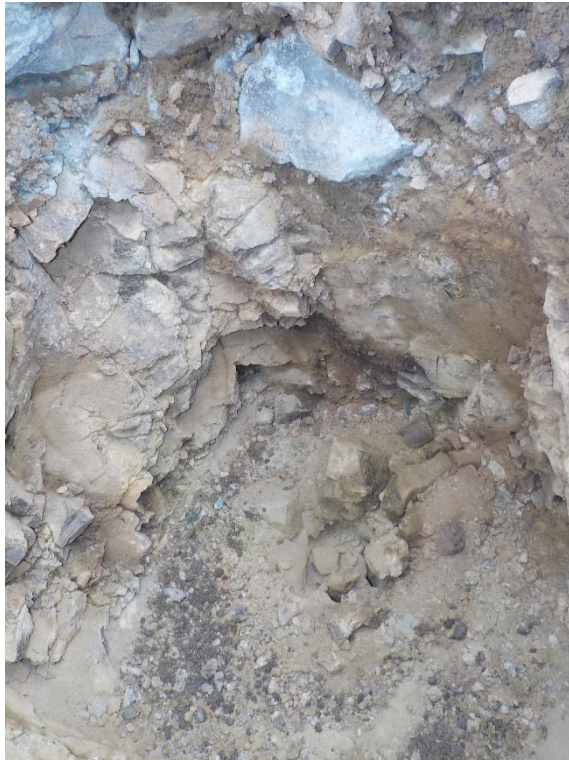
Abb. 7: HS 2, Detailansicht Packlager & Auffüllung
