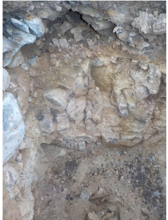
Abb. 8: HS 2, Detailansicht Packlager & Auffüllung
