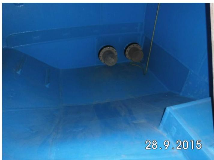
Abb. 20: Beispiel Auskleidung Tiefpunkt Sohle
