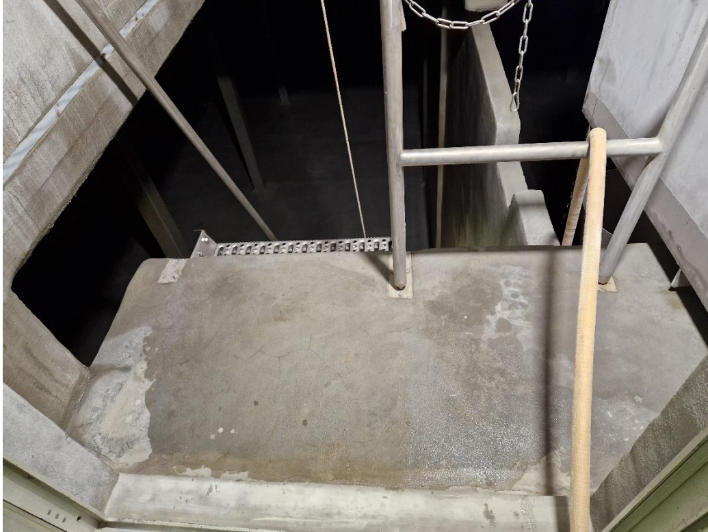
Abb. 10: Zugang zur Wasserkammer über Fenster
