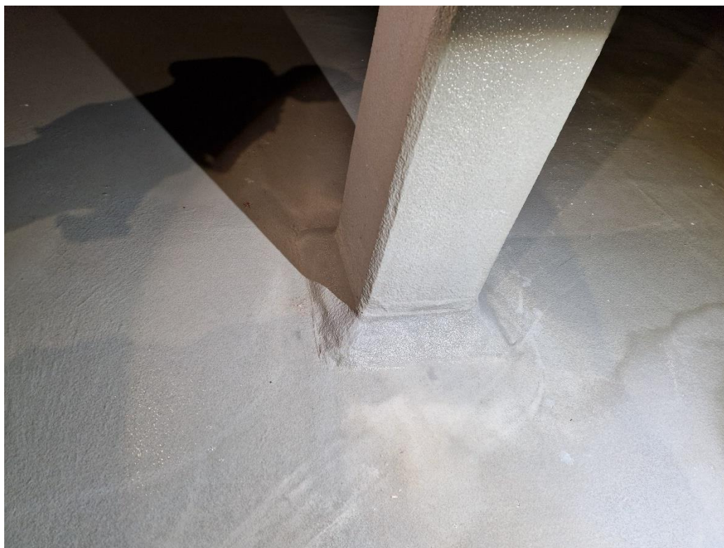
Abb. 16: Übergang Stütze - Sohle
