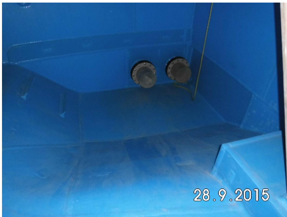
Abb. 31: Beispiel Auskleidung Tiefpunkt Sohle
