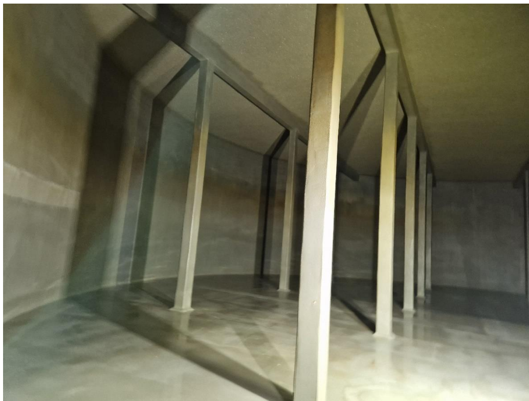
Abb. 15: Behälterinnenraum (linke Wasserkammerkammer mit 8 Stützen)
