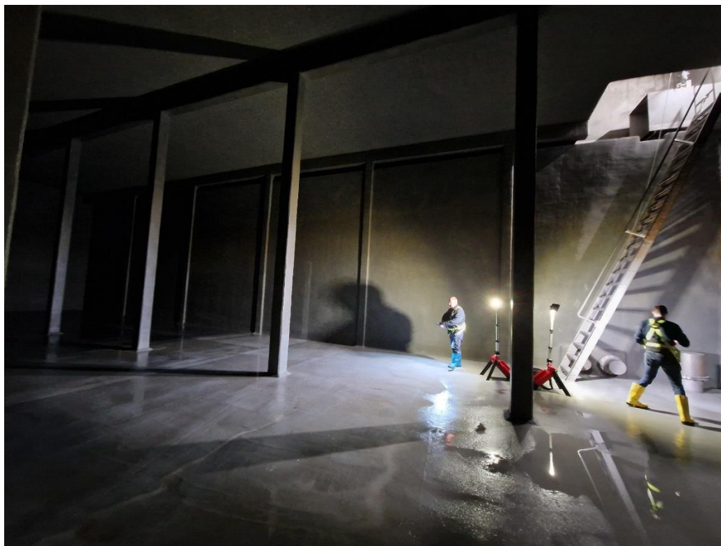
Abb. 13: Behälterinnenraum (linke Wasserkammer mit Leitertreppe und Trennwand)
