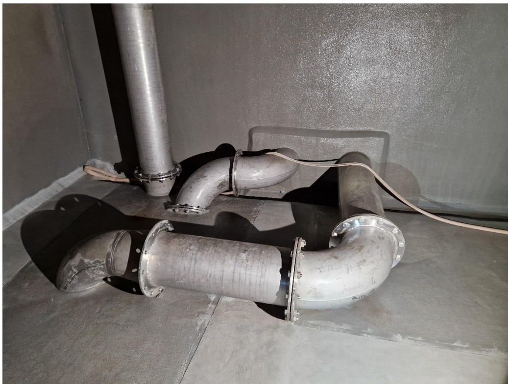
Abb. 20: Entnahme (2x Durchführung durch Trennwand – rechte Wasserkammer)
