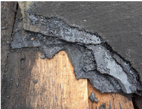
Abbildung 6.1.9: Vergleich des Dachaufbaus, Außenansicht: links der Bereich der Altgebäude: unter mehreren Schichten Dachpappe ist ein Dachstuhl aus Holz verbaut (vgl. Abbildung 6.1.8), teilweise wurden auch HWL-Platten eingebaut (vgl. Abbildung 6.1.3 rechts oben) rechts der Bereich Neubau: auch hier wurden mehrere Lagen Dachpappe verbaut, darunter Betonplatten (siehe auch Abbildung 6.1.6)
