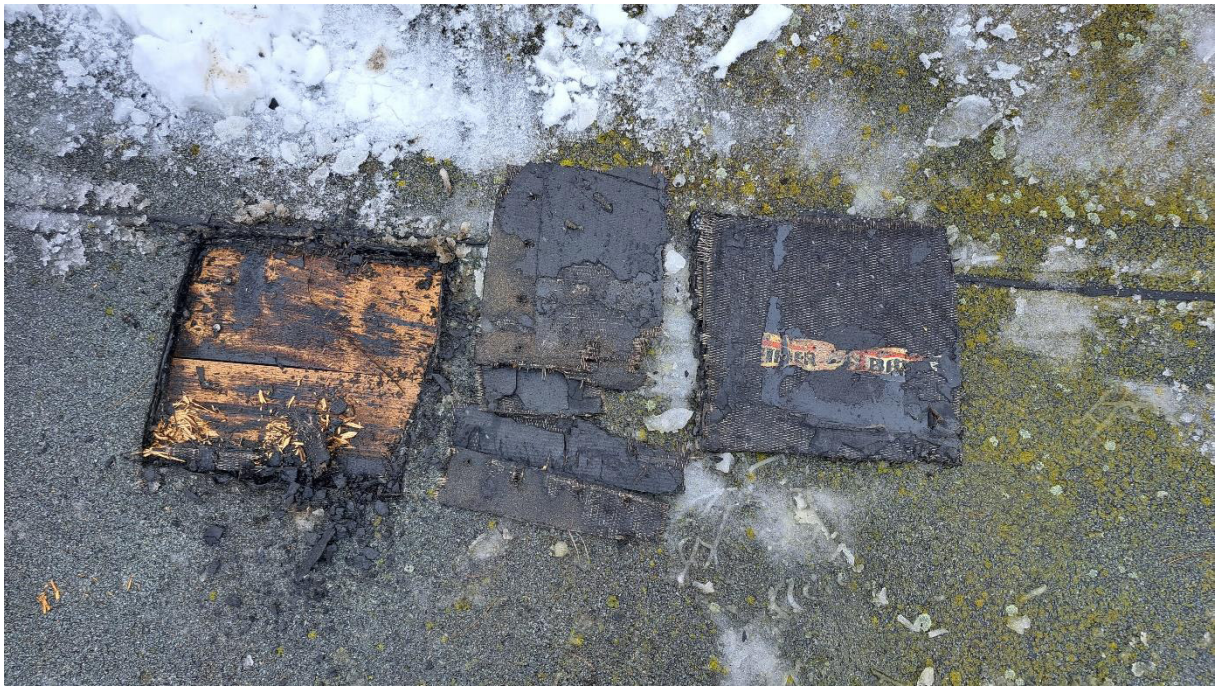
Abbildung 6.2.7: Dachaufbau, außen: auf der Holzlattung sind mehrere Schichten Dachpappe verbaut
