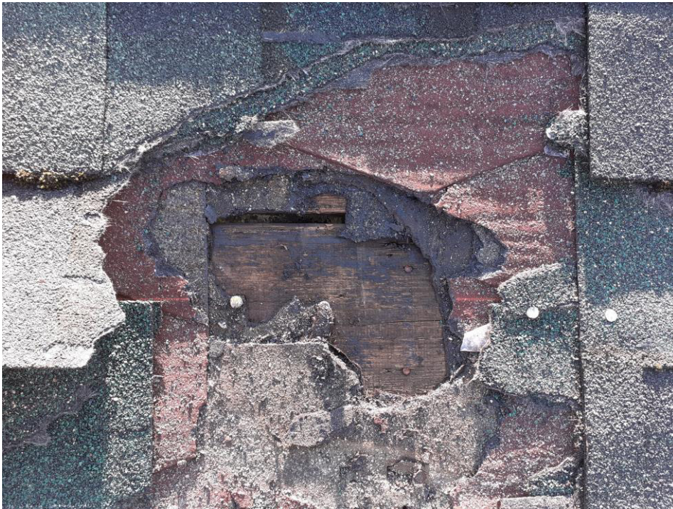
Abbildung 6.3.9: Dachaufbau Ofenhaus, außen: mehrere Lagen Dachpappe auf Holzlattung
