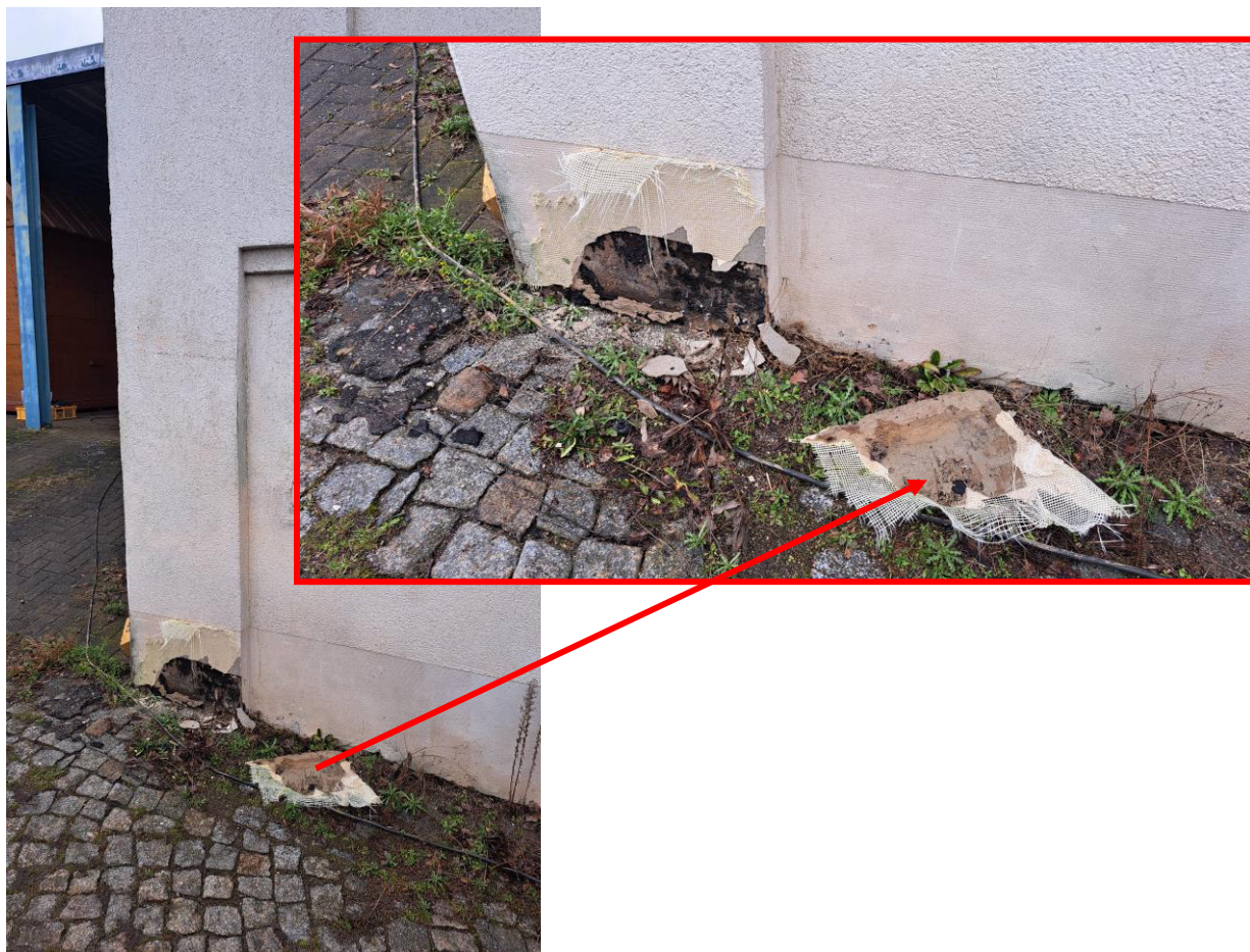
Abbildung 6.3.7: Entlang der Außenwand ist Unterputz eine Gaze verlegt
