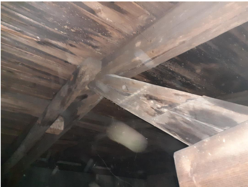
Abbildung 6.3.10: Dachaufbau, Kohlebunker innen: Dachstuhl aus Holz, ohne Dämmung
