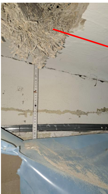
Abbildung 6.2.6: Dachaufbau, innen (Forts.): oberhalb der KMF-Dämmung (siehe vorherige Abbildung) sind HWL-Platten verlegt, anschließend folgt die Außenhaut mit Holzlatten
