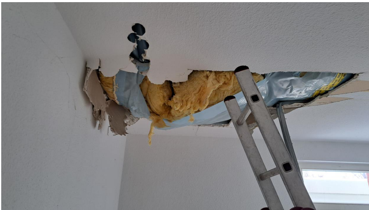
Abbildung 6.2.5: Dachaufbau, innen: hinter Gipskarton ist eine Folie verlegt, dahinter KMF
