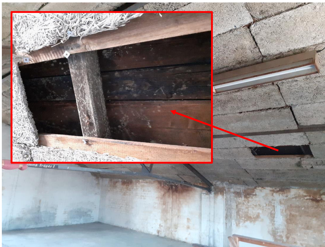
Abbildung 6.3.8: Dachaufbau Ofenhaus, innen: großflächig verlegte HWL-Platten, dahinter Holzlatten als Dachaußenbau
