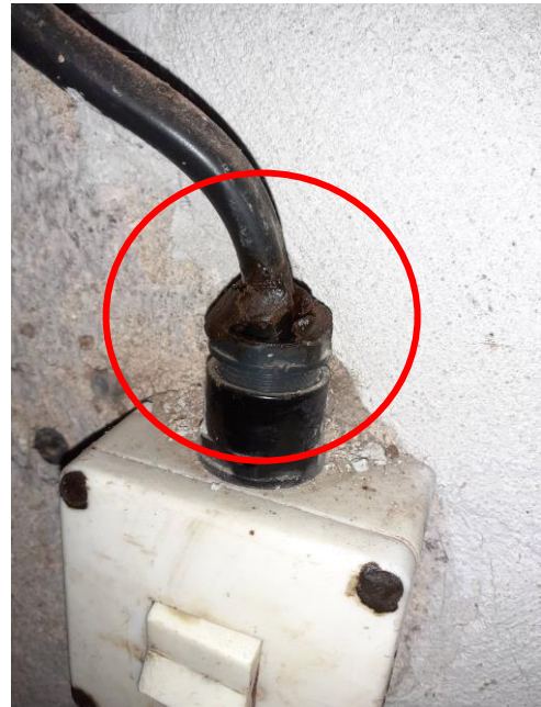
Abbildung 6.1.10: An mehreren Stellen wurde an den Elektroinstallationen asbesthaltiger Kabelkitt verbaut. Dieser ist gemäß den Vorgaben der TRGS 519 zu entfernen und zu entsorgen.
