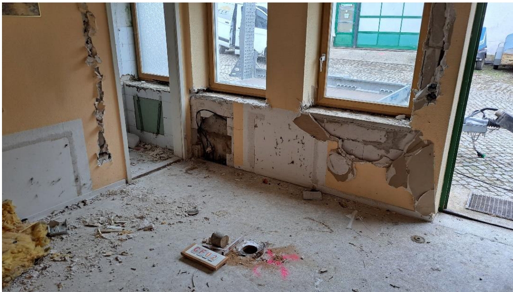
Abbildung 6.1.5: Innenraum Neubau mit Aufbau Außenwand: Gipskarton, dahinter Gasbetonsteine
