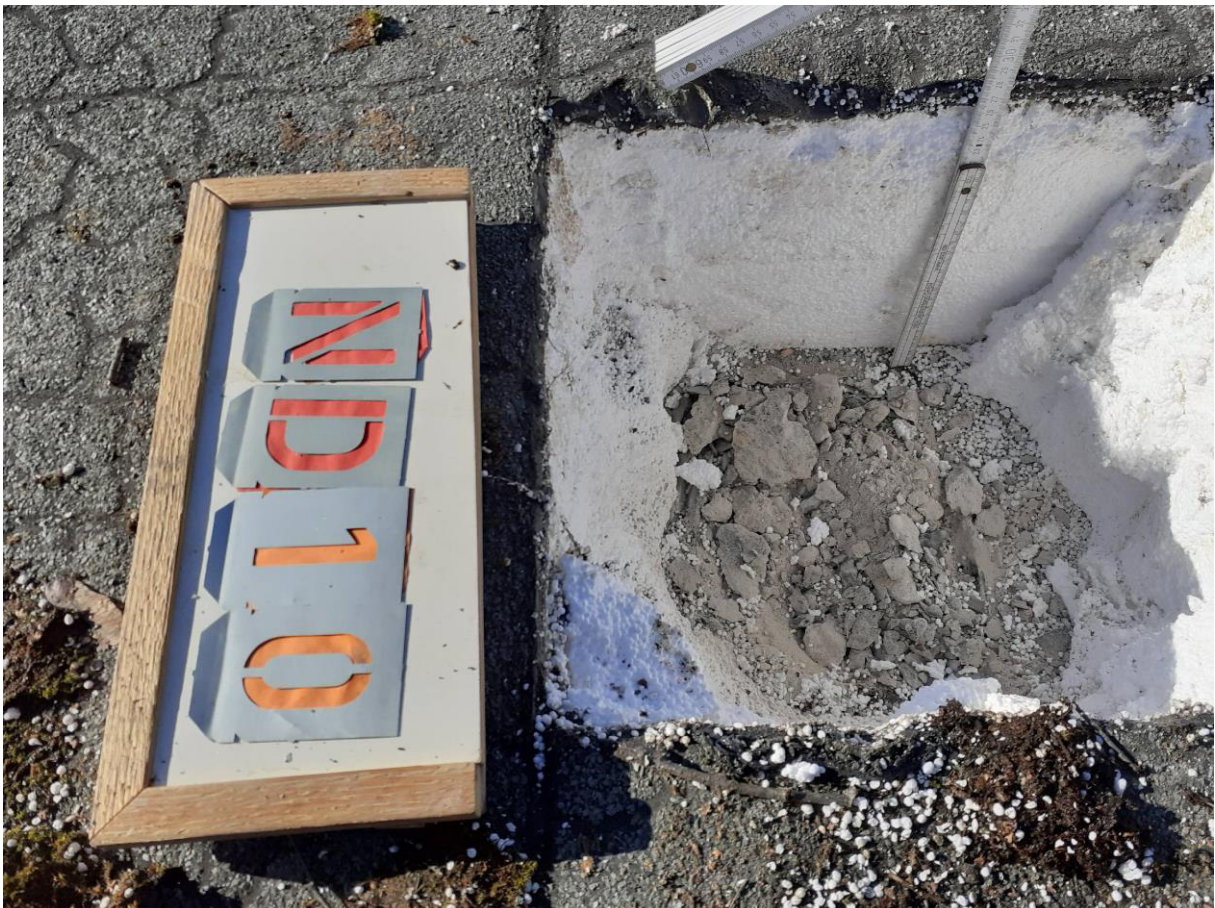
Abbildung 6.4.10: Aufbau Dach Schulungshaus: unter mehreren Lagen Dachpappe sind 25 cm Polystyrol als Dämmung verbaut, darunter folgt Beton
