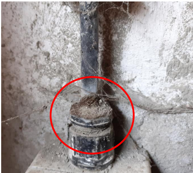
Abbildung 6.1.10: An mehreren Stellen wurde an den Elektroinstallationen asbesthaltiger Kabelkitt verbaut. Dieser ist gemäß den Vorgaben der TRGS 519 zu entfernen und zu entsorgen.
