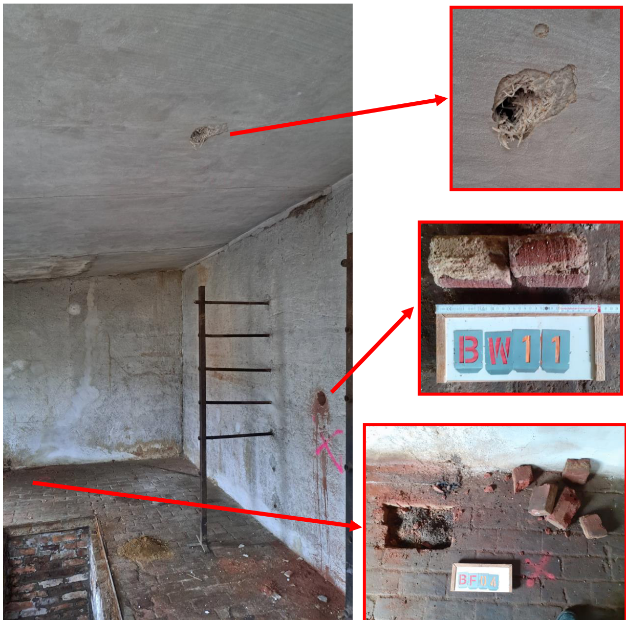
Abbildung 6.1.3: Rohrlager, Blickrichtung Norden: zu erkennen die Reparaturgrube (links im Bild) sowie der Deckenaufbau (Oben; hier mit HWL-Platten), der Aufbau zur Rückwand (Mitte; Ziegel mit Putz) und der Fußboden (Unten; unter gesetzten Ziegeln befindet sich eine Schicht aus Sand mit Beimengungen von Schlacke)
