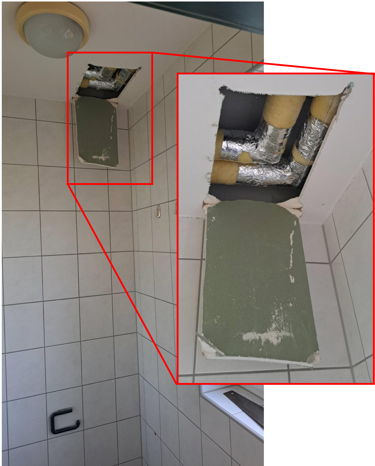
Abbildung 6.4.7: Deckenaufbau Schulungshaus, EG Sanitärbereich: abgehangene Decke mit Gipskartonplatten, Rohrisolierung wie im Bereich Küche (vgl. Abbildung 6.4.6)
