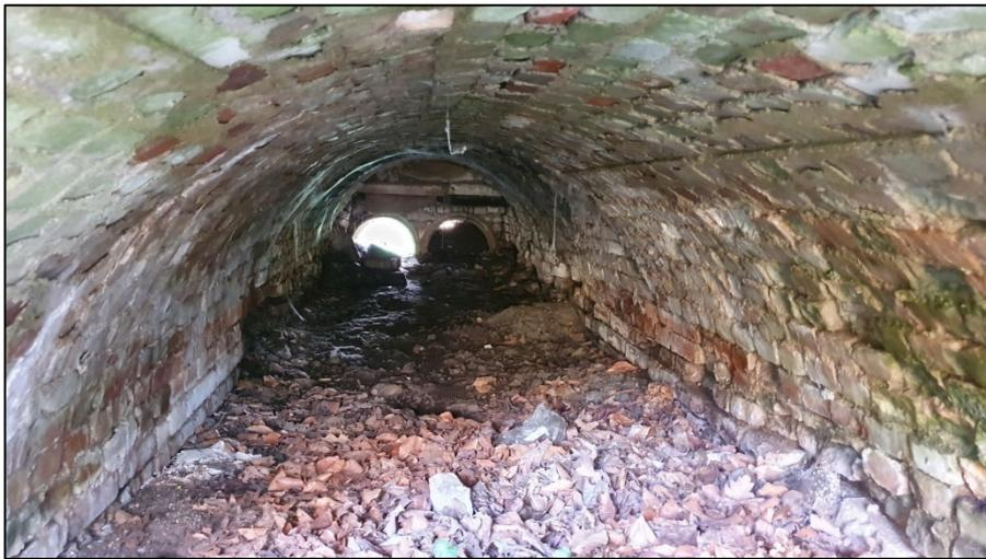
Der vorhandene Durchlass ist ein Gewölbemauerwerk das überwiegend aus Kalksandstein und Ziegel hergestellt ist. Die lichte Öffnung beträgt 1,94 x 0,88 m. Die hydraulisch verfügbare Fläche 1,7 m<sup>2</sup>.
