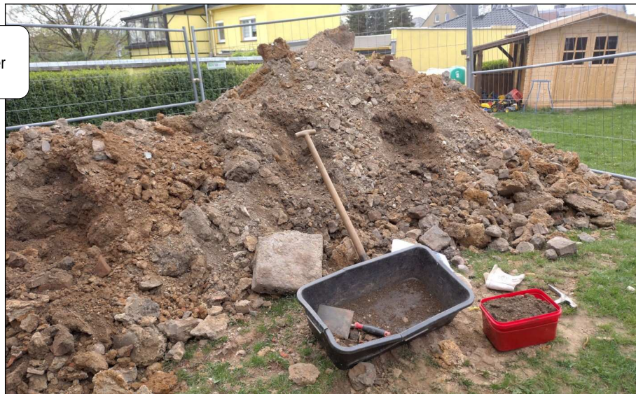
Abb. 1: Seitlich abgelegter Aushub der Grabenöffnung, 10.04.2024
