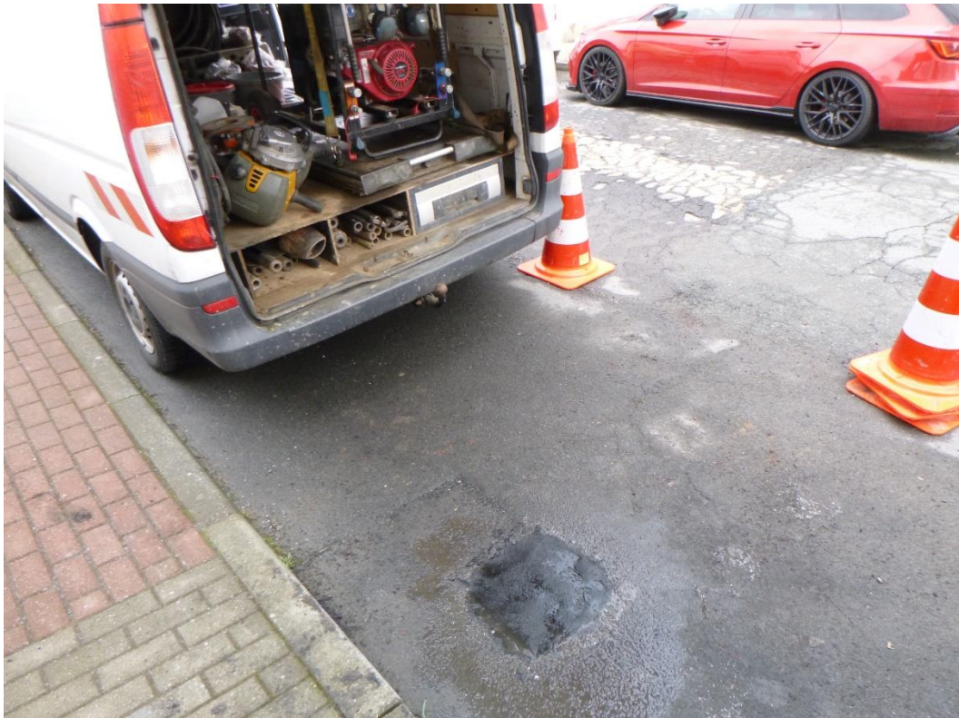
Bild 6 | 14.03.2024 Baugrunduntersuchung | Verschluss A/RKS 102
